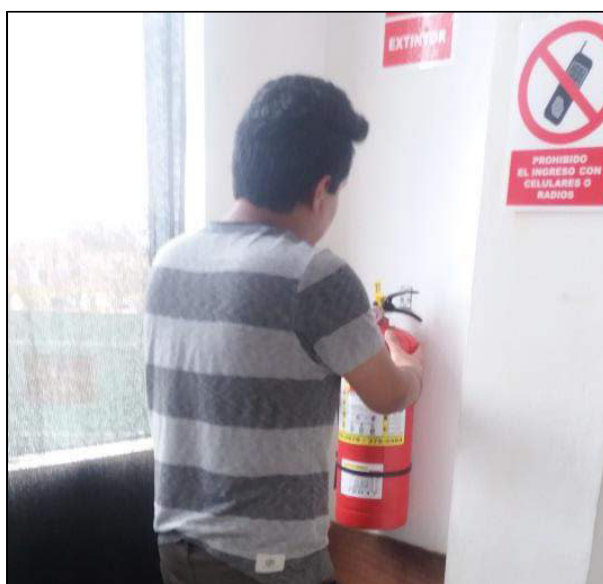
Figura 184. Instalación extintor CO2 en almacén de materias primas
