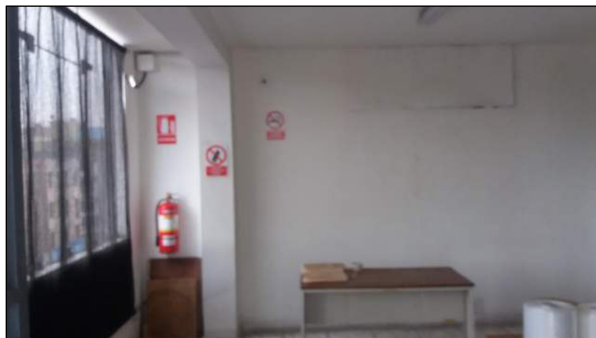
Figura 186. Almacén de materias primas - después
