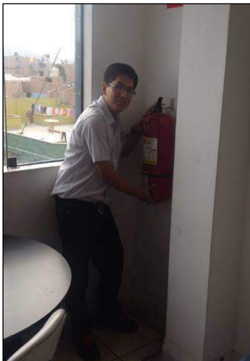
Figura 185. Instalación extintor PQS en área de producción
