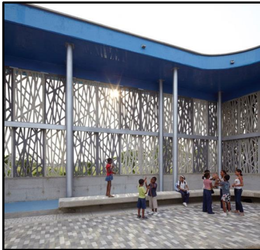
Fotografía 04: Vista de membrana desde adentro Fuente: www.plataformaarquitectura.com
