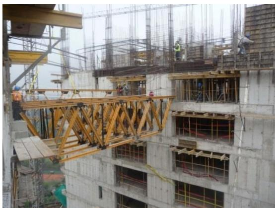
**Fotografía 1: Montaje de Plataformas Intermedias**
