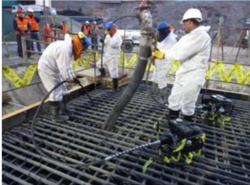
**Fotografía 12: Vibración del concreto**
