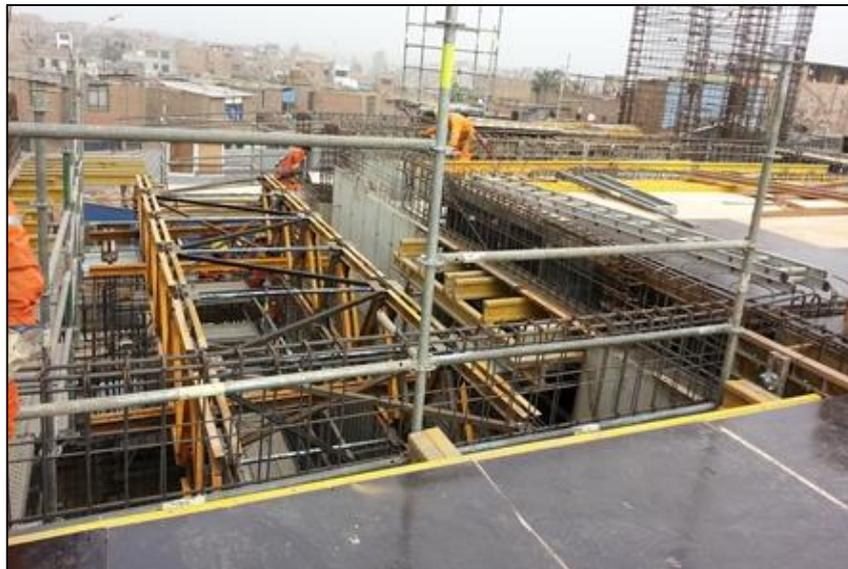
Figura 56: Encofrado de fondo de Losa
