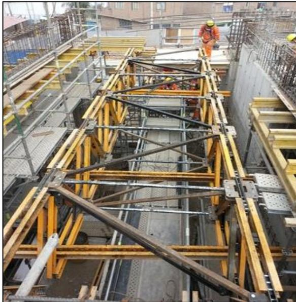
Figura 55: Encofrado de fondo de Losa
