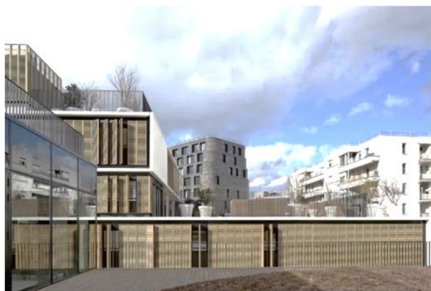
Figura 36. Vista frente oeste planta baja general
