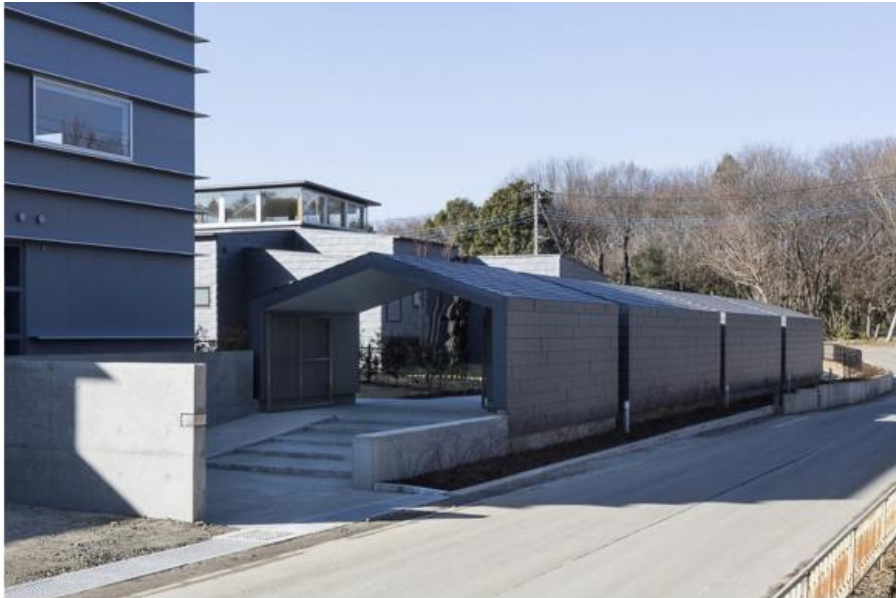
Figura 61. Vista fachada ingreso principal
