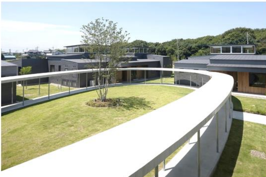
Figura 62. Vista aérea corredor elipsoidal
