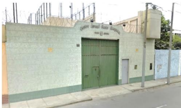
Figura 11. Vista ingreso principal Casa Hogar Santa Margarita
