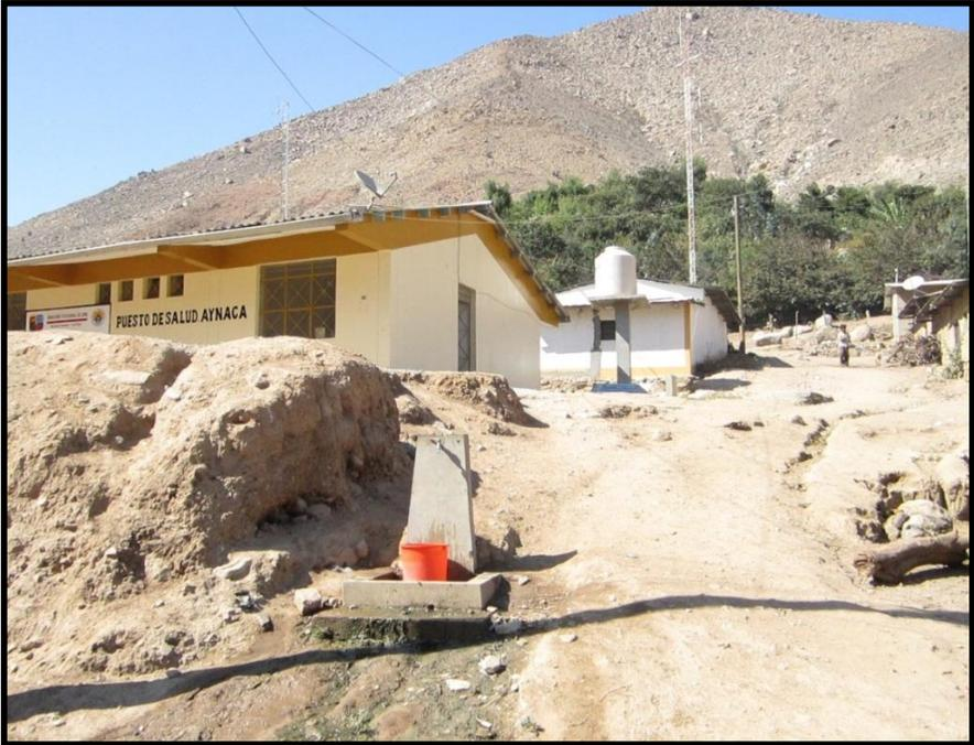
Foto N°1: Pileta de agua potable por gravedad sin tratamiento.
