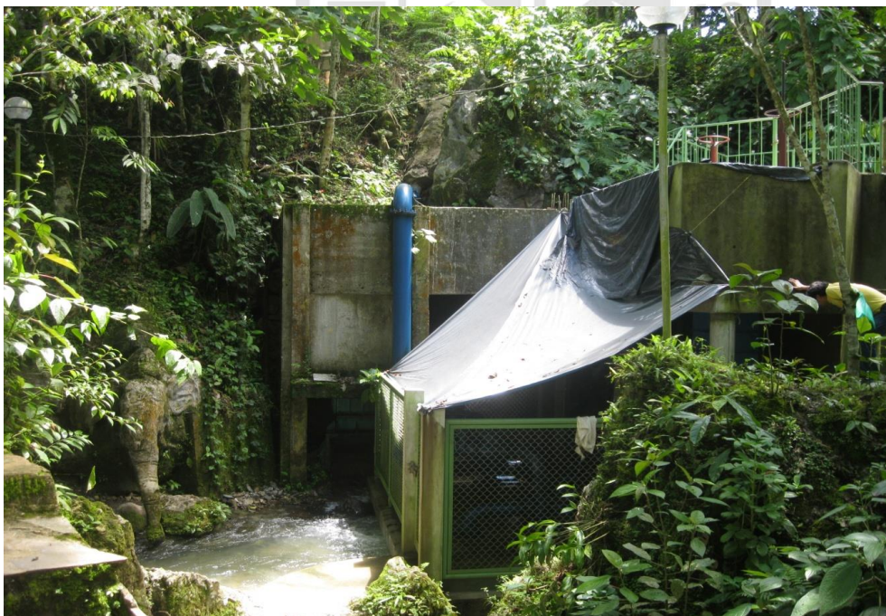
Represa hidroeléctrica de Tioyacu
