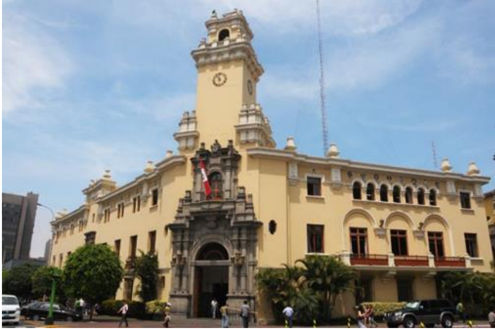
Fachada de ingreso principal
