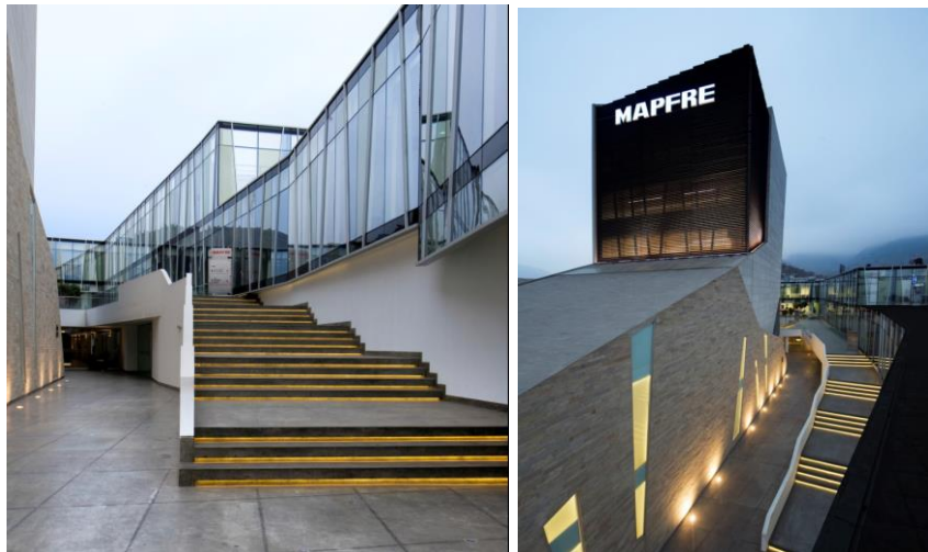
Figura 8. Vistas Interna del encuentro entre edificaciones
