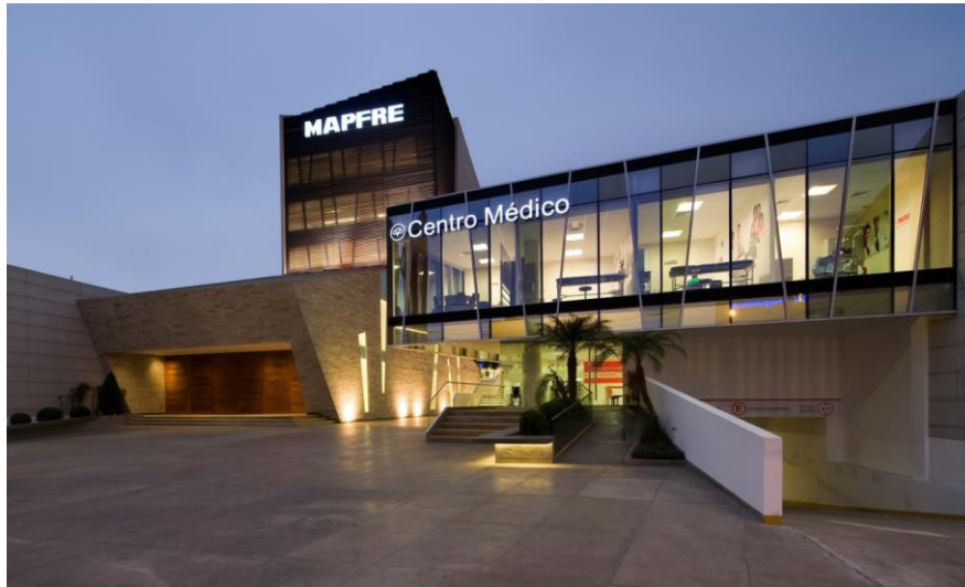
Figura 6. Vista Elevación Principal Centro de Atención Integral MAPFRE
