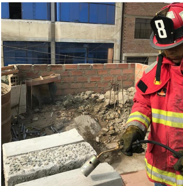
Figura 63. Exposición de vigas
