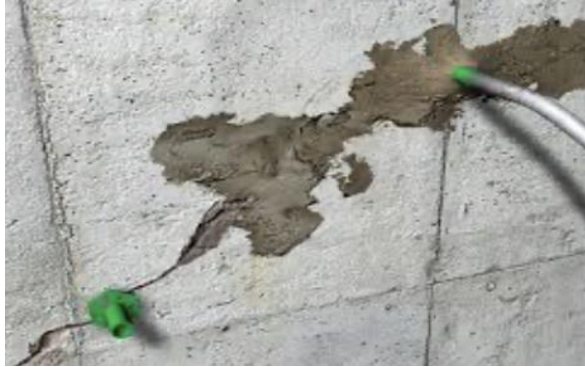
Figura 21. Aplicación de resina epóxica en grietas
