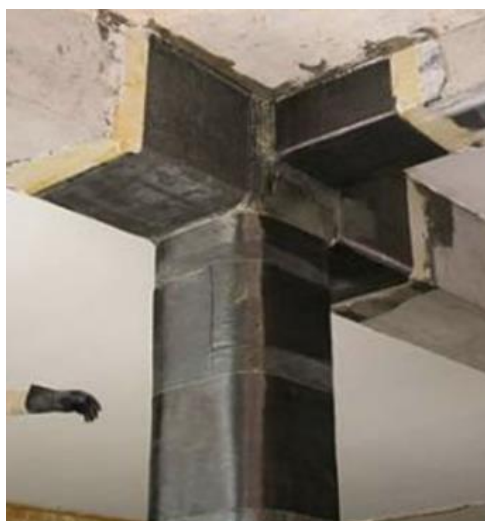
Figura 23. Reforzamiento de estructura con fibra de carbono
