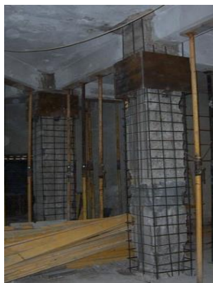
Figura 22. Encamisado de columna
