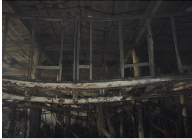
Figura 12. Alargamiento de los elementos estructurales
