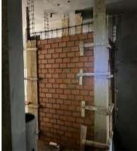
**Figura 46 :** Asentado de ladrillo del Sotano 01 .
