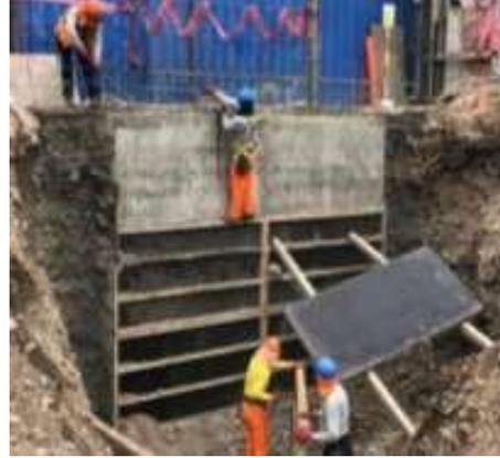
**Figura 36:** Desencofrado de muro anclado.
