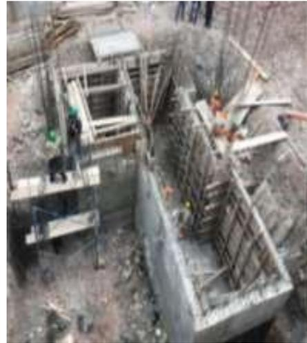
**Figura 45 :** Vaciado de cisterna.
