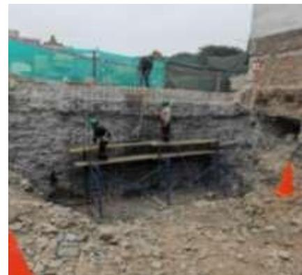
**Figura 34:** Colocacion de acero de muro anclado.
