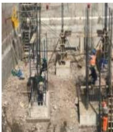
**Figura 39:** Colocación de acero de columnas.
