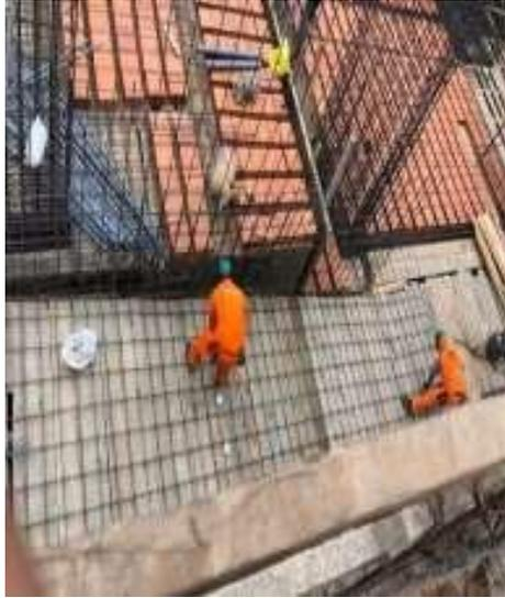
**Figura 42:** Colocación de acero de Losa Aligerada
