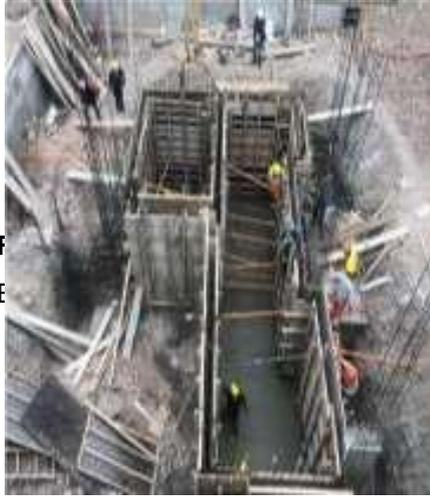
**Figura 44 :** Vaciado de cisterna.
