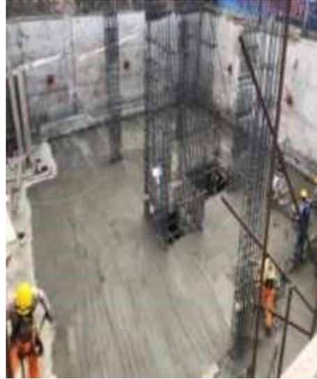
**Figura 43:** Vaciado de Losa Aligerada.
