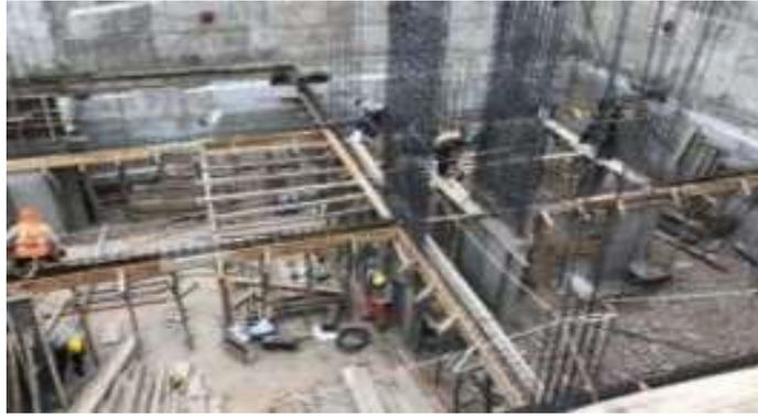
**Figura 41:** Colocacion de vigas.
