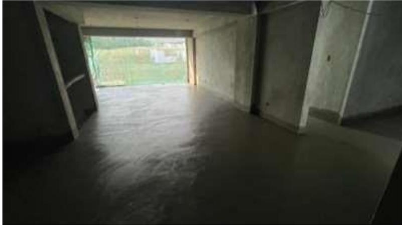
**Figura 50:** Vaciado de contrapiso.
