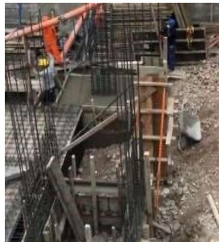
**Figura 38:** Vaciado de zapatas .
