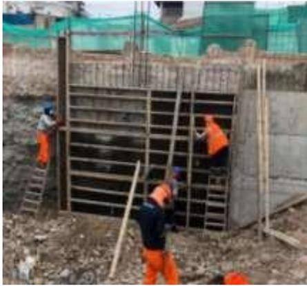
**Figura 35:** Encofrado de muro anclado.
