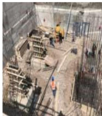
**Figura 40:** Encofrado de columnas.
