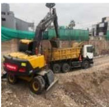
**Figura 31:** Eliminación de tierra con maquinaria.
