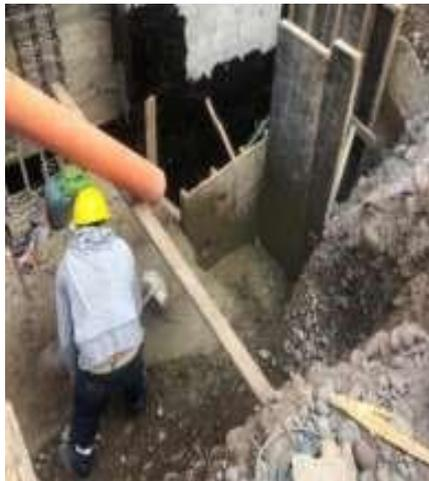
**Figura 37:** Vaciado de solado de zapatas.
