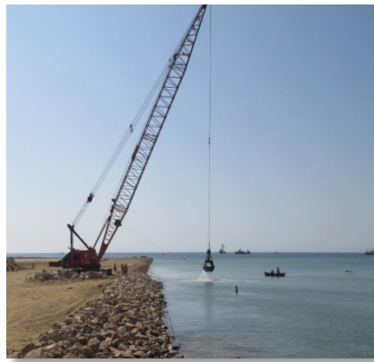
Fig. 26 Enrocado con grúa y clam Shell.
