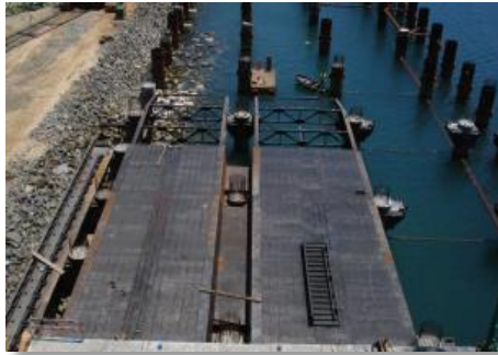
Fig. 85. Encofrado móvil -cimbra
