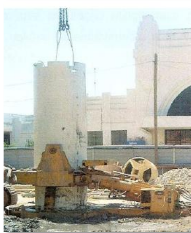
Fig. 16 Camisa metálica sujeta a cabezal adaptado a perforadora
