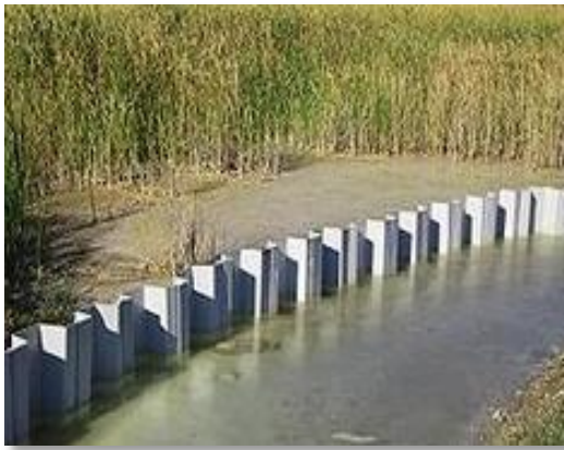
Fig. 47 Tablestacas para protección de riberas de ríos
