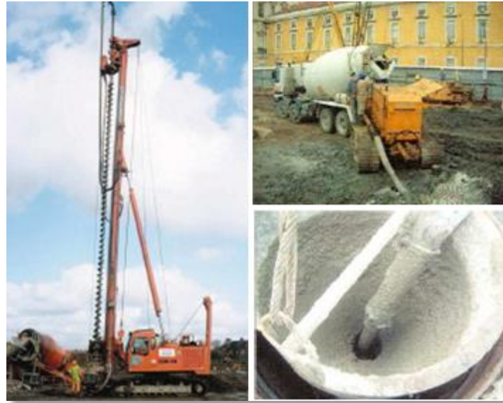
Fig. 14 Vaciado de concreto con bomba directa y con tubo tremie
