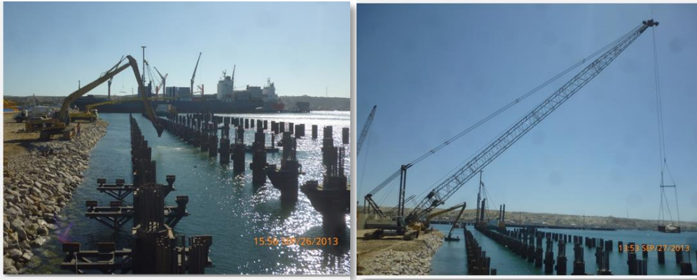
Fig. 81. Enrocado con grúa y excavadora de brazo largo
