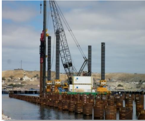
Fig. 82 Hincado de pilote
