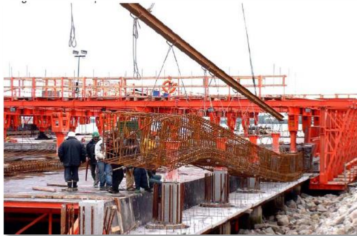
Fig. 31 Colocación de acero para vigas sobre cimbra
