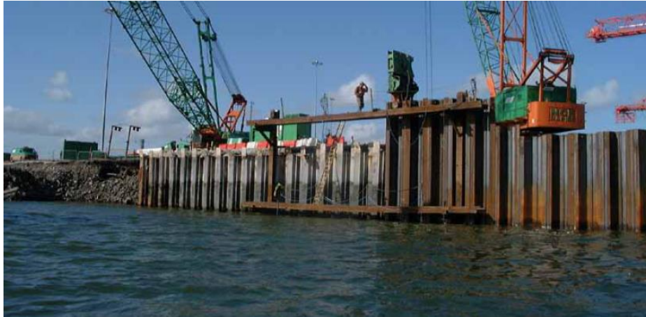
Fig. 50 Tablestacas para contención de enrocado
