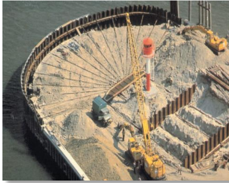
Fig 35 Construcción de ensecadera con tablestacas
