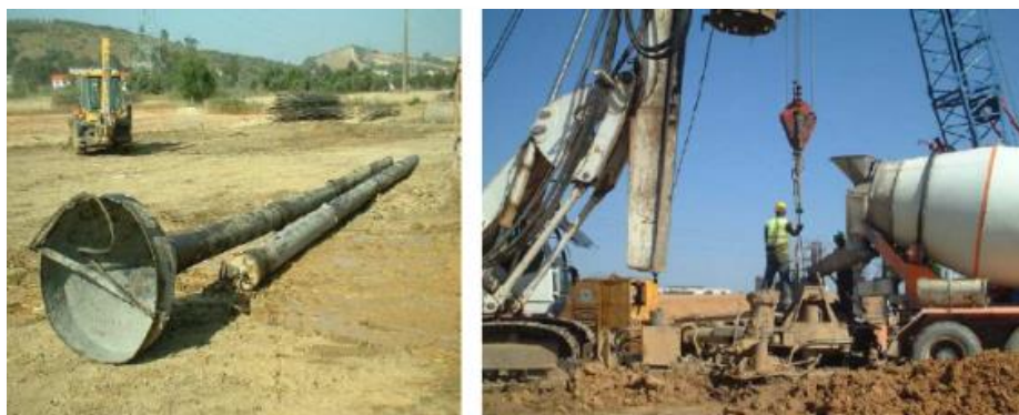
Fig. 20 Vaciado de pilote moldeado con tubo tremie
