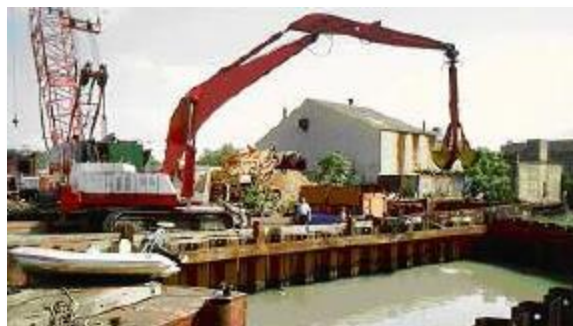
Fig. 55 Eliminación de material con Clam Shell, en interior de tablestacas
