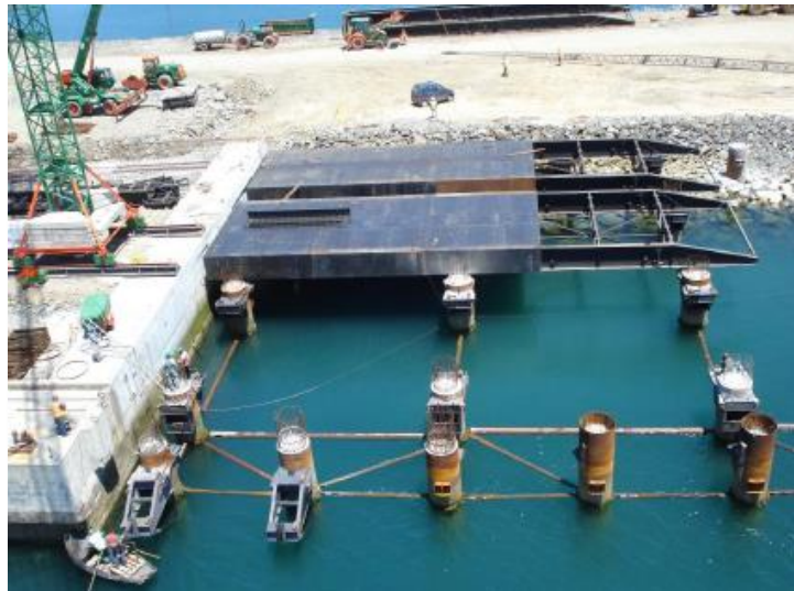
Fig. 72 Encofrado de losa con Cimbra móvil
