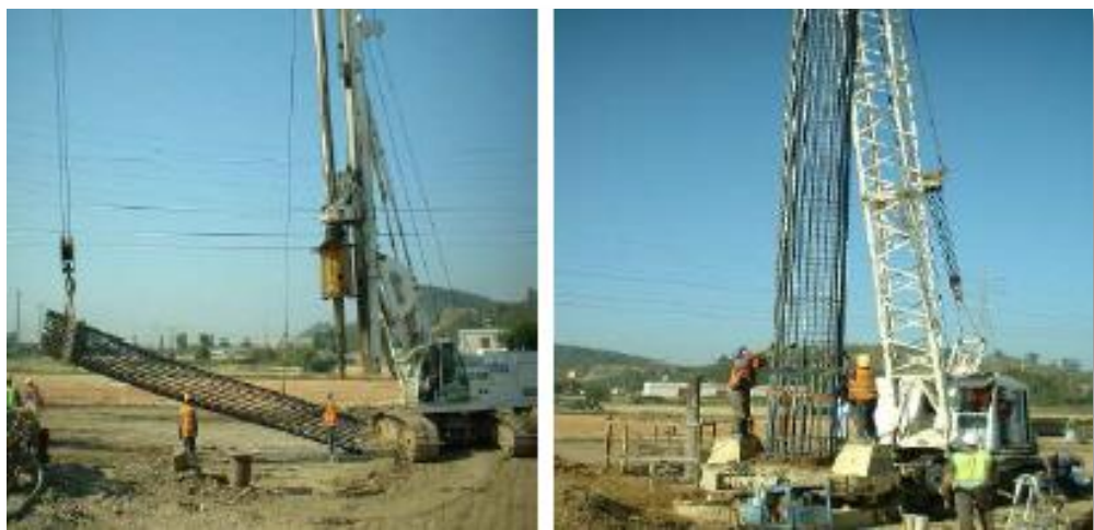
Fig. 13 Izaje de armadura preparada en pilotes moldeados
