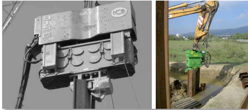
Fig. 53 Clavado de tablestacas por vibración
