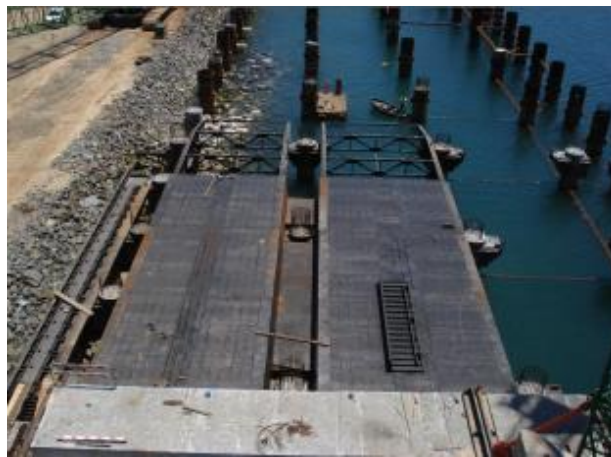
Fig. 30 Instalación de fondo de cimbra
