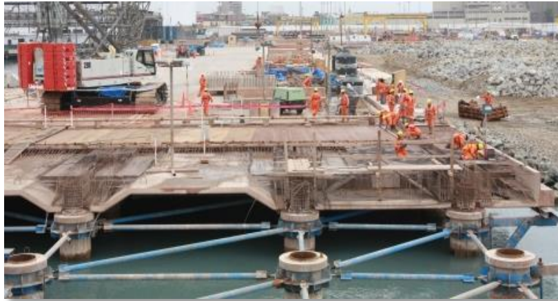
Fig. 71 Encofrado con losas prefabricadas en muelle sur del Callao
