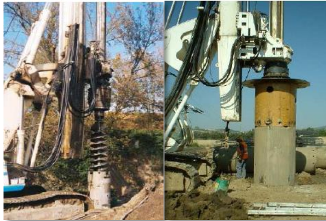
Fig. 36 Perforación y colocación de camisa.
