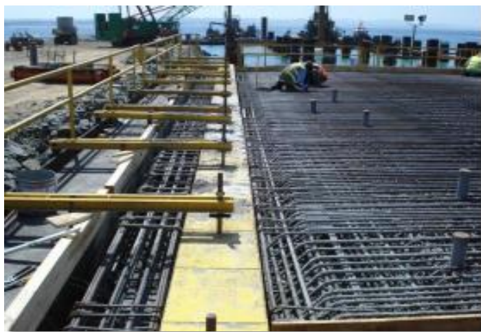
Fig. 32 Colocación de acero para losa de muelle sobre cimbra
