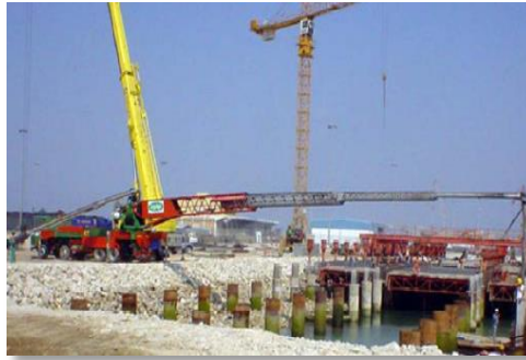
Fig. 29 Vaciado de pilote con telebelt
