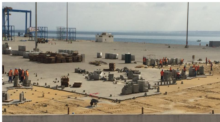
Fig. 84. Colocación de adoquines en patio de contenedores
