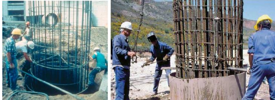
Fig. 19 Colocación de canastilla de acero
