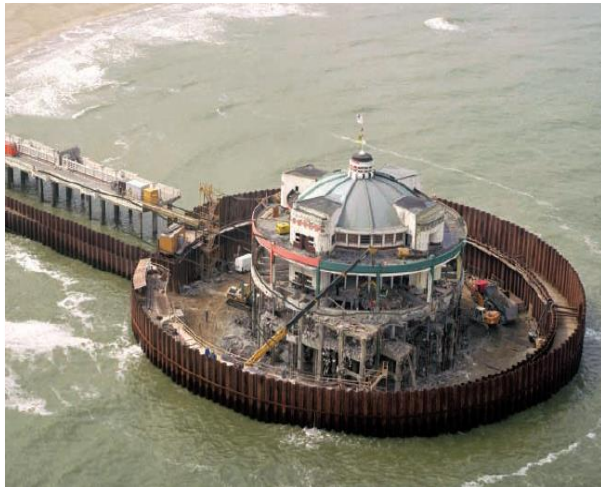
Fig. 49 Tablestacas para formación de ensecaderas en obras portuarias
