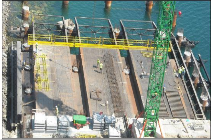
Fig. 73 Vista panorâmica de cimbra
