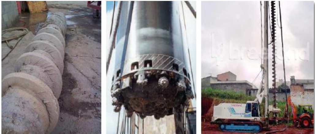
Fig.12 Selección de equipos y cabezales adaptados a la perforadora
