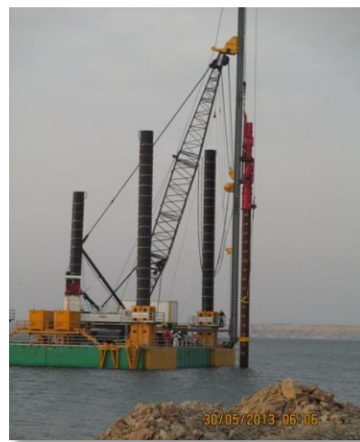
Fig. 25 Posicionamiento de pilote en martillo
