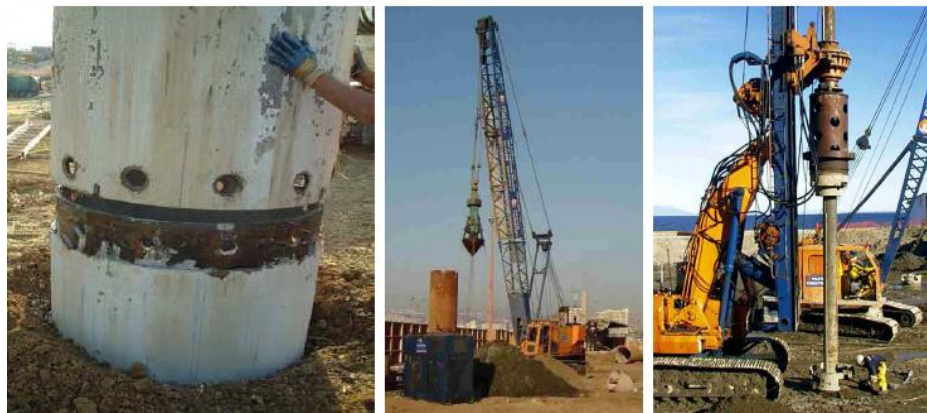
Fig. 18 Acople de camisas y limpieza en fondo de perforación
