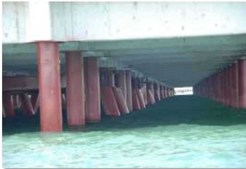
Fig. 2 Sistema de pilotaje inclinado
