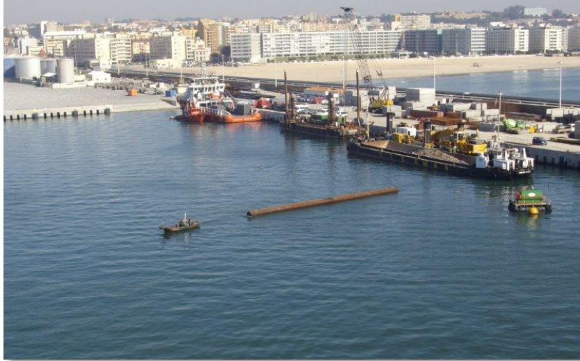
Fig. 24 Transporte de pilote hacia zona de hincado
