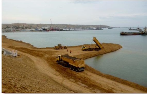
Fig. 79. Inicio de relleno en patio de contenedores
