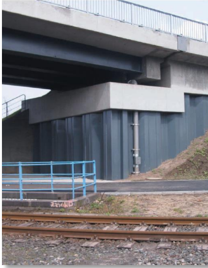
Fig. 48 Tablestacas como protección en pilares de puentes
