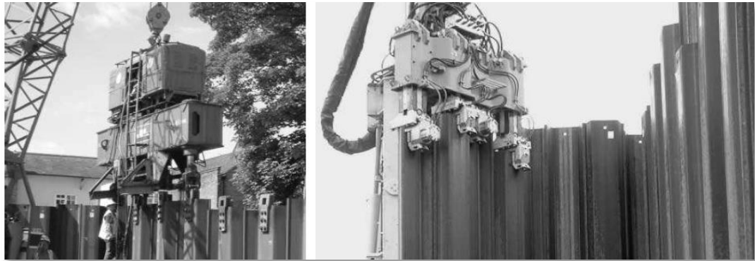
Fig. 54 Clavado de tablestacas por apoyada en cinco tablestacas
