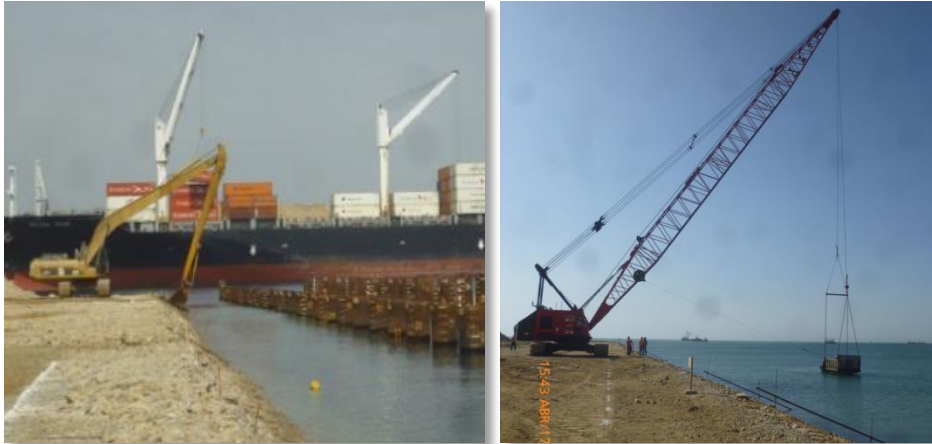
Fig. 42 – 43 Enrocado de talud con excavadora de brazo largo y Grúa
