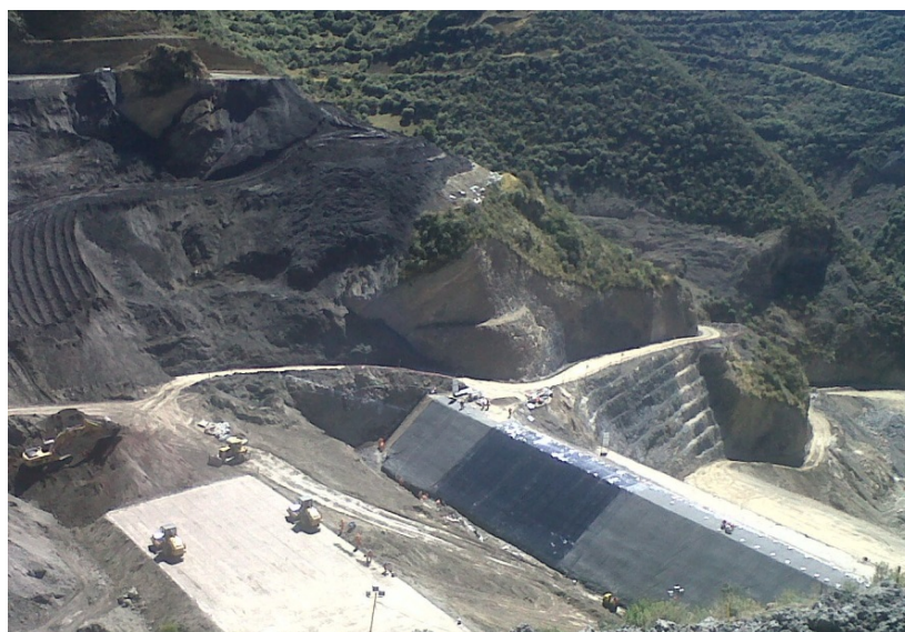
Figura N°11: impermeabilización de dique por posibles filtraciones.
