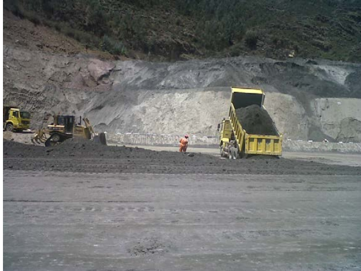
Figura N°17. Carguío y descargue de mezcla en plataforma Elaboración: El autor
