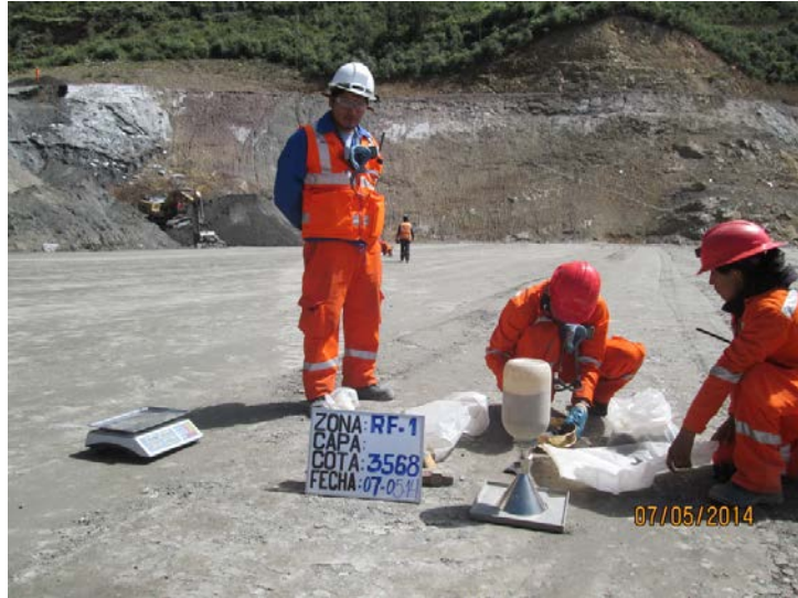
Figura N°20. Realizando pruebas de densidad Elaboración: El autor
