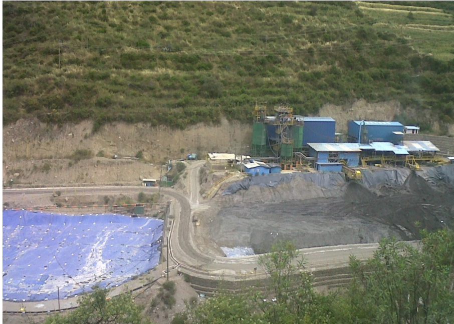
Figura N°13. Planta de relave filtrado y su poza de contingencia Elaboración: El autor
