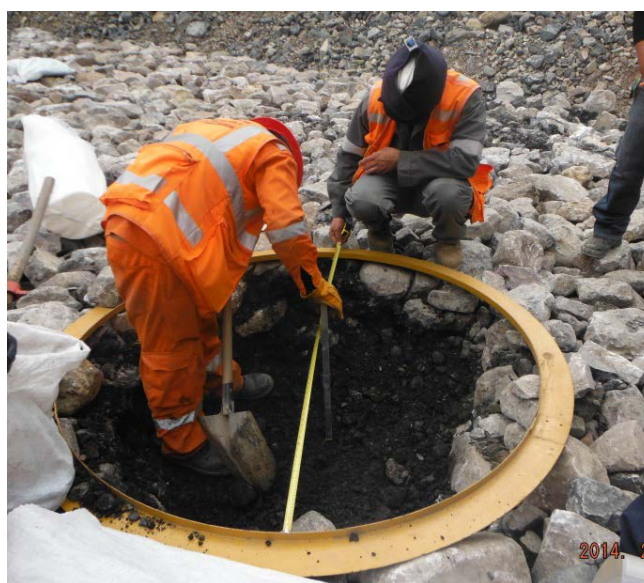
Figura N° 41. Excavación de agujero 0.50m de profundidad, 1.50m de diámetro Elaboración: El autor
