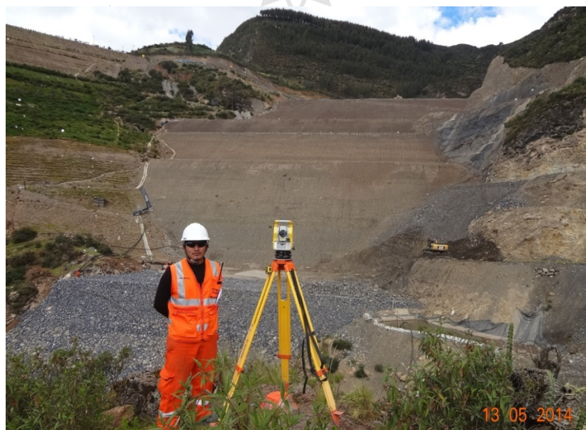
Figura N°10. Construcción de Dique etapas 1,2,3 y 4 Elaboración: El autor
