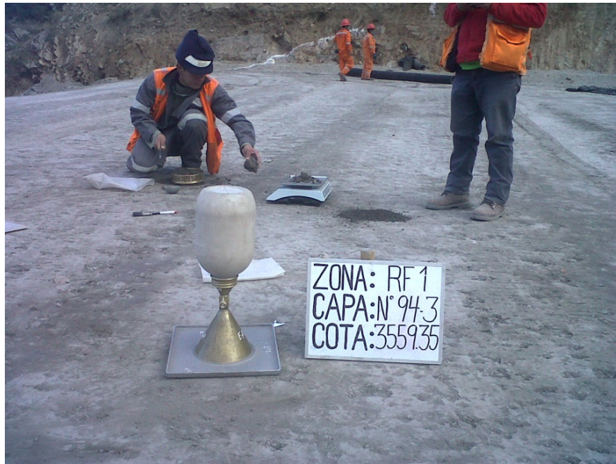
Figura N° 40. Ensayos con cono de arena en capa compactada Elaboración: El autor
