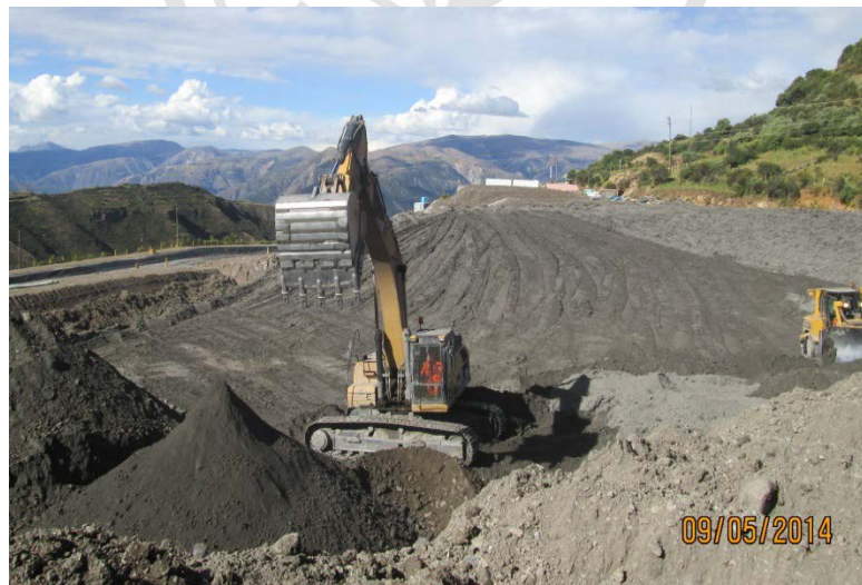
Figura N°05. Mezclado de relave y material de préstamo 3R:1P.
