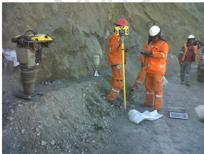
Figura N°21. Colocación de filtro y compactación Elaboración: El autor
