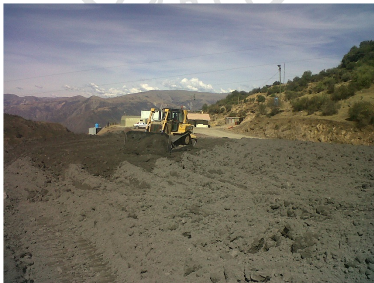
Figura N°15. Acopio de relave seco una capa de 60cm aprox. Elaboración: El autor
