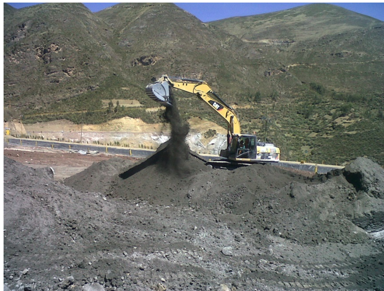
Figura N°16. Mezclado de relave y préstamo 3R:1P.
