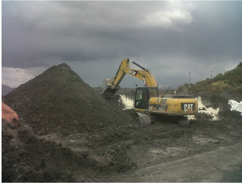
Figura N° 44. Mezclado de cal con relave en un clima desfavorable Elaboración: El autor
