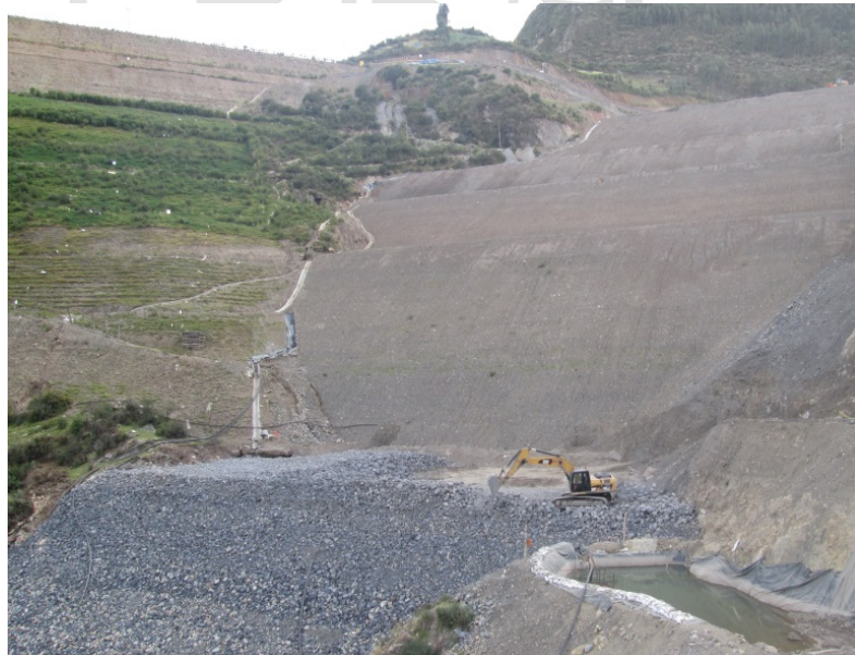
Figura N°09. Vista panorámica del pedraplén o enrocado, cimentación para el dique
