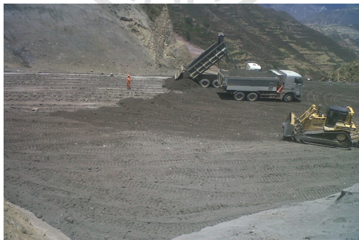
Figura N°18. Conformado y nivelación en plataforma capa 35cm espesor Elaboración: El autor
