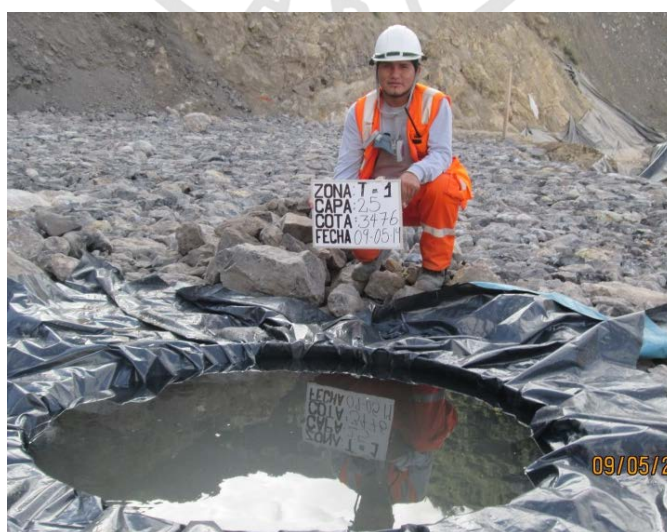
Figura N° 42. Ensayo de reemplazo por volumen de agua Elaboración: El autor
