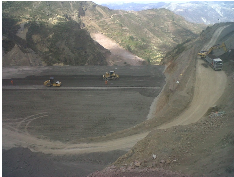
Figura N°19. Compactado en plataforma.
