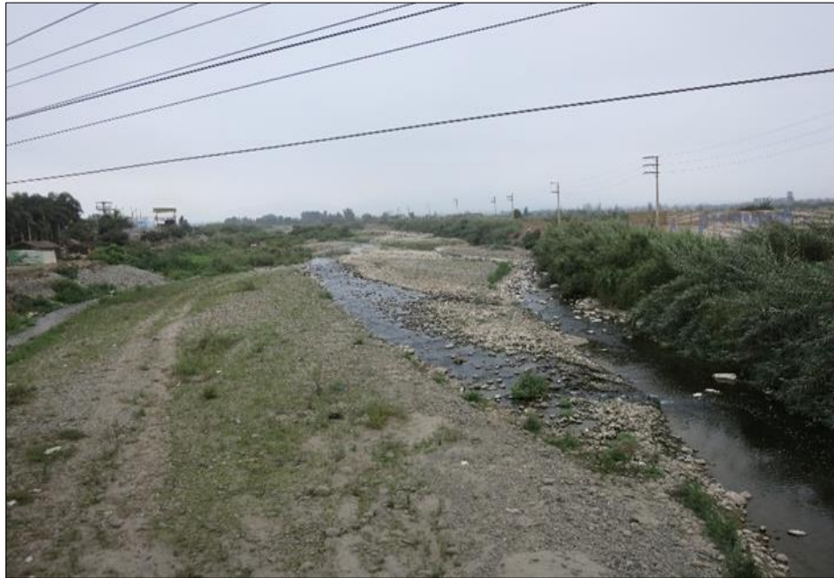
Figura 43: Cauce del río Chancay - Huaral
