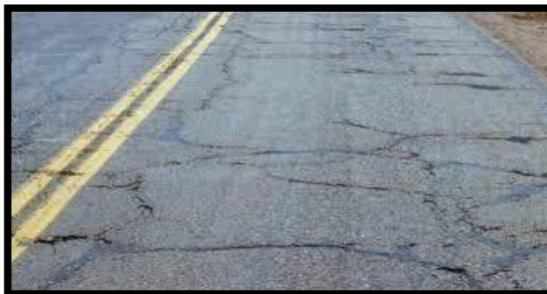
Figura 8: Falla fisura en bloque
