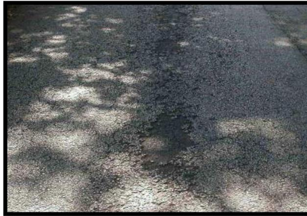
Figura 12: Falla por desprendimiento de agregado
