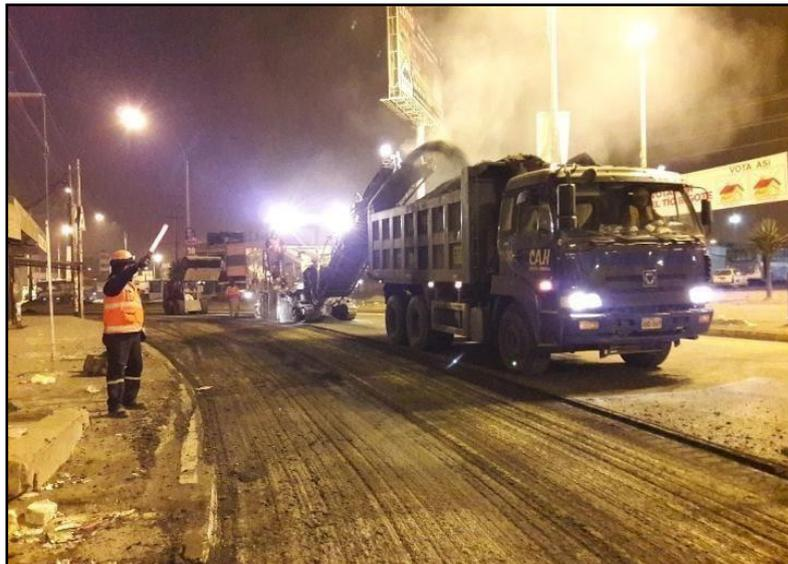
Figura 17: Maquina fresadora eliminando material reciclado en volquetes
