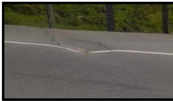
Figura 9: Falla por hundimiento
