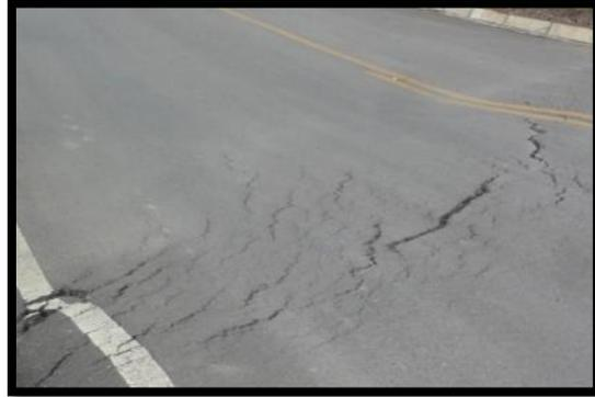
Figura 10: Falla por desplazamiento
