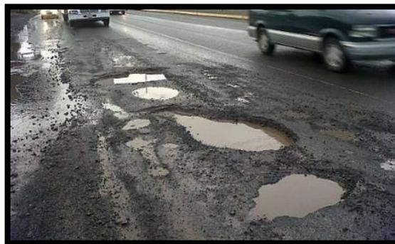
Figura 11: Falla por desplazamiento
