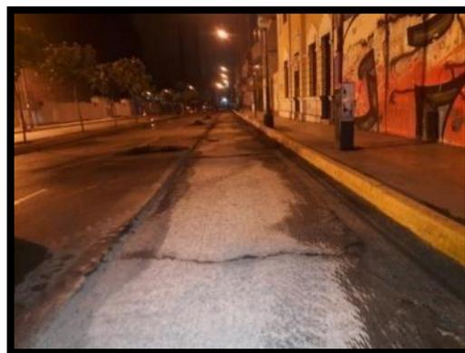
Figura 5. Pavimento fresado
