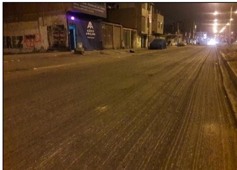
Figura 19: Pavimento después del proceso de fresado
