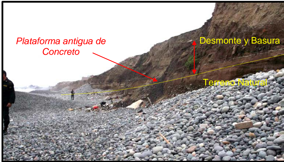
Figura N° 03. Antigua plataforma de la Av. Costanera (encima de ella se ha depositados basura y desmonte con un espesor de varios metros)
