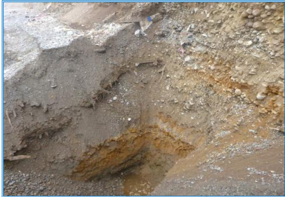
Figura N° 16. Vista perfil estratigráfico de calicata de apoyo
