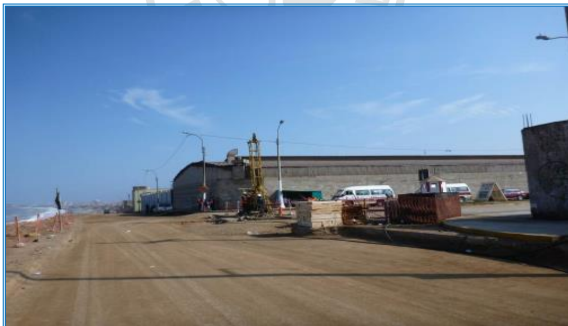
Figura N° 13. Vista equipo de perforación en Av. Santa Rosa Fuente: Los autores
