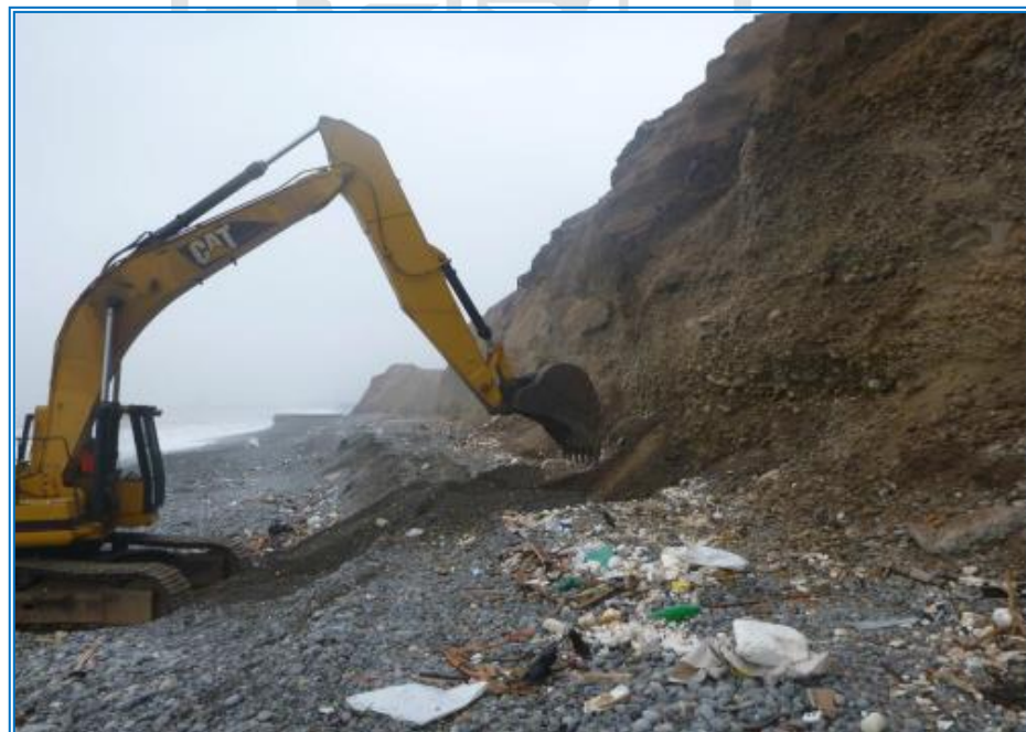
Figura N° 15. Maquinaria en plena labor de excavación de calicata de apoyo con fines de cimentación al pie del acantilado en Avda. Santa Rosa
