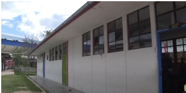
Figura N°58: Estado Actual Fuente: Propia
