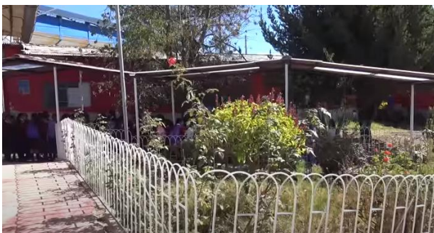
Figura N°56: Estado Actual Fuente: Propia
