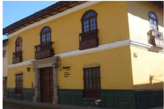
Figura N°21: Vista Fachadas Interiores Fuente: FP Arquitectura Elaboración: FP Arquitectura
