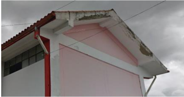
Figura N°57: Estado Actual Fuente: Propia
