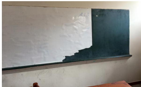
Figura N°60: Estado Actual Fuente: Propia
