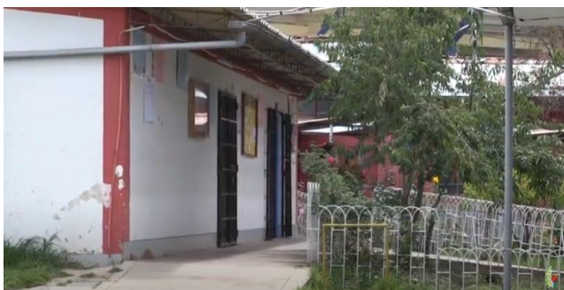
Figura N°55: Estado Actual Fuente: Propia
