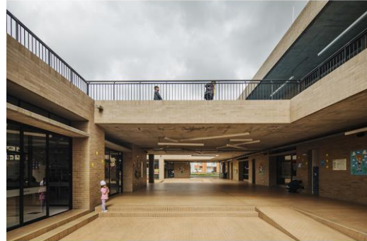
Figura N°17: Vista Fachadas Interiores Fuente: FP Arquitectura Elaboración: FP Arquitectura
