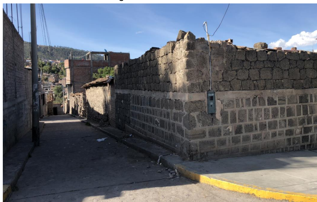
Fotografía del terreno 2
