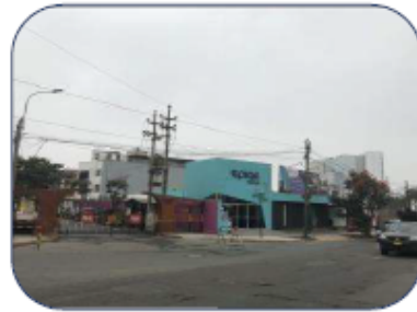
FACHADA DEL INMUEBLE
