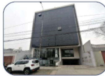
FACHADA DEL INMUEBLE
