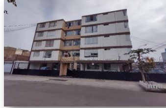
FACHADA DEL INMUEBLE
