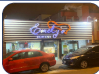
FACHADA DEL INMUEBLE
