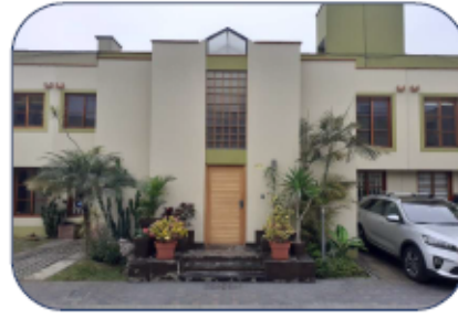
FACHADA DEL INMUEBLE
