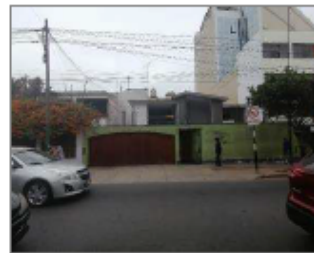
FACHADA DEL INMUEBLE
