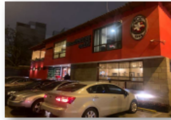
FACHADA DEL INMUEBLE
