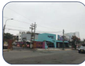
FACHADA DEL INMUEBLE
