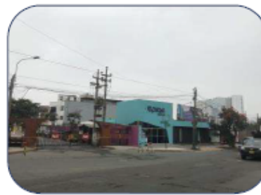
FACHADA DEL INMUEBLE
