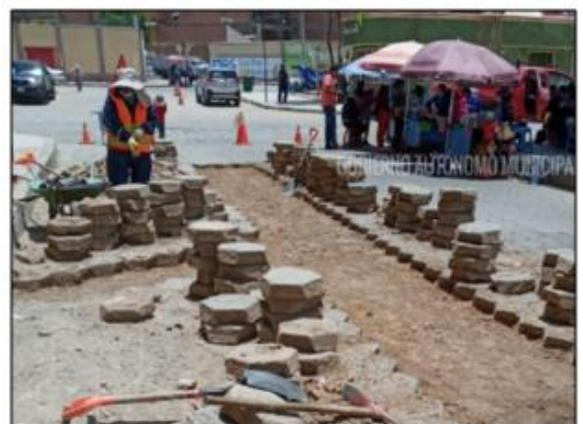
**Figura 10.** Pavimento articulado dañado en proceso de reparación.
