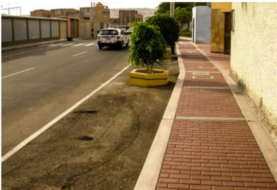
**Figura 8.** Aplicación de pavimento articulado utilizado en tránsito peatonal.
