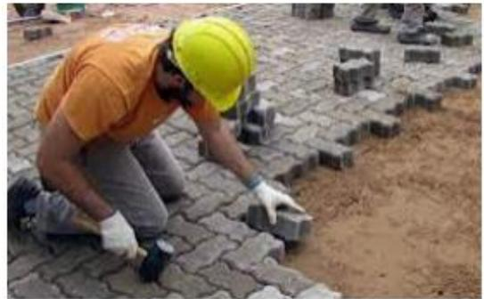
**Figura 11.** Los vehículos deben transitar máx. a 60km/h. Su colocación de el adoquín es individualmente
