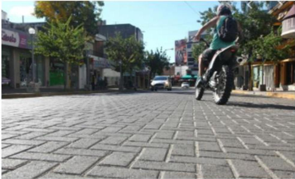
*Figura 9. Aplicación de pavimento articulado utilizado en tránsito vehicular.*
