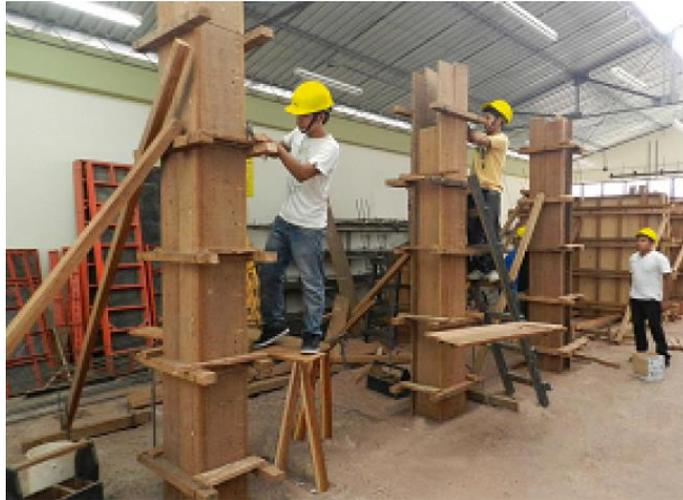
Figura N°21: clase de encofrados.
