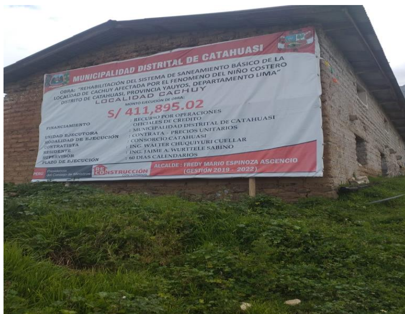
Figura 2: La Comunidad de Cachuy, siendo rehabilitada, el sistema de saneamiento por la Gestión del Alcalde Freddy Espinoza Ascencio.
