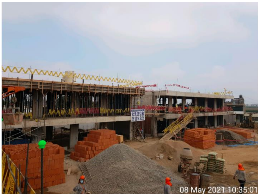
Figura 92. Stock de materiales en obra
