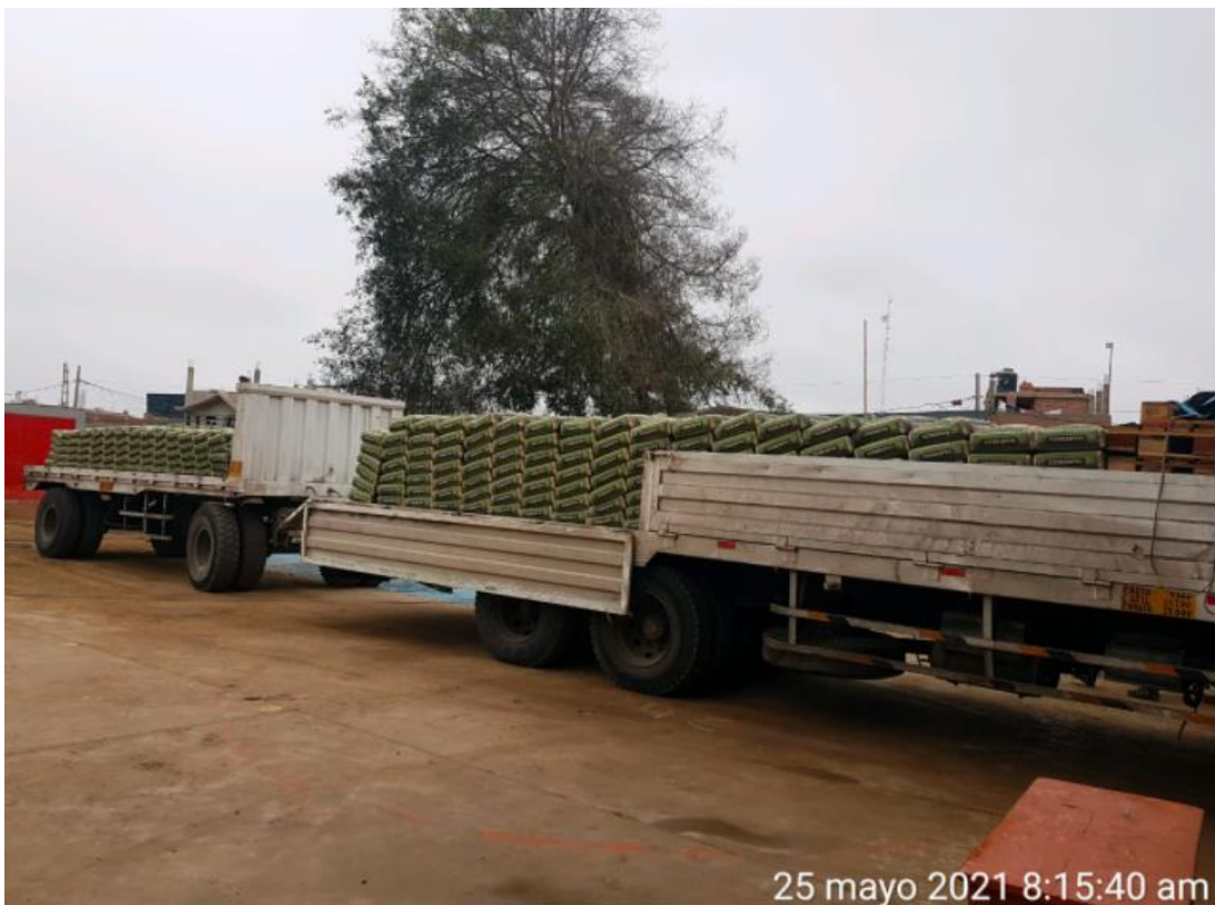
Figura 94. Llegada de cemento a obra Elaboración: Los autores
