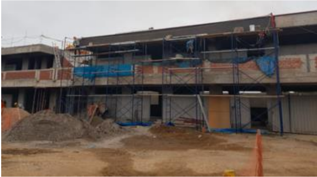
Figura 93. Andamios nuevos en obra Elaboración: Los autores
