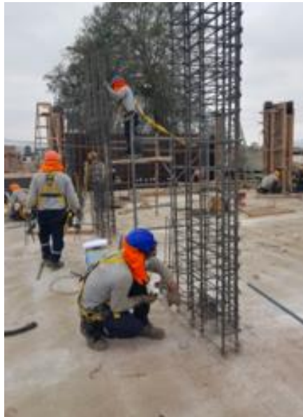
Figura 95. Verificación de recubrimiento en columnas Elaboración: Los autores
