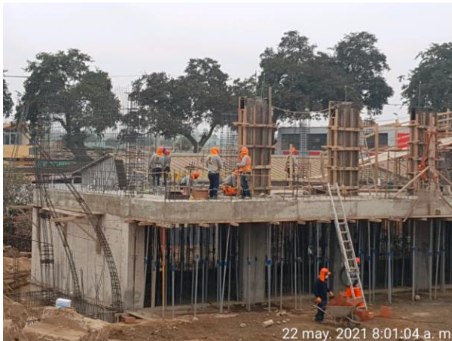
Figura 38. Colocado de encofrado en columnas Elaboración: Los autores
