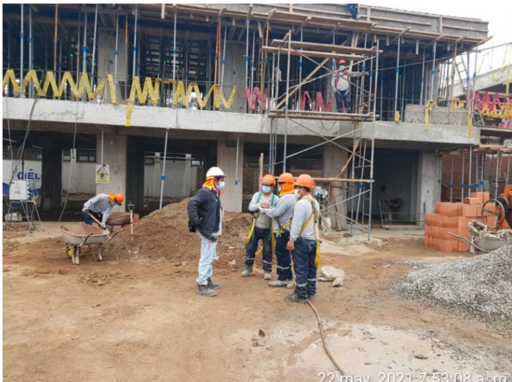
Figura 102. Instrucciones antes de realizar los trabajos Elaboración: Los autores
