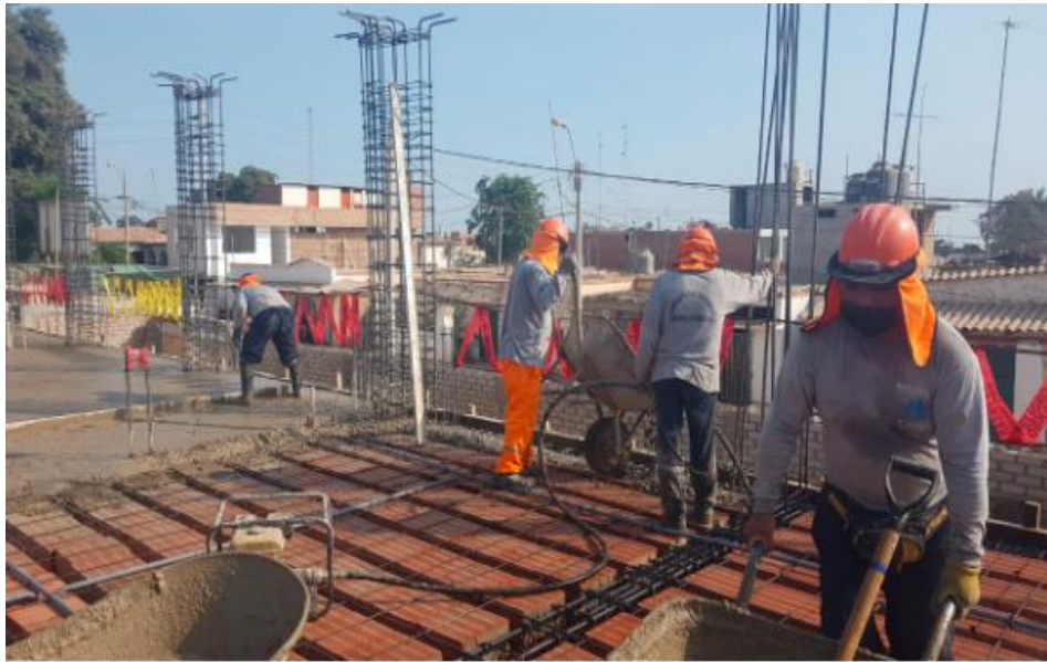
Figura 39. Vaciado de concreto en losa aligerada Elaboración: Los autores
