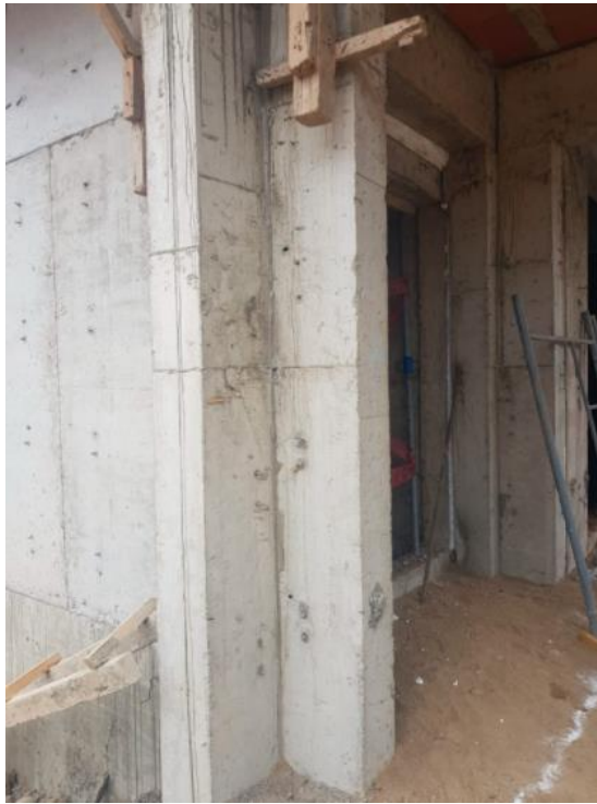
Figura 96. Elemento estructural sin segregación Elaboración: Los autores
