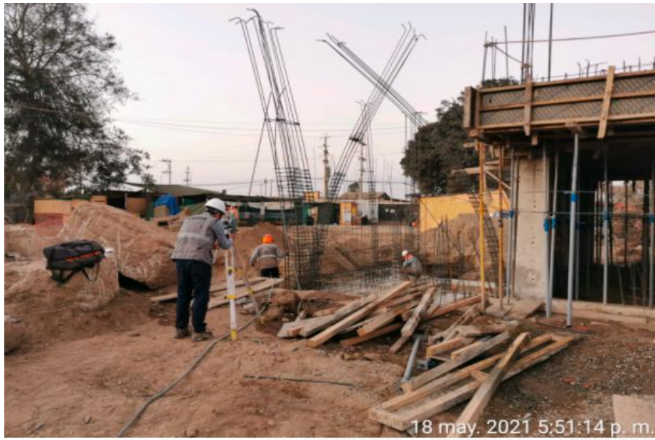
Figura 33. Alineamiento y verificación de niveles en zapatas Elaboración: Los autores
