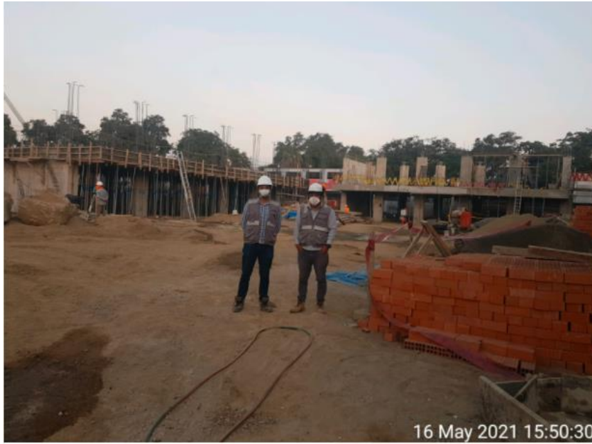
Figura 30. Visita a obra Elaboración: Los autores
