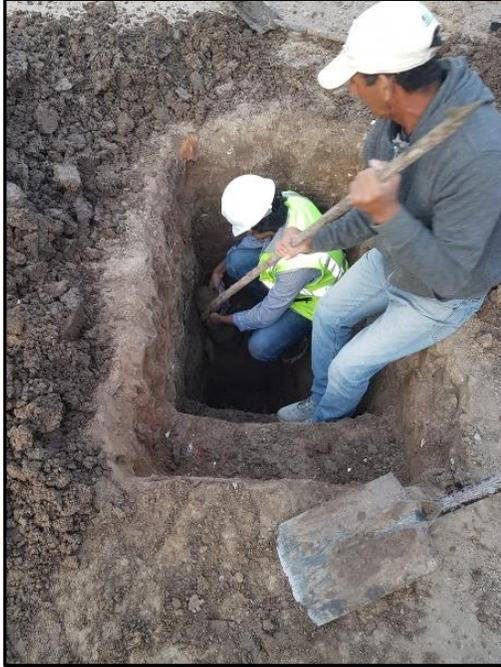
**Figura 20.** Extracción de muestras alteradas
