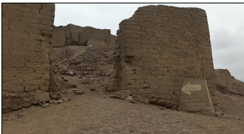
Figura N° 32. Vista de camino no formalizado al interior del edificio principal de la Fortaleza de Paramonga. Elaboración propia.
