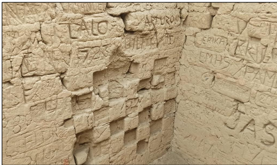
Figura N° 35. Friso mural vandalizado al interior de recinto en la Fortaleza de Paramonga. Elaboración propia.
