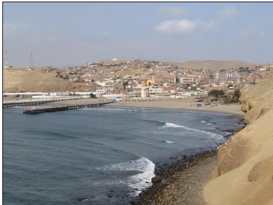
Figura N° 3. Vista panorámica del muelle y casco urbano de Supe Puerto.
