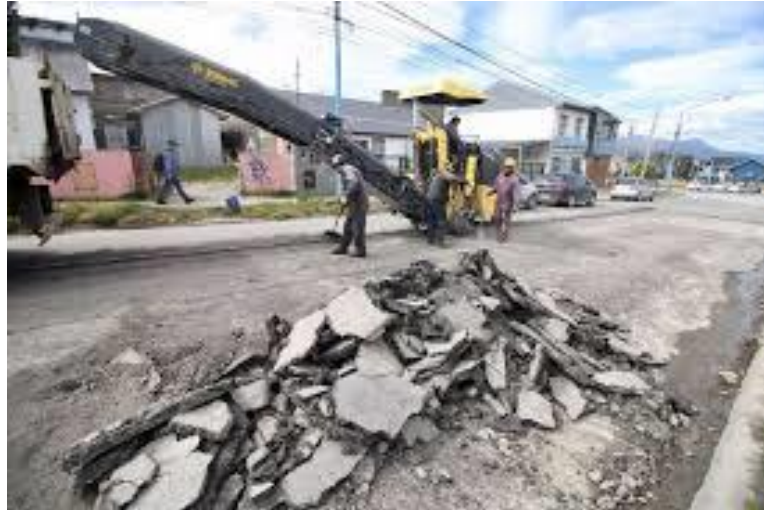
Figura 6. Reconstrucción del pavimento Fuente: Amaya y Rojas (2017)
