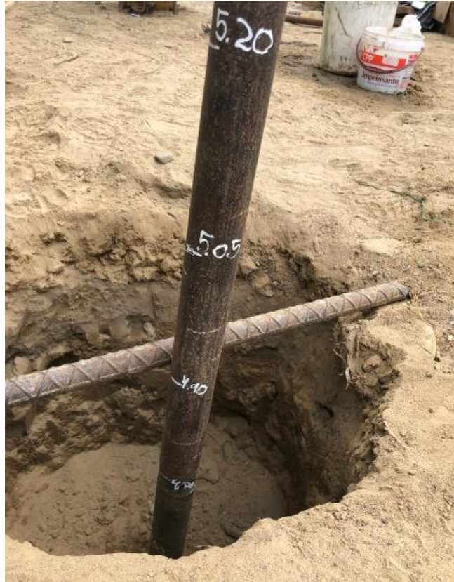
Figura 62: Rebote a 4.90m SPT 1 Fuente: Propia
