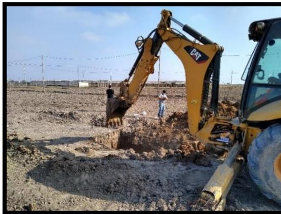
Figura 64: Excavación con retroexcavadora
