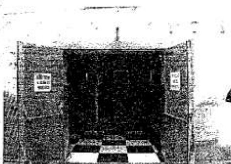
FOTO N° 11.- SALIDA DE EMERGENCIA
