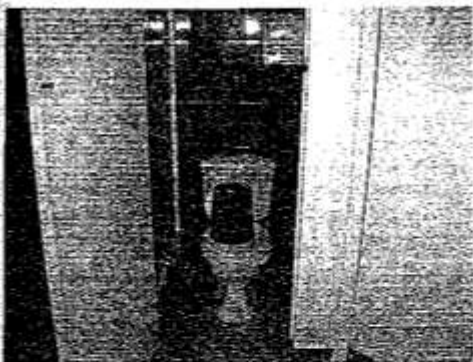
FOTO N° 05.- SERVICIOS HIGIENICOS - WC
