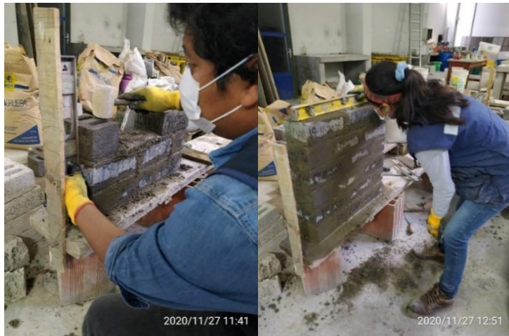
Figura 130. Nivelación de muretes con ladrillo de concreto con 10 % vidrio crudo molido Fuente: Elaboración propia
