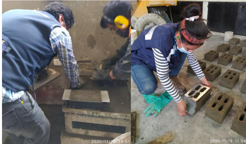
Figura 71. Vibrado, frotachado, fabricación y desmolde de ladrillos de concreto patrón Fuente: Elaboración propia
