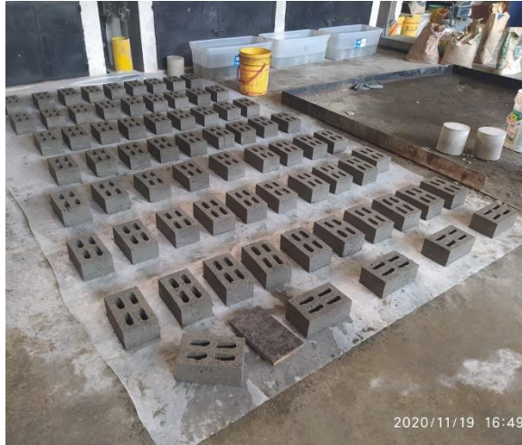
Figura 77. Fabricación de ladrillos con 10 % vidrio crudo molido Fuente: Elaboración propia
