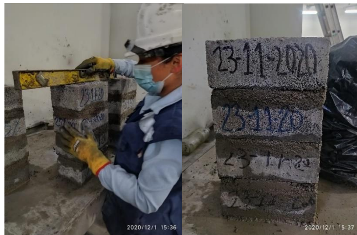
Figura 115. Verificación de nivel y elaboración del prisma de ladrillo de concreto con 25 % de vidrio crudo molido Fuente: Elaboración propia
