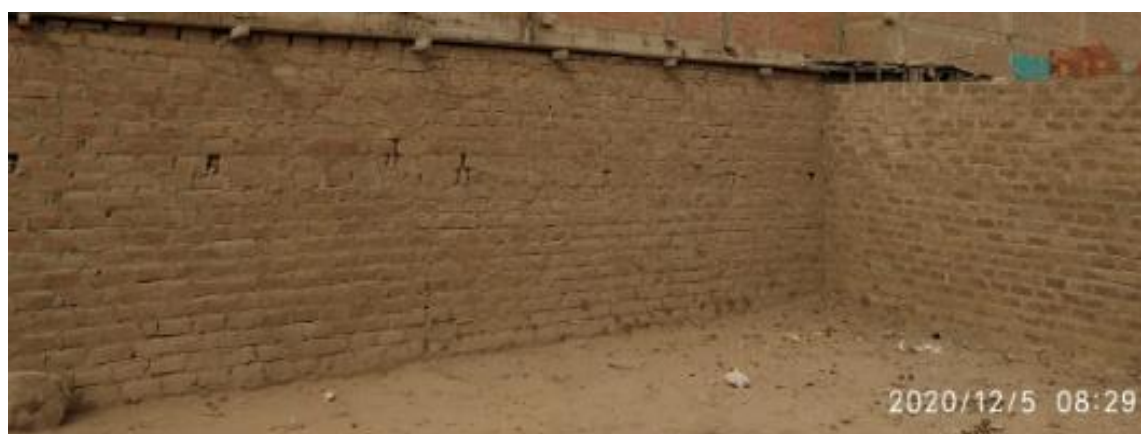
Figura 18. Albañilería simple Fuente: Elaboración propia
