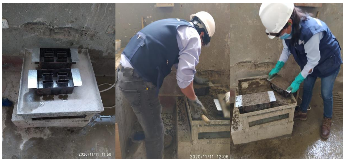
Figura 65. Ubicación de molde metálico en mesa vibratora, vaciado y vibrado del ladrillo de concreto Fuente: Elaboración propia
