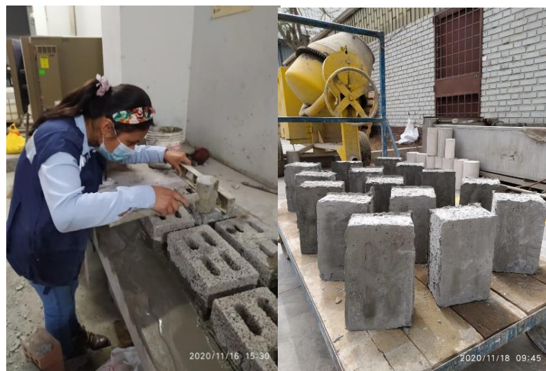
Figura 69. Refrentado del ladrillo de concreto Fuente: Elaboración propia
