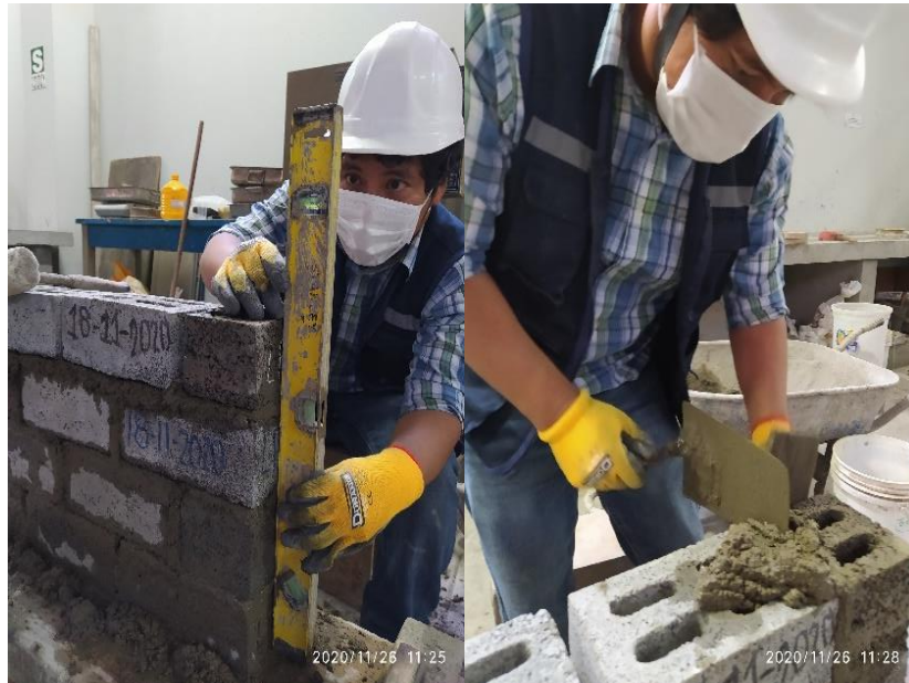
Figura 126. Nivelación de muretes con ladrillo de concreto patrón Fuente: Elaboración propia
