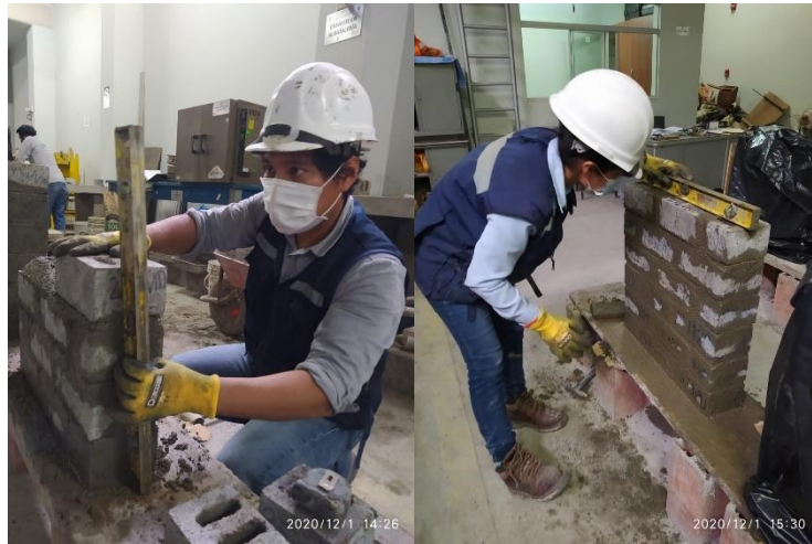
Figura 135. Elaboración y nivelación de muretes con ladrillo de concreto con 25 % vidrio crudo molido Fuente: Elaboración propia
