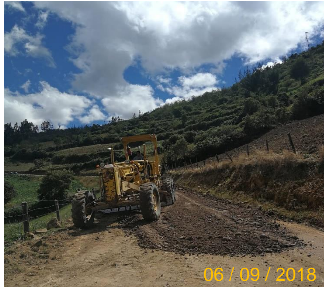
Imagen N° 3: Trabajo de afirmado Tramo de Tacta – Gomal, Mariscal Castilla
