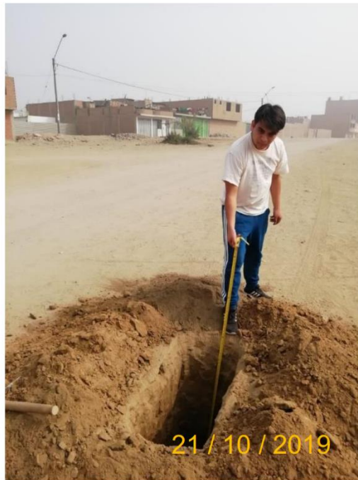
Imagen N° 4: Calicatas a una profundidad de 1.50 m
