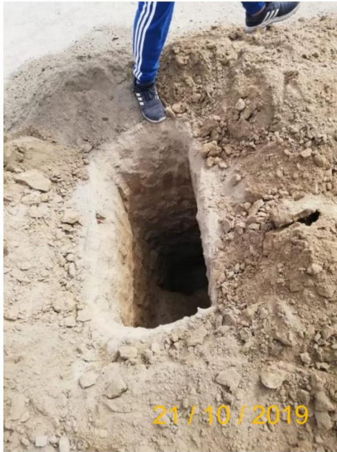
Imagen N° 3: Dimesionamiento de las calicatas 1.00 m x 0.80 m
