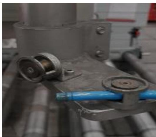
*Figura 361.* Conexión neumática de ingreso de aire hacia sopladores de recirculación de calor averiada.
