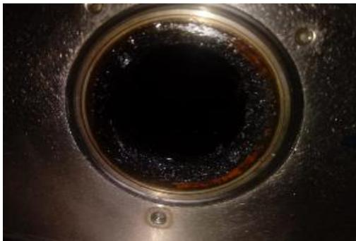
*Figura 356.* Tubería interior de quemador principal llena de orring con falta de limpieza.
