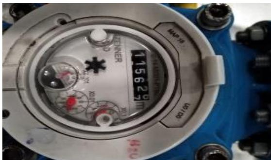
*Figura 359.* Caudalímetro principal de GLP en falla registra lectura inadecuada.
