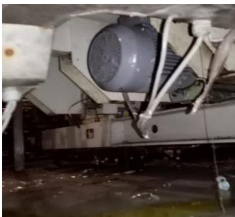
*Figura 364.* Motor principal con fuga de aceite.
