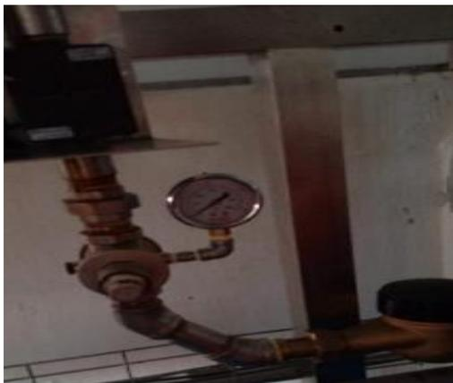
*Figura 362.* Tubería de ingreso de glp obstruida.
