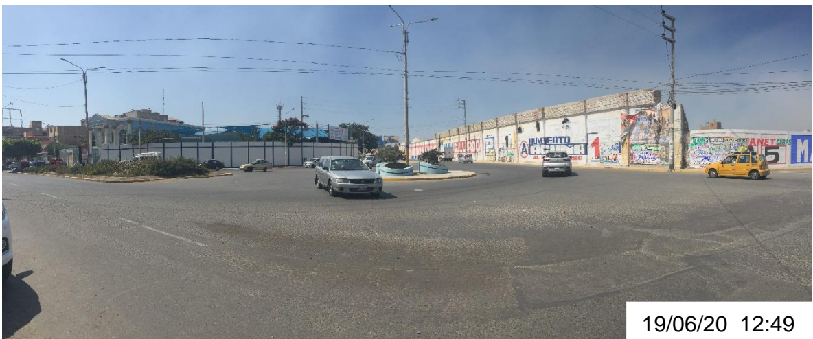
Fotografía 2. Vista desde la Av. Prolongación Francisco Bolognesi, del óvalo de las intersecciones de estudio
