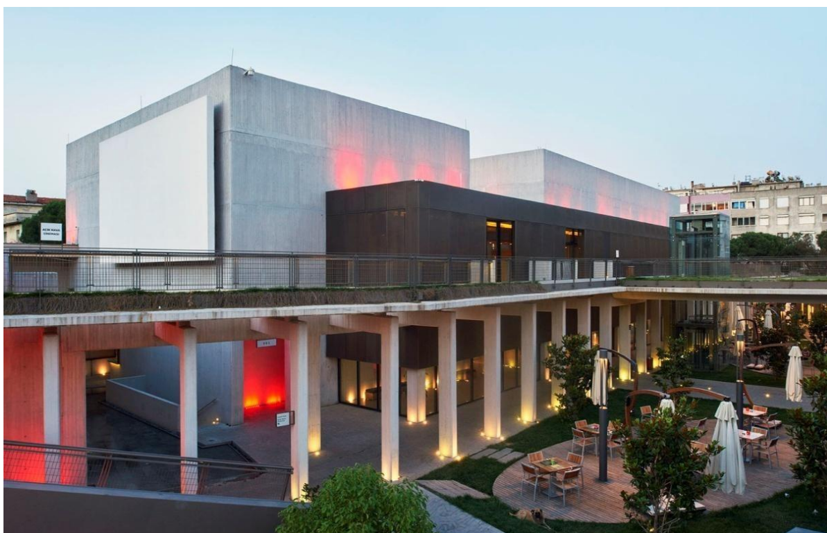
Figura 22. Vista del patio interno y del puente verde
