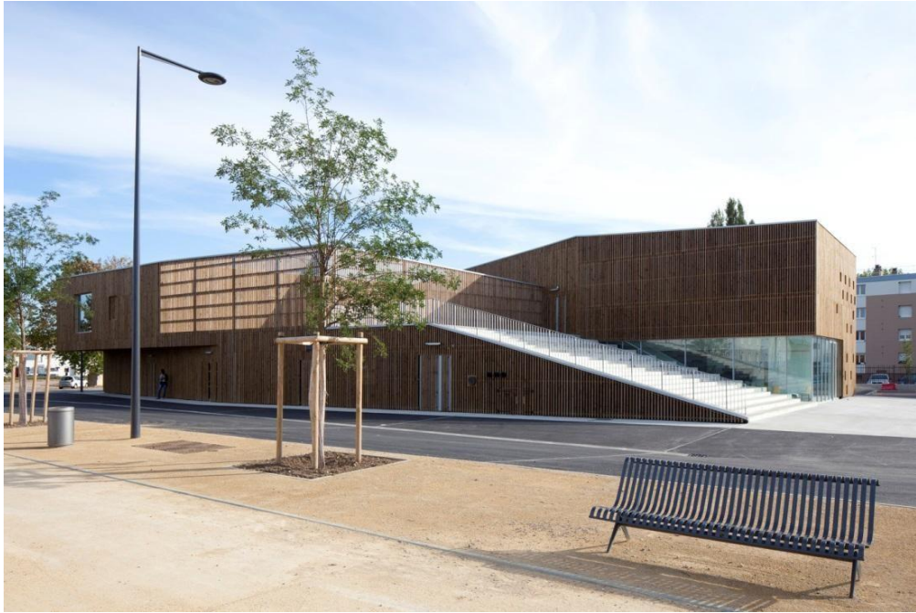
Figura 12. Vista Lateral Izquierda Fuente: http://www.arquitecturaviva.com
