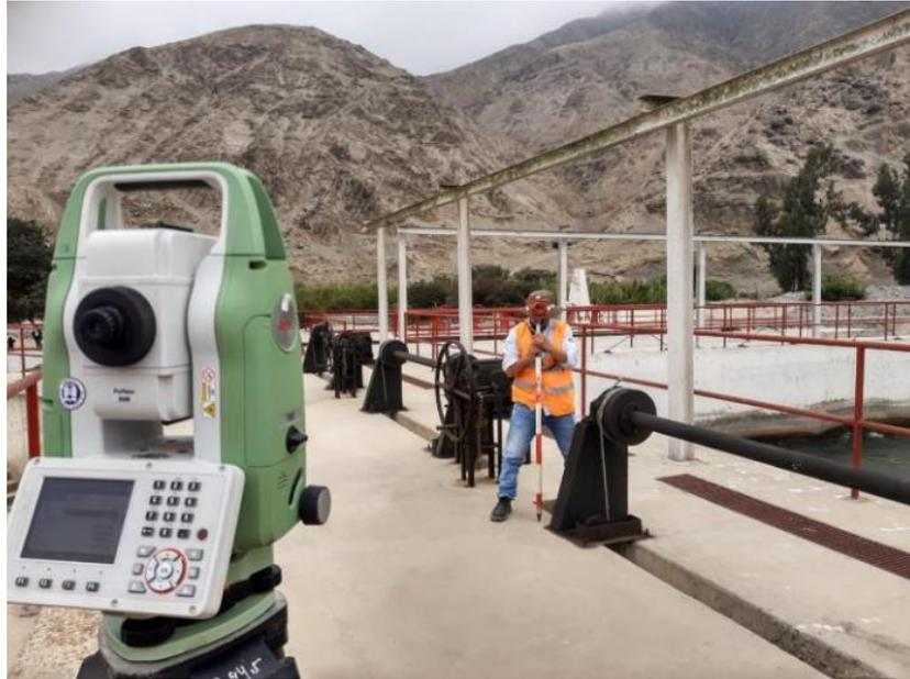
Figura 53: Proceso de levantamiento de puntos topográfico sobre estructura de la bocatoma Nueva Imperial - Cañete.
