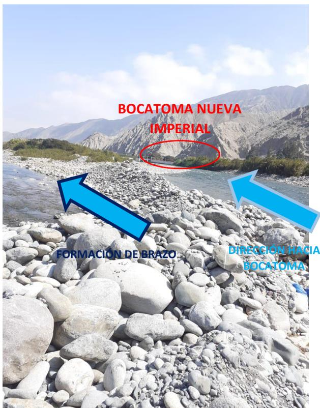
Figura 3: Formación de brazo tramo aguas arriba de la bocatoma (vista aguas abajo).
