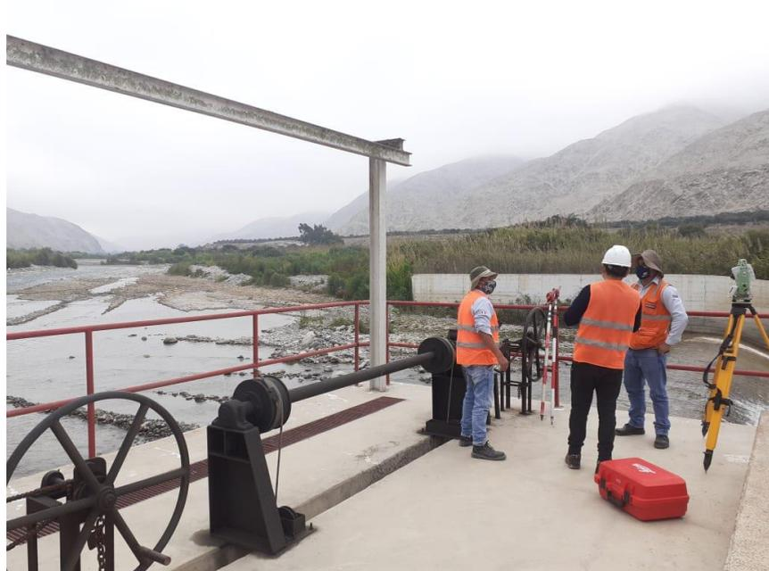
Figura 54: Proceso de levantamiento de puntos topográfico sobre barraje móvil de la bocatoma Nueva Imperial - Cañete.
