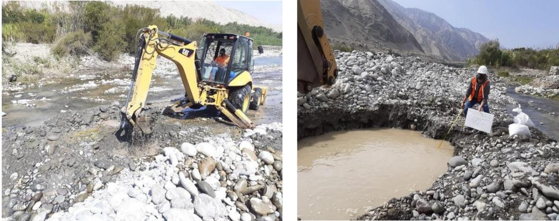
Figura 90: Excavación de calicata N°3.
