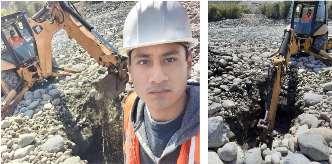
Figura 89: Excavación de calicata N°2.
