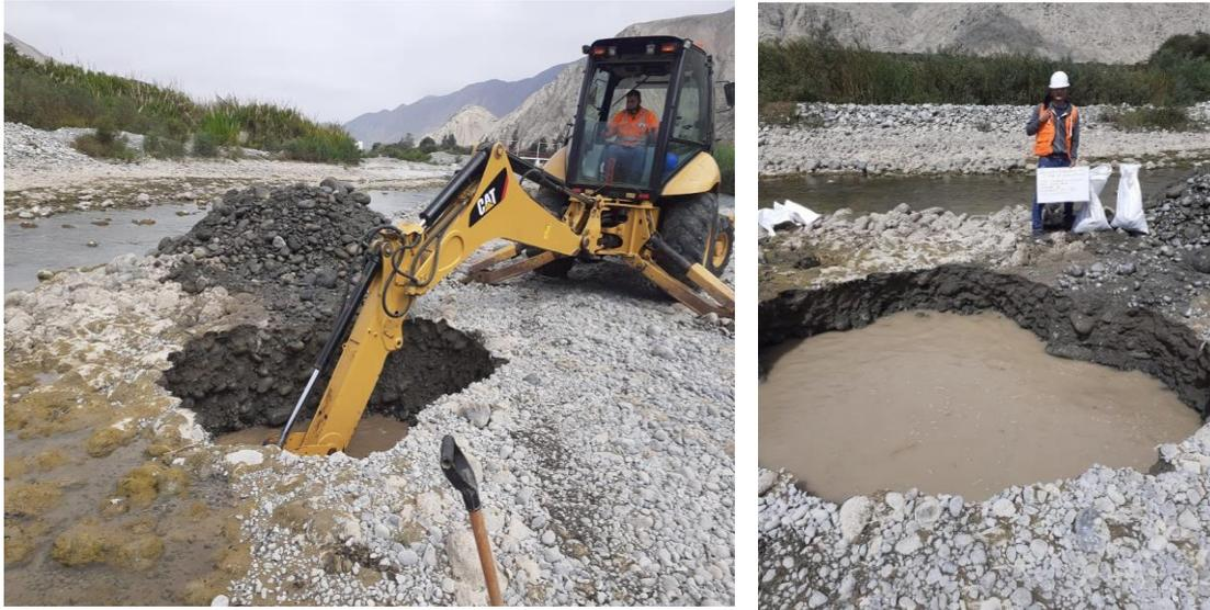
Figura 88: Excavación de calicata N°1.
