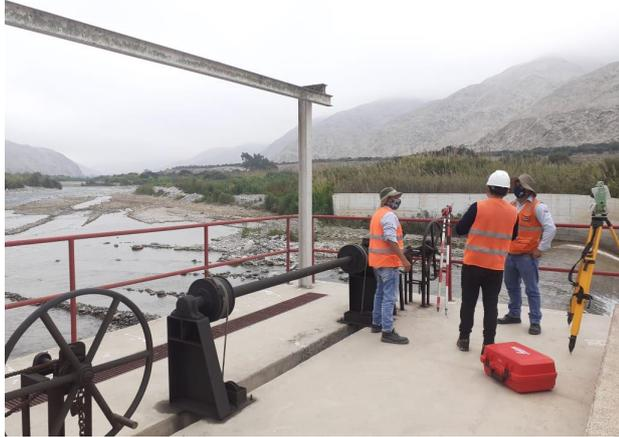
Figura 26: Fijando puntos topográficos.
