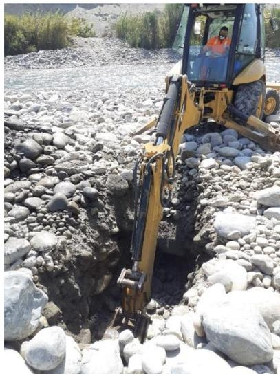
Figura 35: Excavación de calicatas
