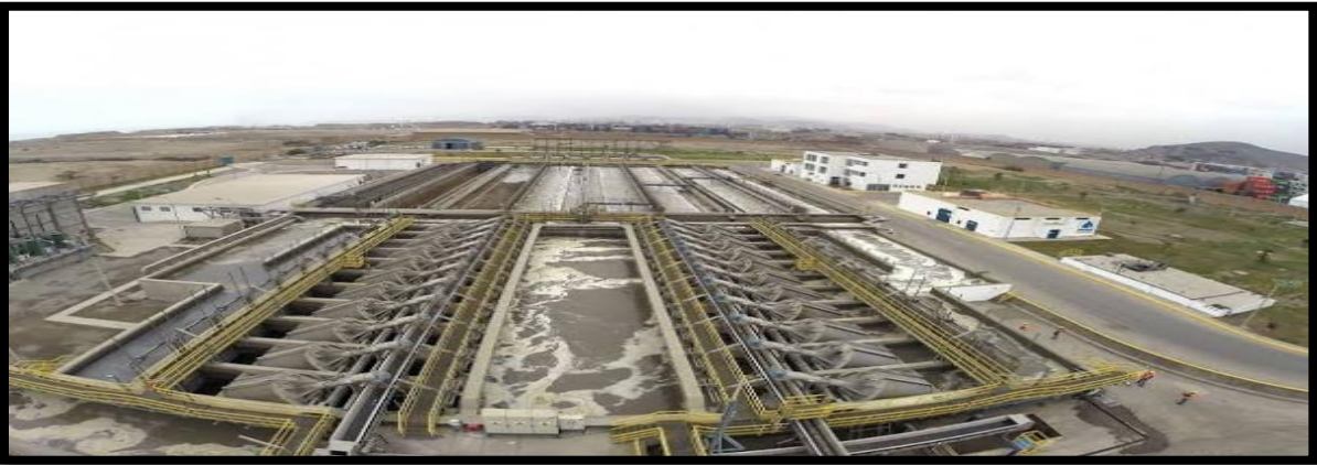
Figura 20. Imagen del Proyecto PTAR año 2019 en Sullana
