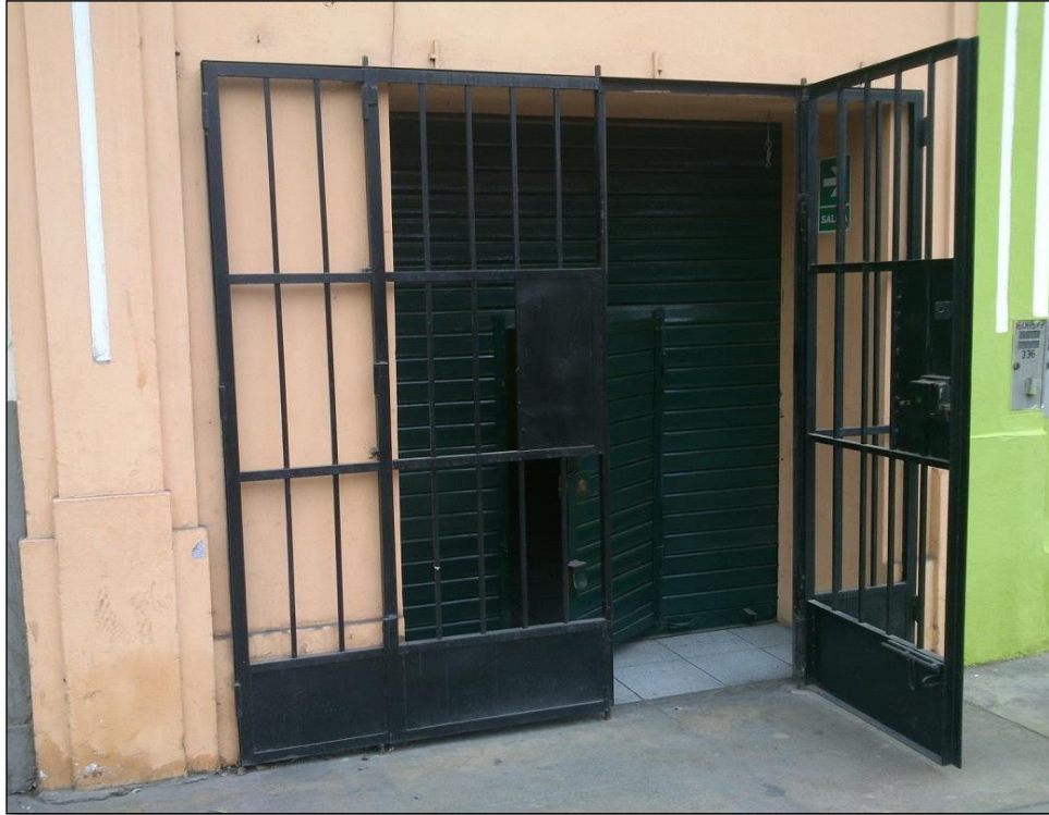
Figura 1: Almacén y oficina Fuente: Google Maps
