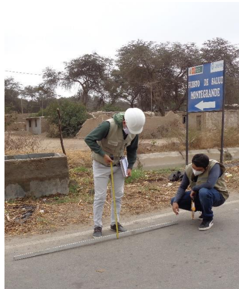
Depresión de baja severidad
