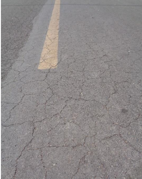
Piel de cocodrilo de baja severidad
