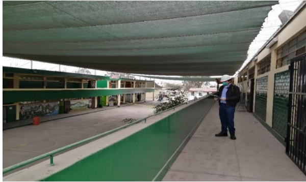
Figura 31. Elementos no estructurales del pabellón 1 Elaboración: Los autores
