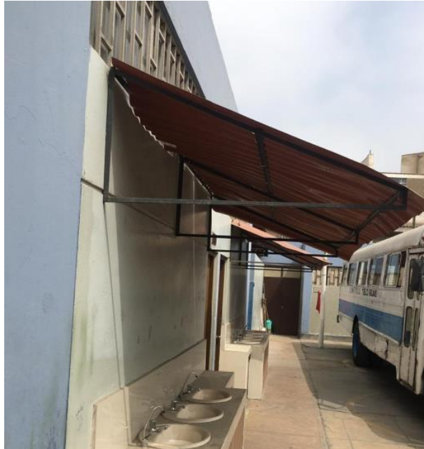
Figura 154. Elementos no estructurales del pabellón 6 Elaboración: Los autores
