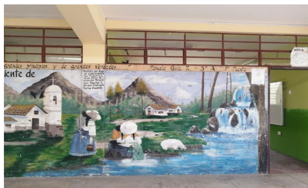
Figura 68. Estado de conservación del pabellón 3 Elaboración: Los autores
