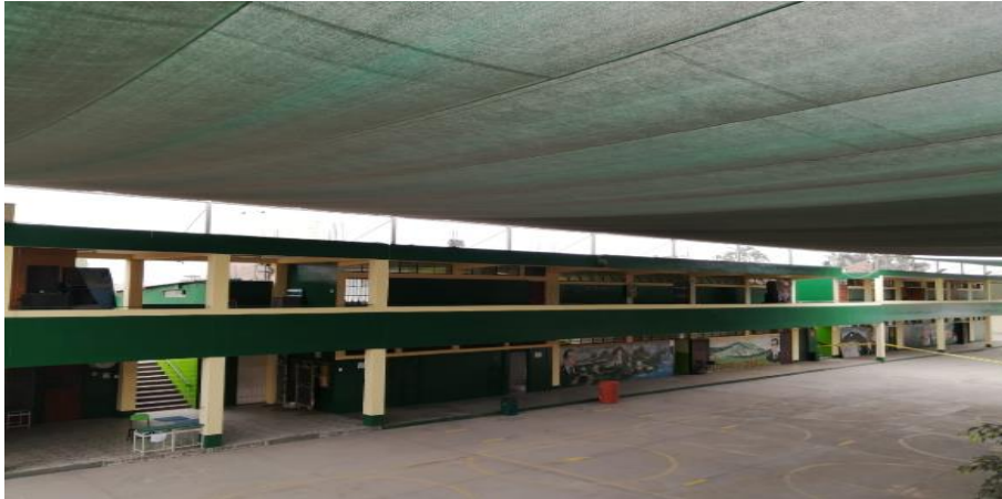
Figura 66. Tipo de cubierta del pabellón 3 Elaboración: Los autores
