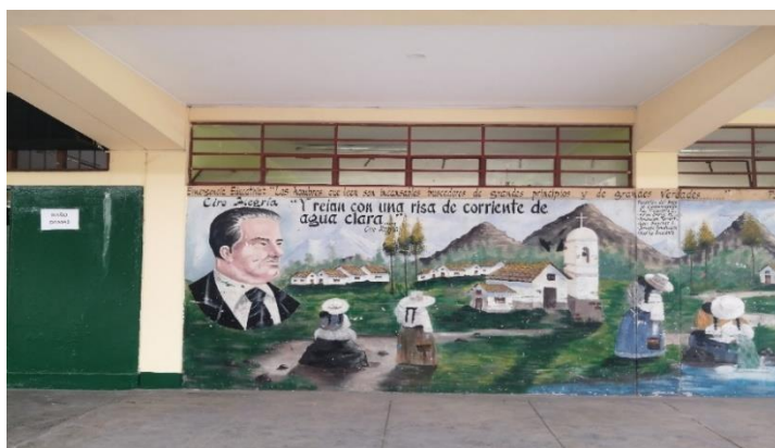
Figura 44 Estado de conservación del pabellón 1 Elaboración: Los autores
