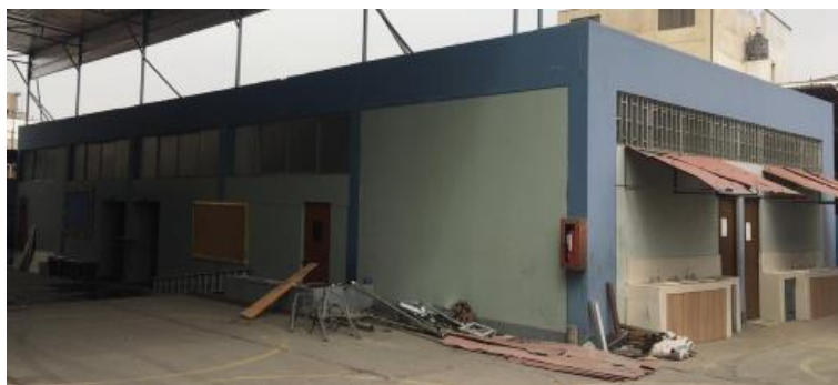
Figura 155. Estado de conservación del pabellón 6 Elaboración: Los autores
