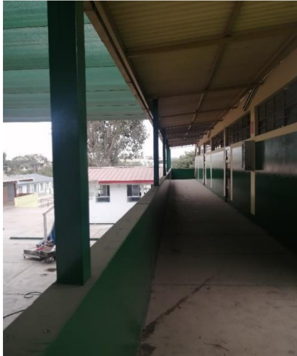
Figura 56. Estado de conservación del pabellón 2 Elaboración: Los autores
