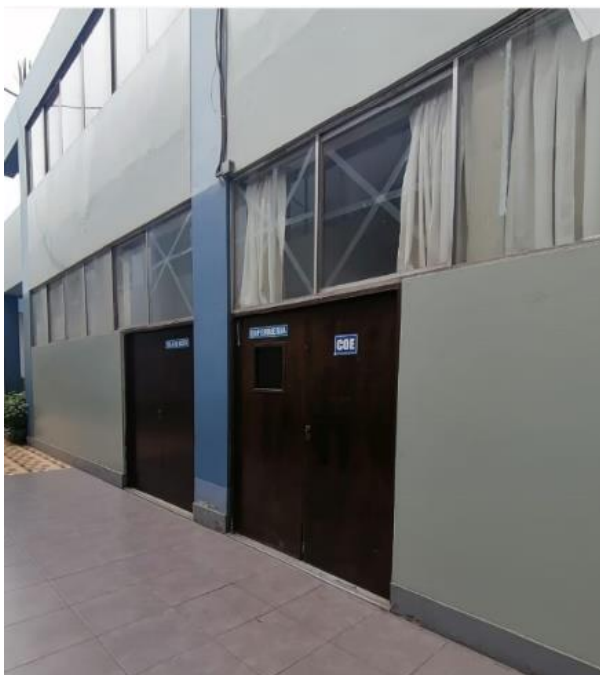
Figura 143. Estado de conservación del pabellón 5 Elaboración: Los autores
