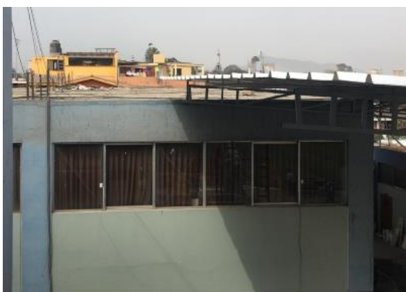
Figura 141 Tipo de cubierta del pabellón 5 Elaboración: Los autores
