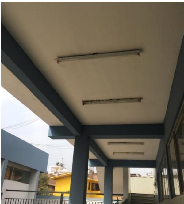
Figura 142. Elementos no estructurales del pabellón 5 Elaboración: Los autores
