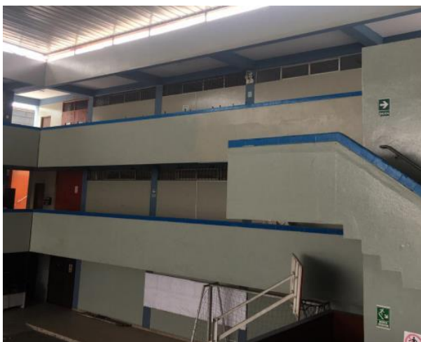
Figura 95. Estado de conservación del pabellón 1 Elaboración: Los autores
