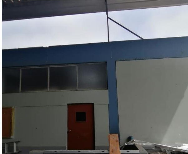
Figura 153. Tipo de cubierta del pabellón 6 Elaboración: Los autores
