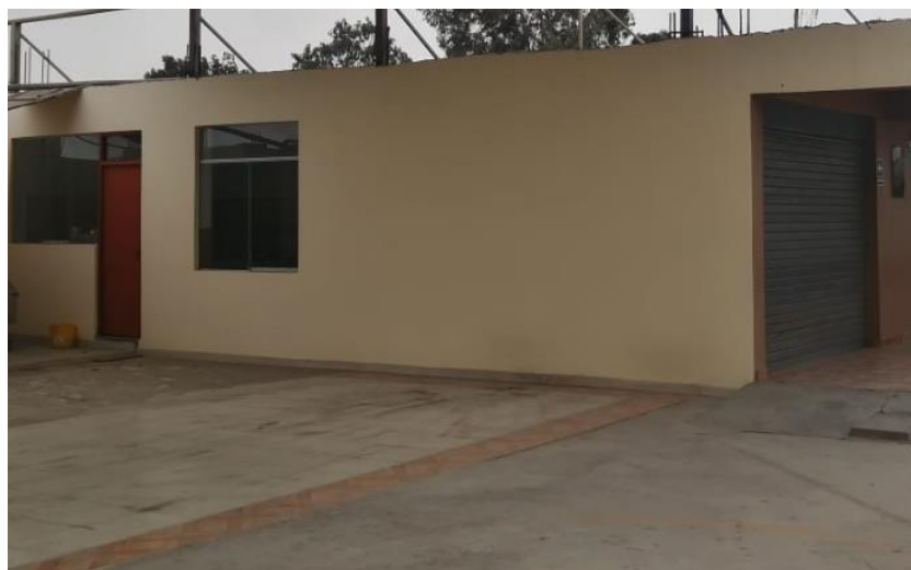
Figura 80. Estado de conservación del pabellón 4 Elaboración: Los autores
