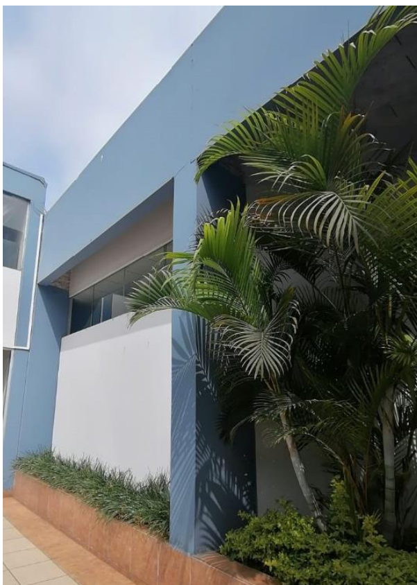
Figura 130. Elementos no estructurales del pabellón 4 Elaboración: Los autores
