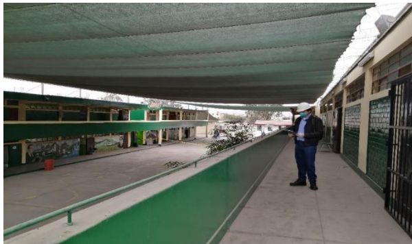
Figura 43 Elementos no estructurales del pabellón 1 Elaboración: Los autores
