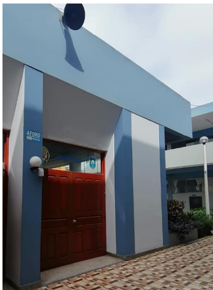
Figura 131. Estado de conservación del pabellón 4 Elaboración: Los autores
