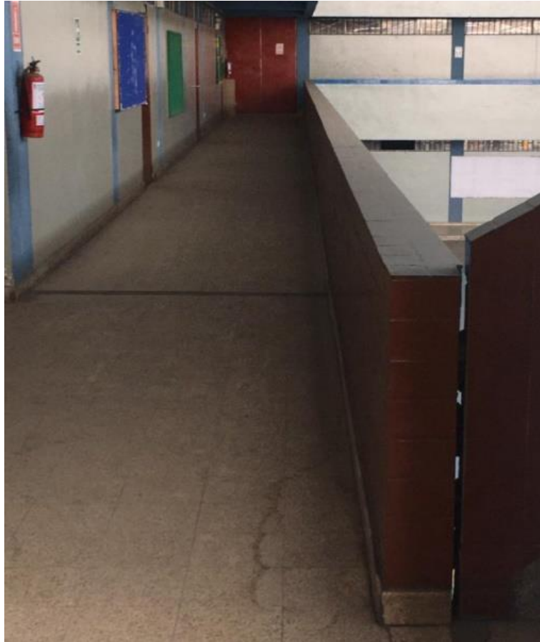
Figura 106. Elementos no estructurales del pabellón 2 Elaboración: Los autores
