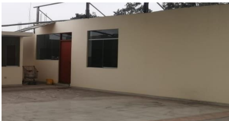
Figura 78. Tipo de cubierta del pabellón 4 Elaboración: Los autores
