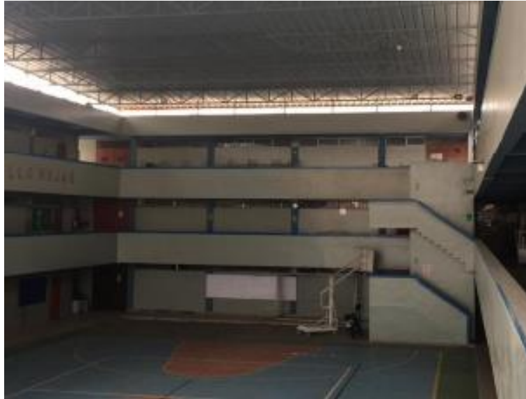
Figura 93. Tipo de cubierta del pabellón 1 Elaboración: Los autores
