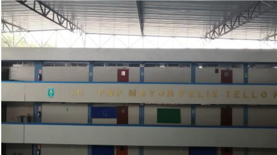
Figura 105. Tipo de cubierta del pabellón 2 Elaboración: Los autores
