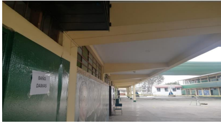
Figura 67. Elementos no estructurales del pabellón 3 Elaboración: Los autores
