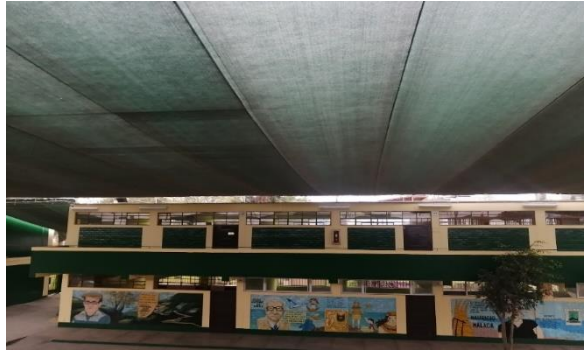
Figura 42 Tipo de cubierta del pabellón 1 Elaboración: Los autores
