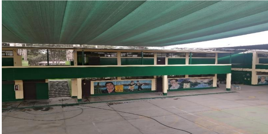
Figura 54. Tipo de cubierta del pabellón 2 Elaboración: Los autores
