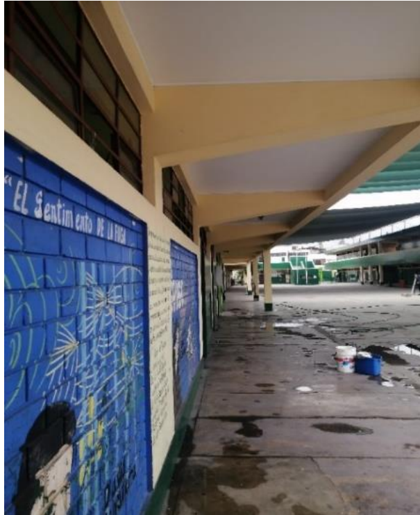
Figura 55. Elementos no estructurales del pabellón 2 Elaboración: Los autores
