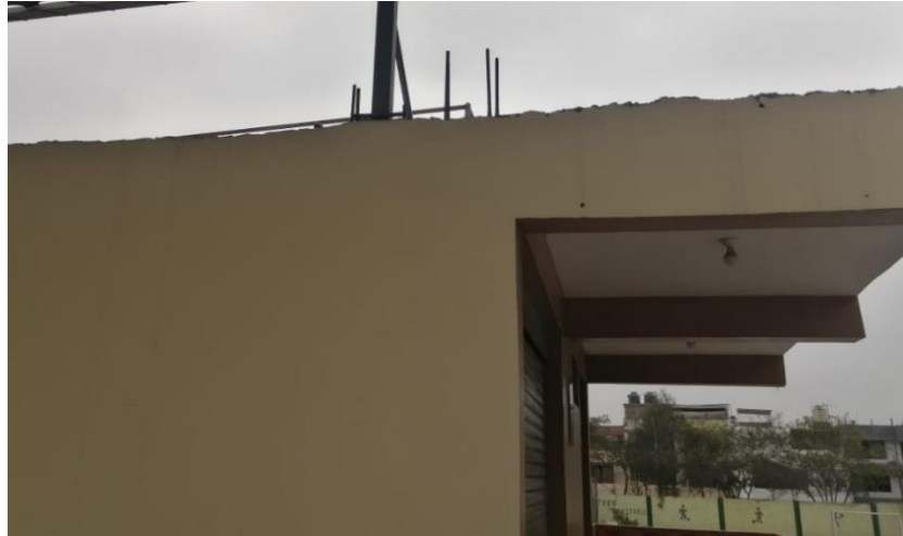
Figura 79. Elementos no estructurales del pabellón 4 Elaboración: Los autores
