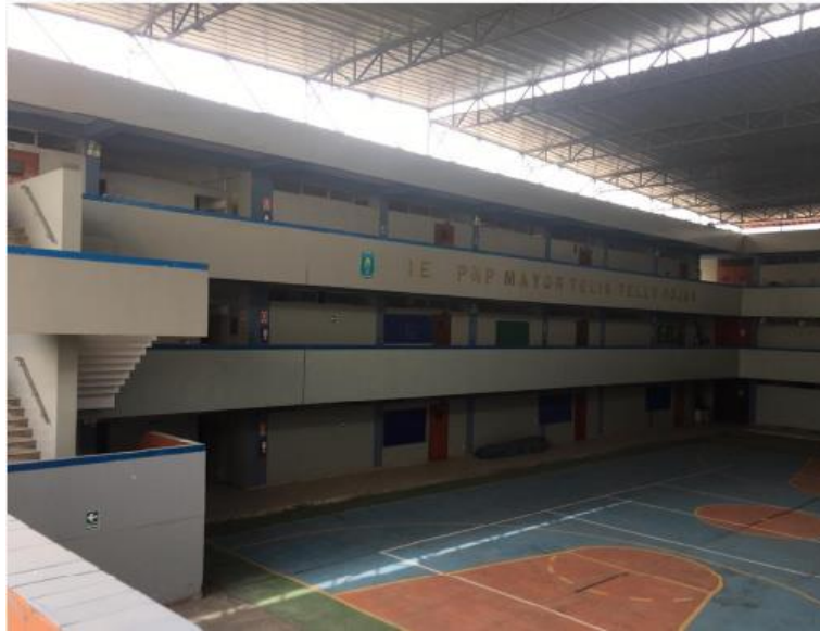
Figura 107. Estado de conservación del pabellón 2 Elaboración: Los autores
