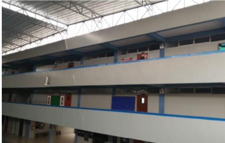
Figura 117. Tipo de cubierta del pabellón 3 Elaboración: Los autores
