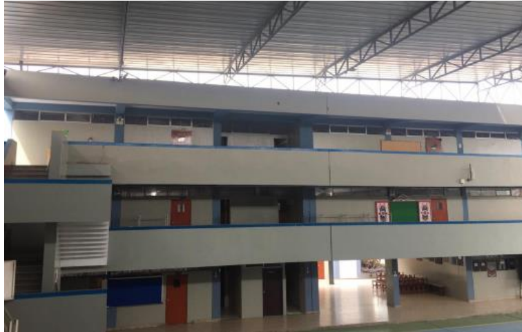
Figura 119. Estado de conservación del pabellón 3 Elaboración: Los autores
