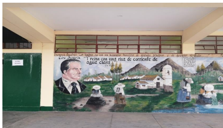
Figura 32. Estado de conservación del pabellón 1 Elaboración: Los autores
