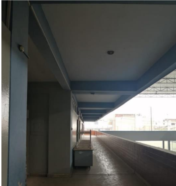
Figura 118. Elementos no estructurales del pabellón 3 Elaboración: Los autores
