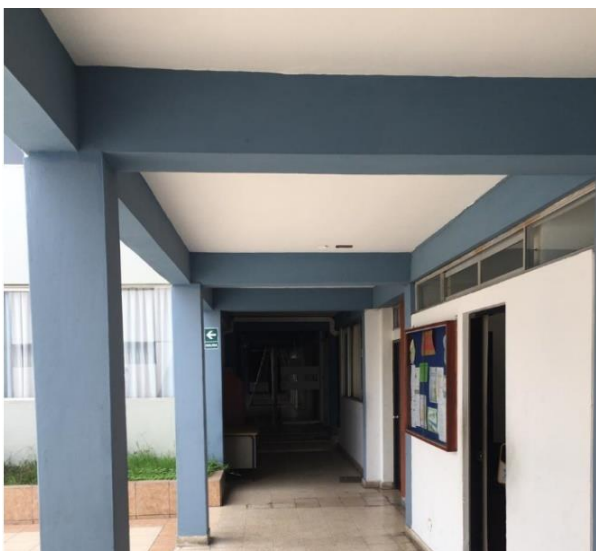
Figura 94. Elementos no estructurales del pabellón 1 Elaboración: Los autores
