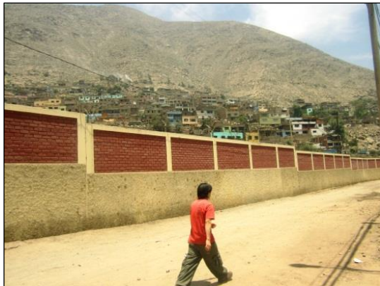
Imagen N° 29 Muro perimétrico del ferrocarril
