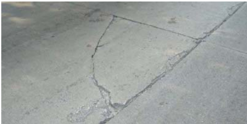
Figura 32. Grieta de esquina.
