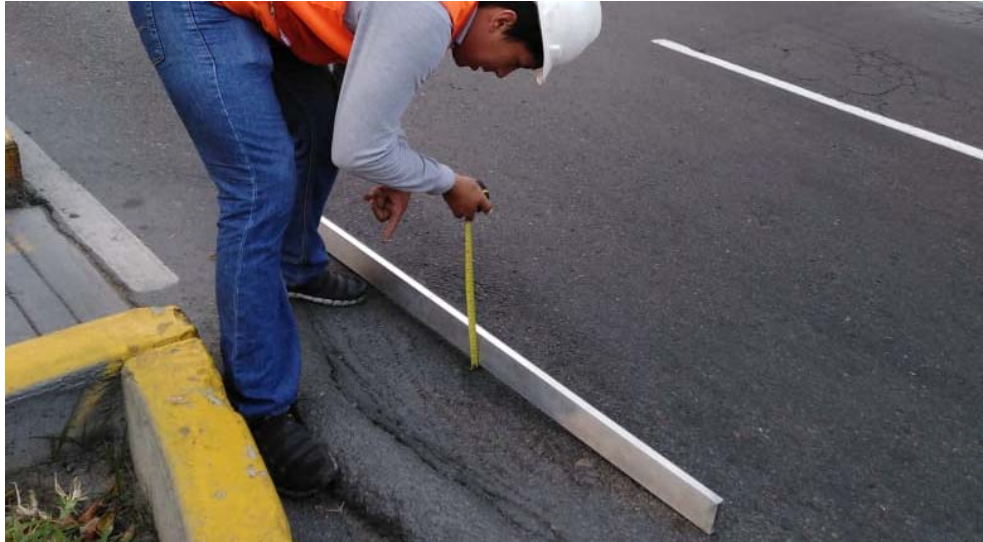
Figura 15. Abultamientos y hundimientos en avenida Los Constructores en La Molina, Lima - Perú.
