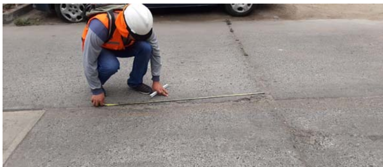
Figura 49. Descascaramiento de junta en jirón Ricardo Palma, La Molina - Perú.
