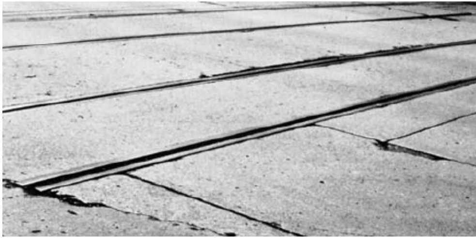
Figura 45. Cruce de vía férrea.
