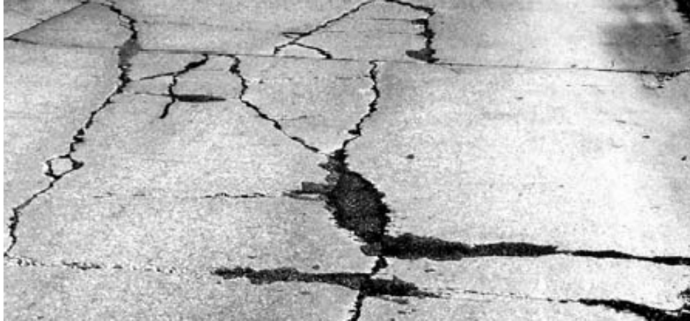
Figura 33. Losa dividida.
