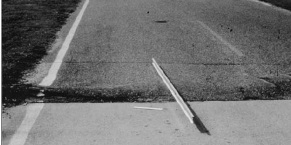
Figura 27. Desplazamiento.
