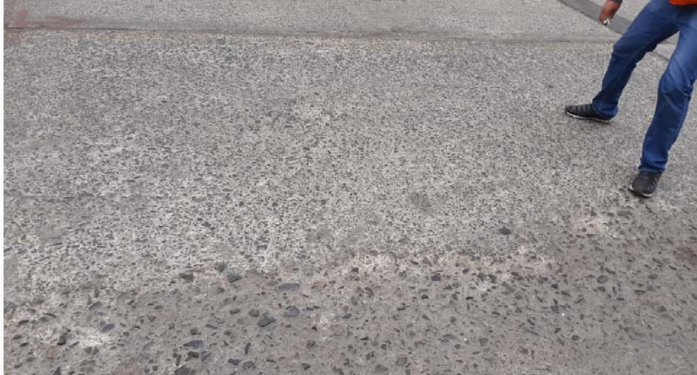
Figura 41. Pulimiento de agregados en jirón Ricardo Palma, La Molina - Perú.
