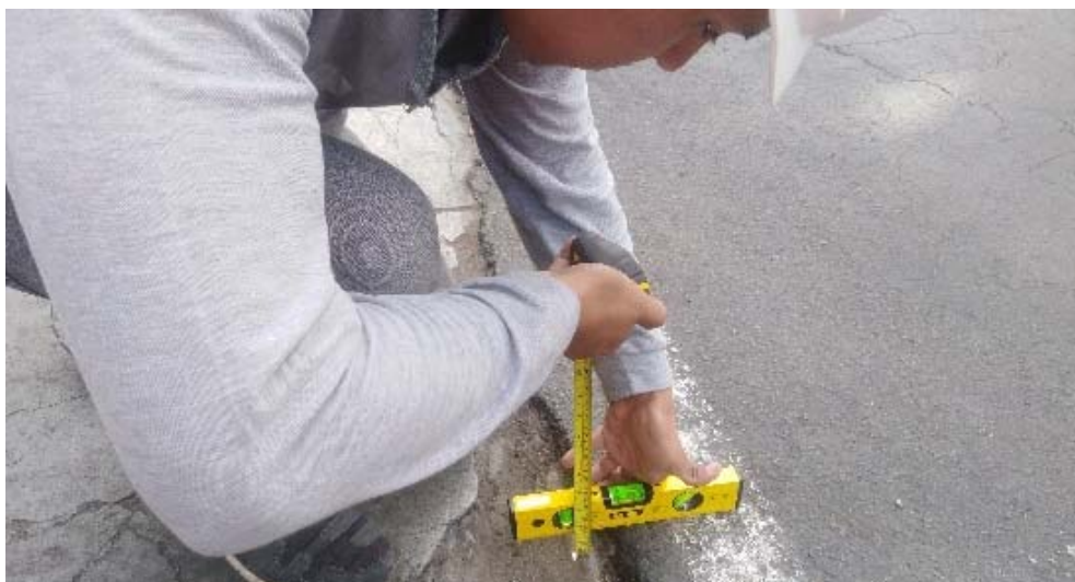
Figura 20. Desnivel carril/berma en avenida Los Constructores en La Molina, Lima - Perú.
