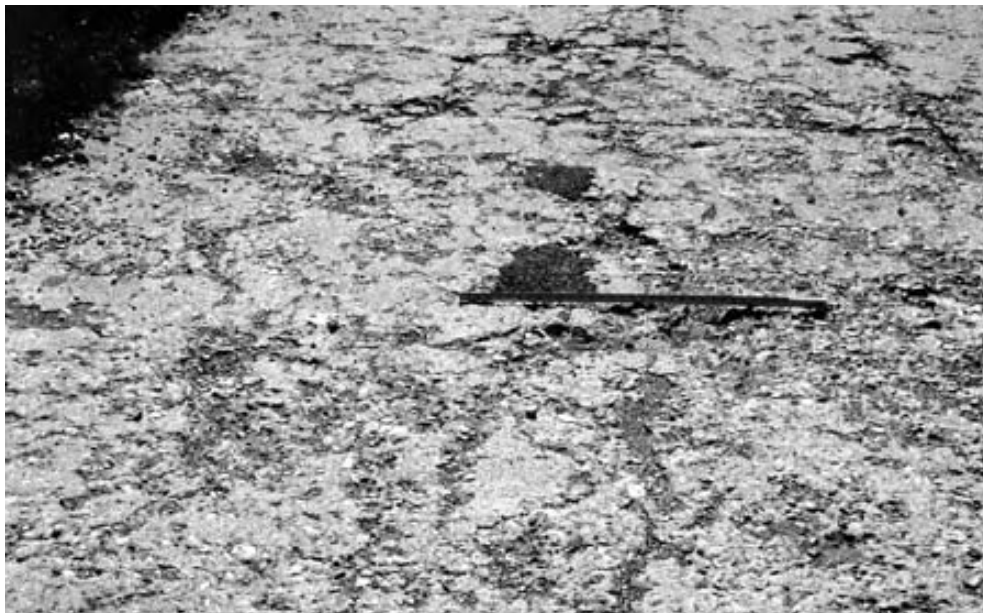
Figura 46. Desconchamiento o craquelado.
