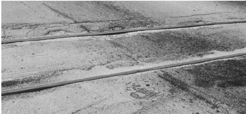
Figura 25. Cruce de vía férrea.
