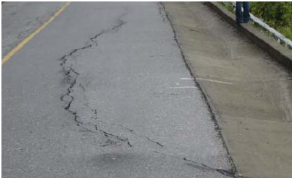
Figura 28. Grieta parabólica.
