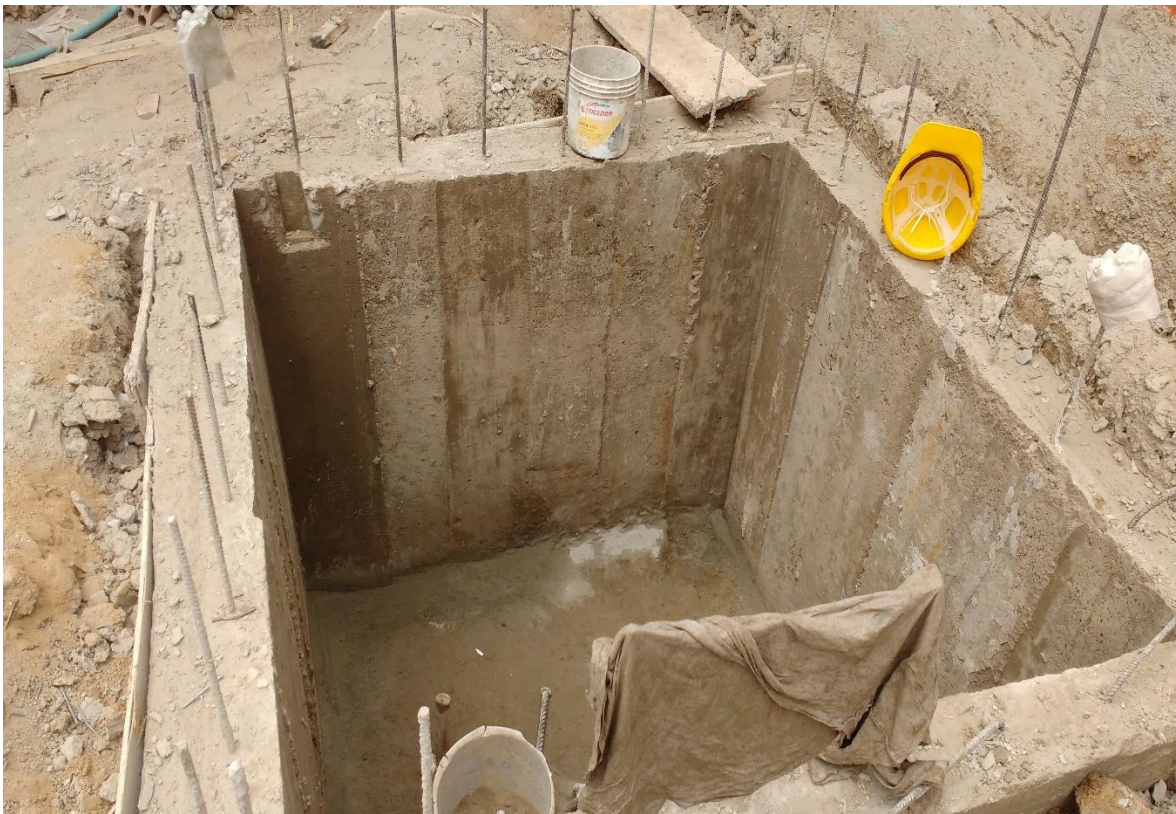
Descripción: Se observa la cisterna después de haber sido desencofrada
