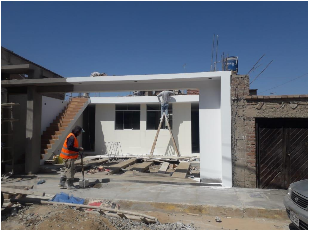
Descripción: Se observa trabajos de limpieza
