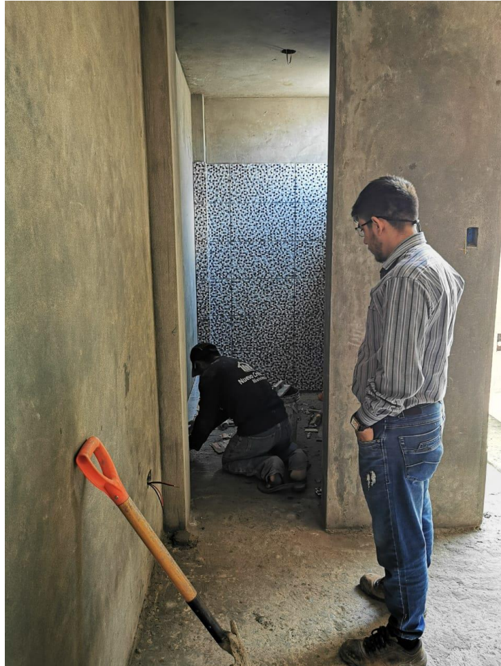
Descripción: Se observa trabajos de asentado de cerámica
