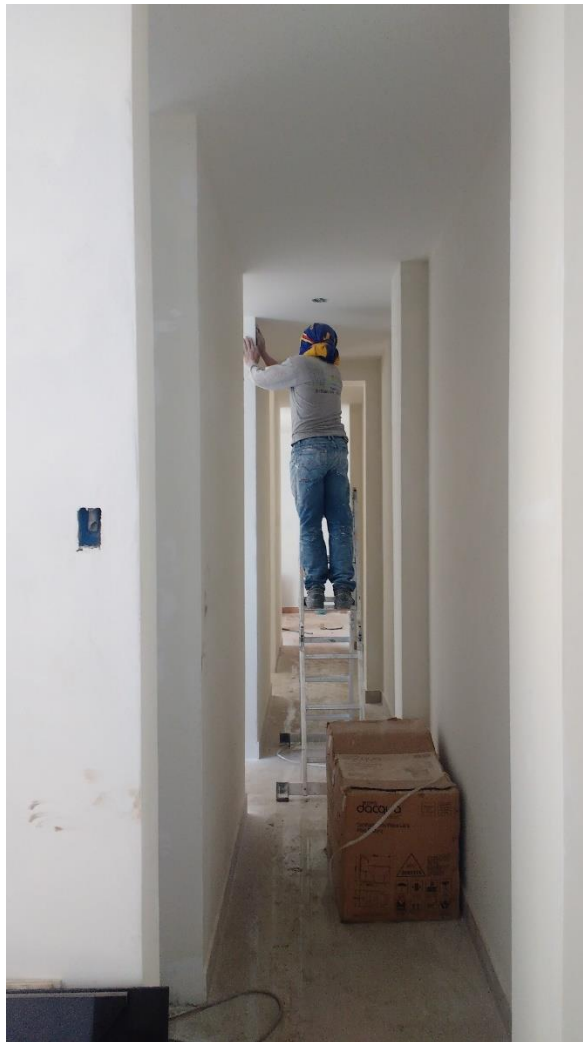
Descripción: Se observar trabajos de pintado en pasadizos
