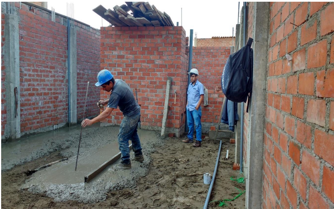
Descripción: Se observa el llenado del falso piso
