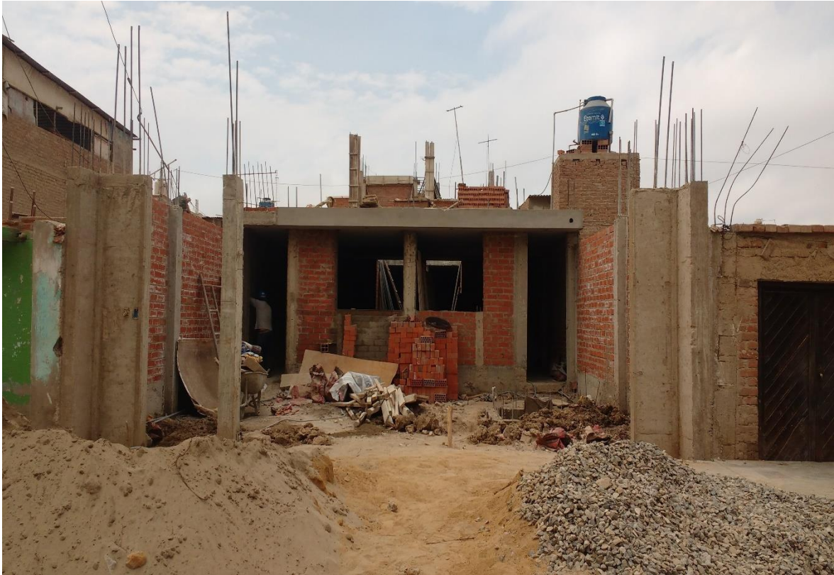
Descripción: Se observa El pórtico de la falsa fachada
