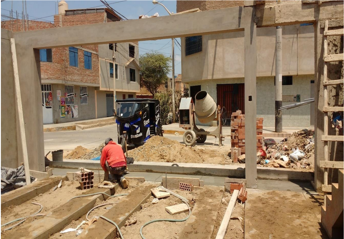
Descripción: Se observa trabajos de llenado de vereda de ingreso
