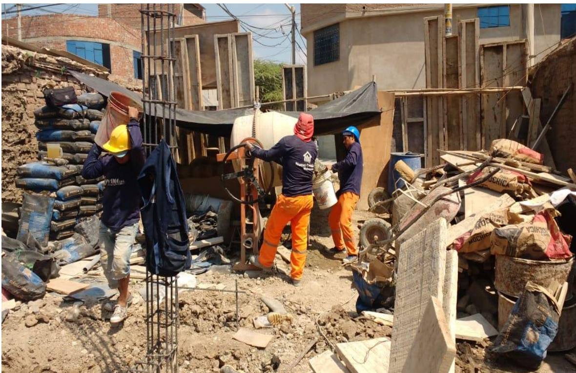
Descripción: Se observa trabajos de llenado de concreto
