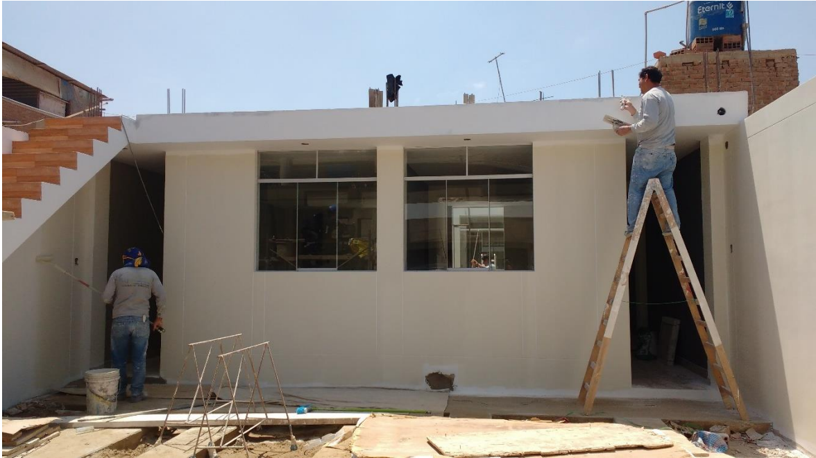
Descripción: Se observa trabajos de pintado de fachada
