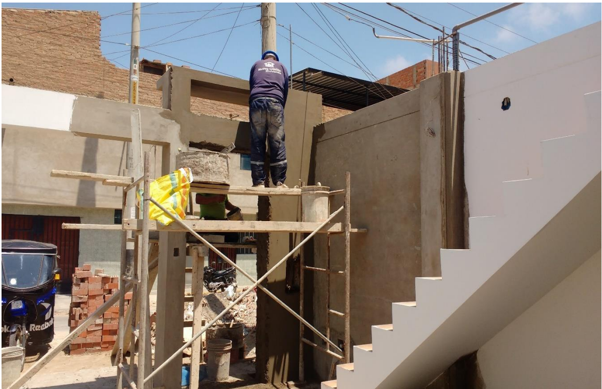
Descripción: Se observa trabajos de tarrajeo de falsa fachada
