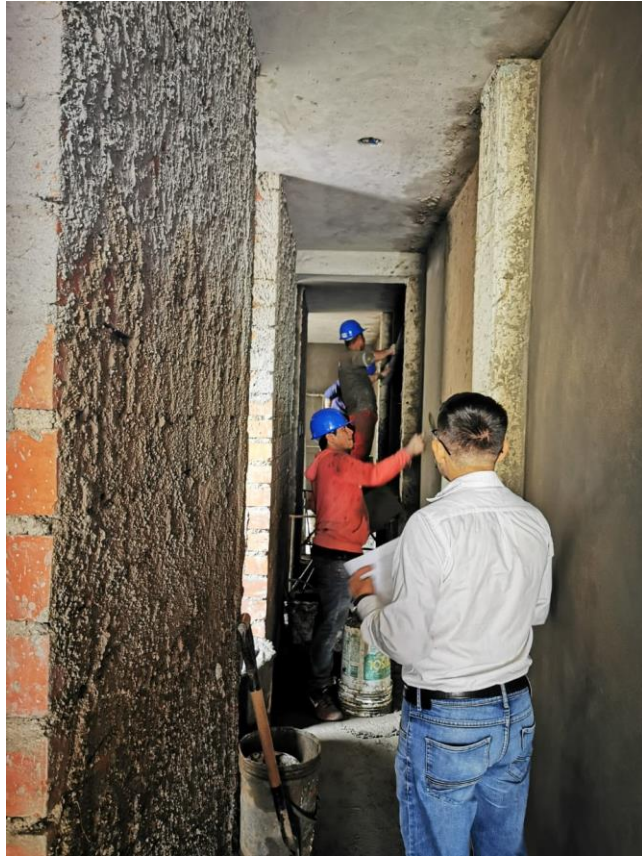
Descripción: Se observa trabajos de tarrajeo de muros
