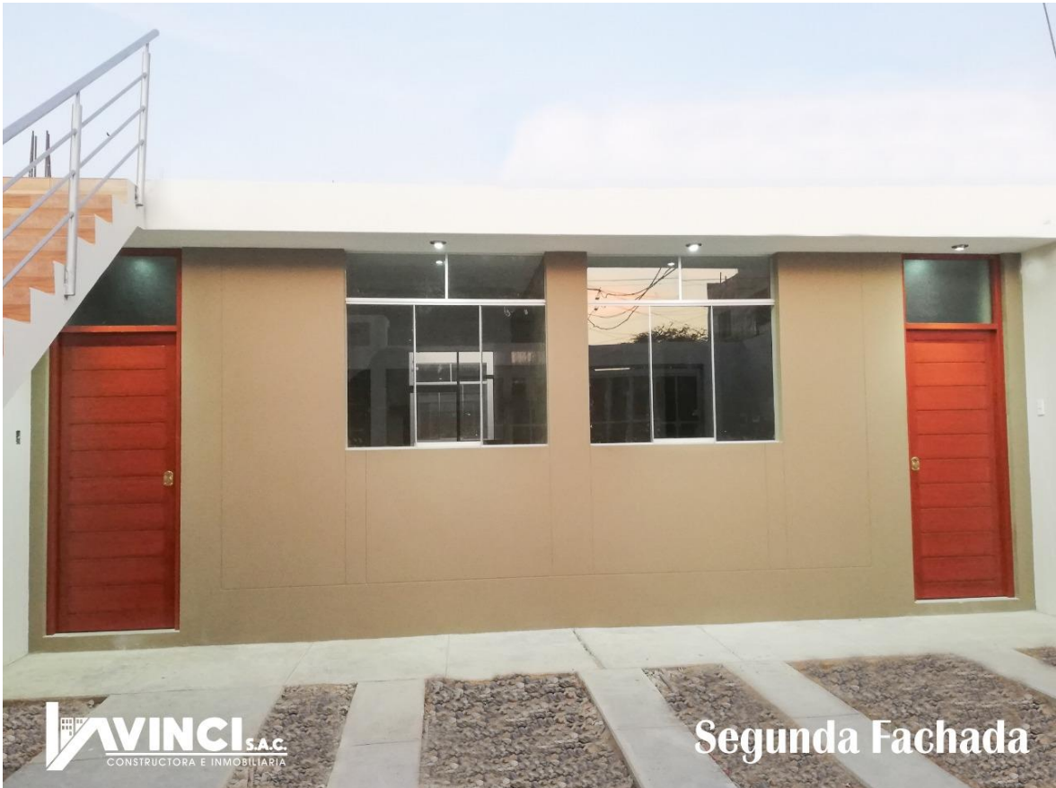
Descripción: Se observa la fachada de ingreso terminada
