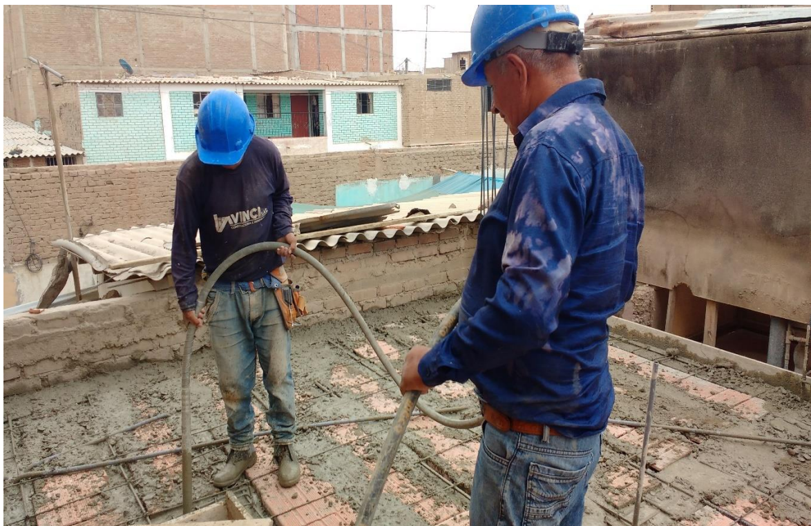
Descripción: Se observa trabajos con la vibradora en llenado de techo
