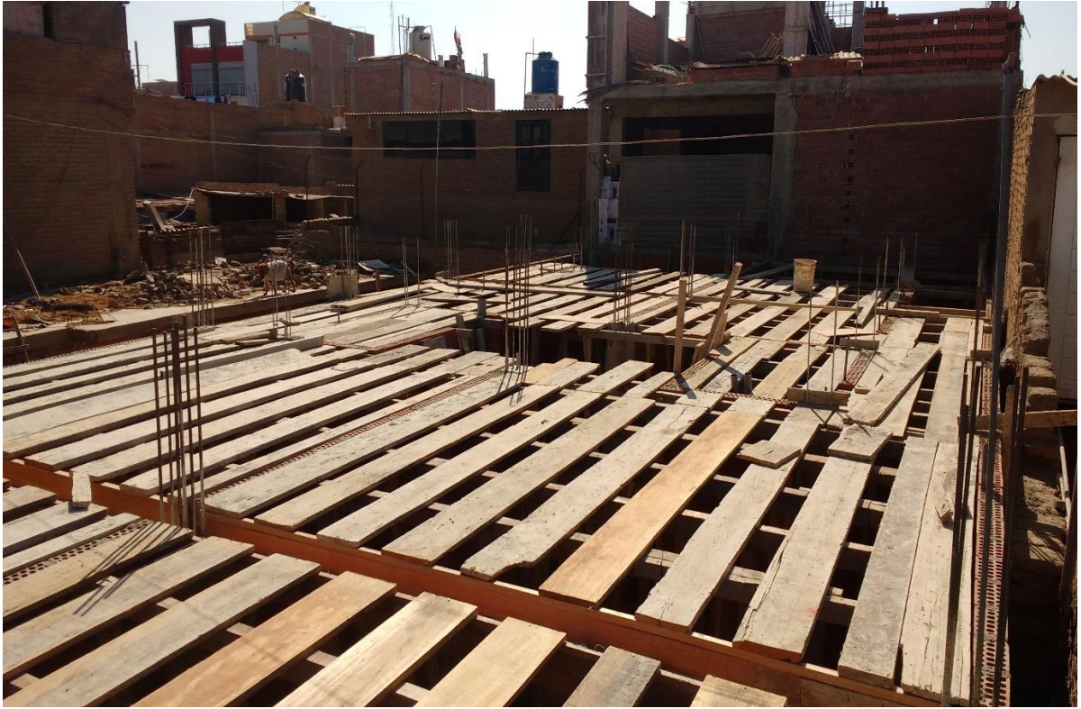
Descripción: Se observa la habilitación de encofrado para llenado de techo
