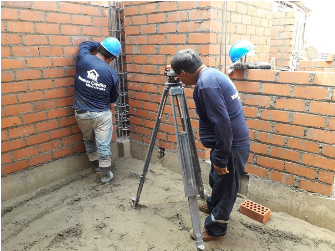
Descripción: Se observa trabajos de nivelación para falso piso
