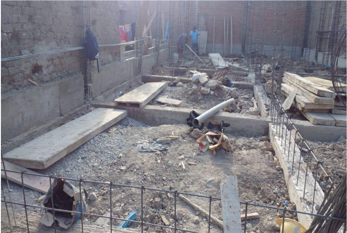
Descripción: Se observa el acero habilitado para el sobrecimiento
