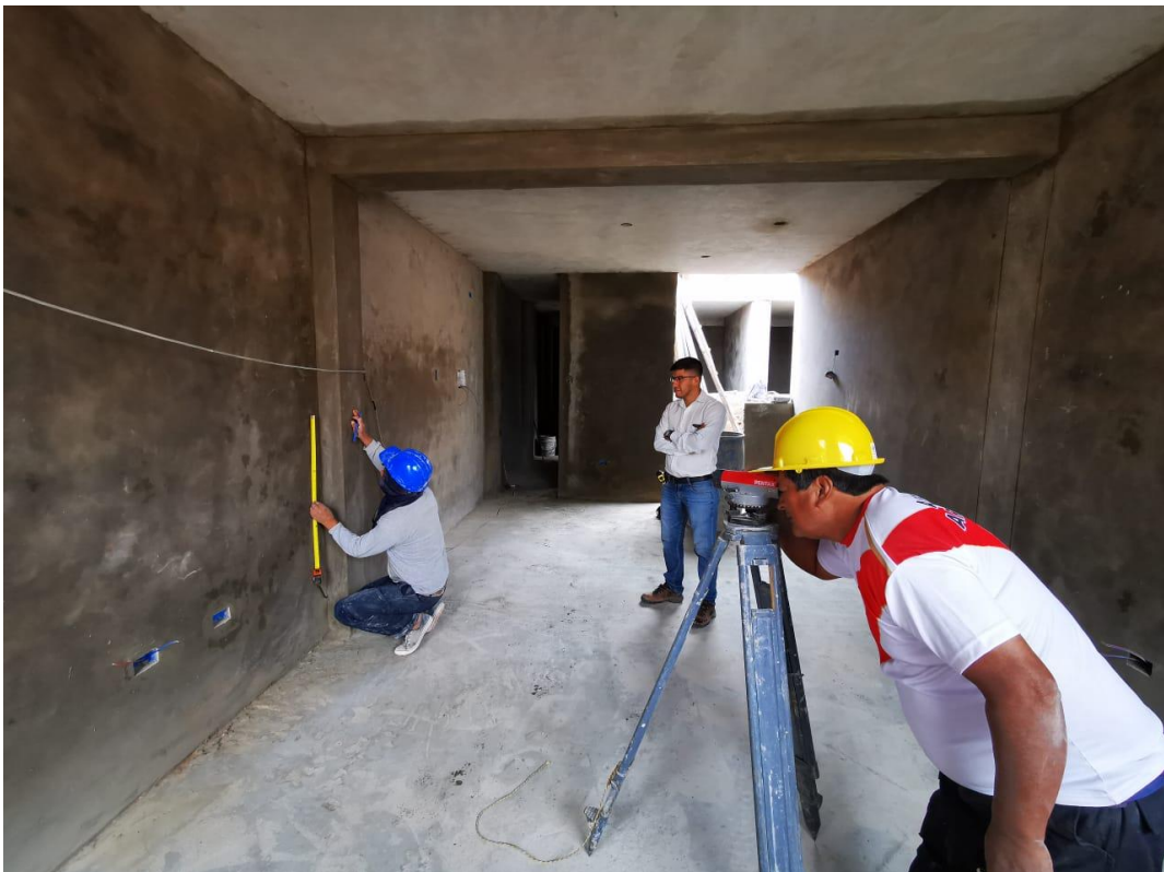
Descripción: Se observa trabajos de nivelación para contrapiso
