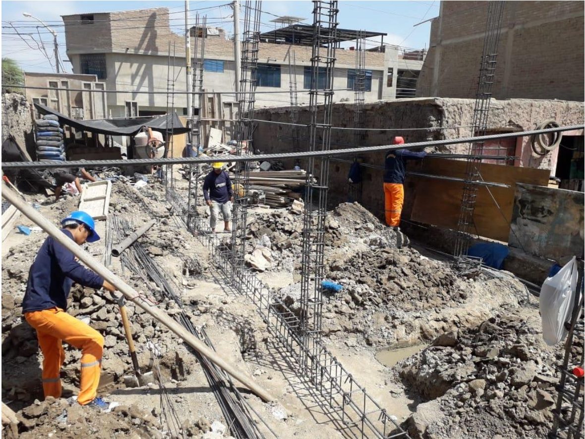
Descripción: Se observa Trabajos de movimiento de tierras, encofrado, y vigas de cimentación
