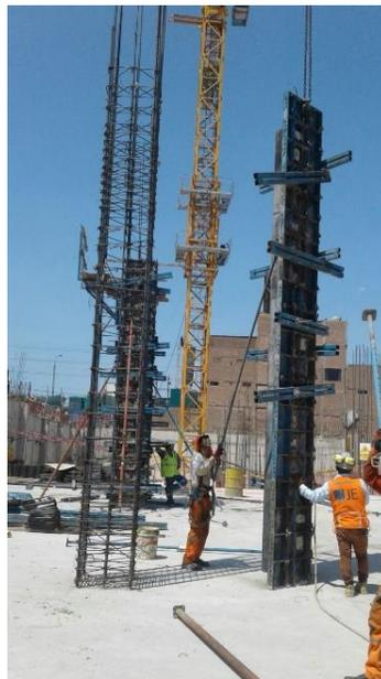
Columna armada y colocando encofrado con ayuda de torre grua
