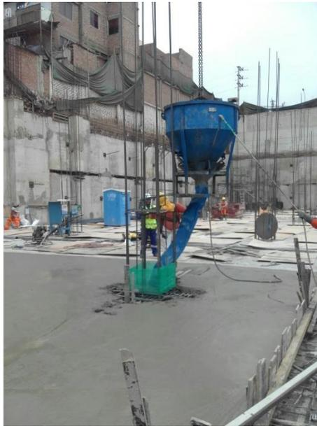
Vaciado de losa 0.15 m de espesor utilizando balde de concreto y torre grua
