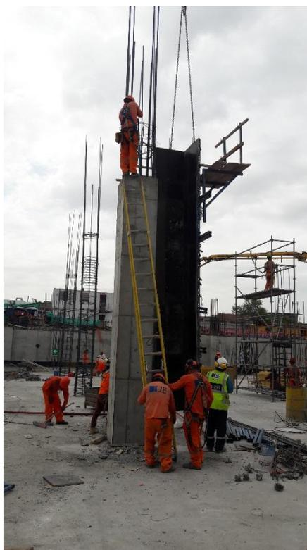
Figura N° 14: Encofrado de columna con torre grúa
