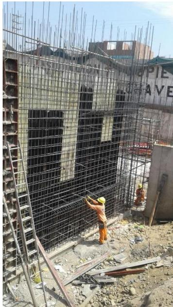
Refuerzo de placa doble altura lista para encofrar
