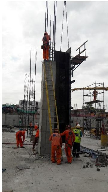
Desenfofrado de columna de doble altura utilizando torre grua
