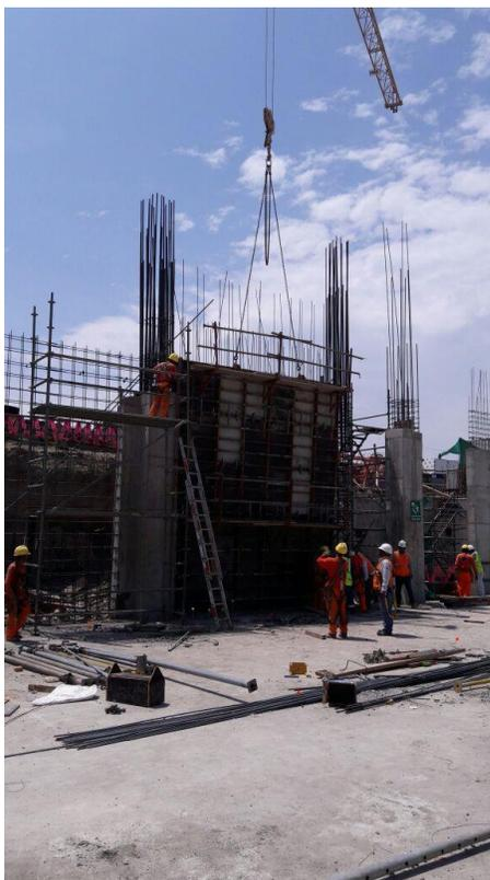
Figura N° 15: Encofrado de placa con torre grúa
