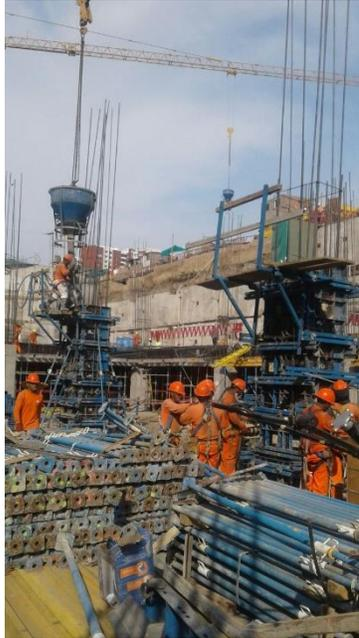
Vaciado de columna utilizando balde de concreto y torre grua
