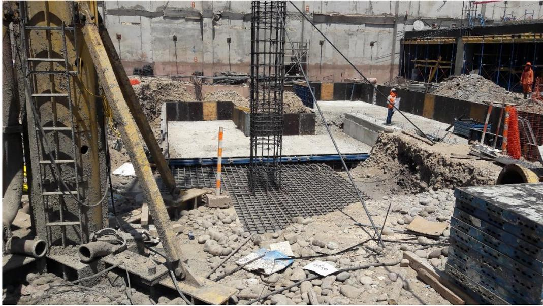
Figura N° 16: Colocación de acero en columna prefabricada
