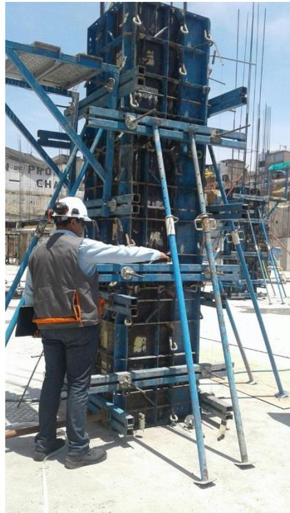
Medición de verticalidad de encofrado de columna
