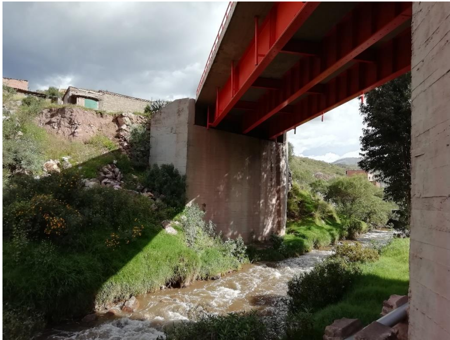
Ilustración 31: Vista de la elevación aguas arriba del Puente Huambutio I
