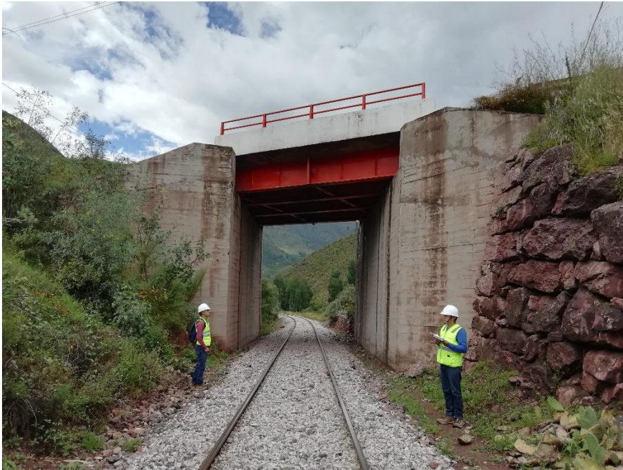
Ilustración 73: Vista de la elevación noreste del Pontón Huambutio II
