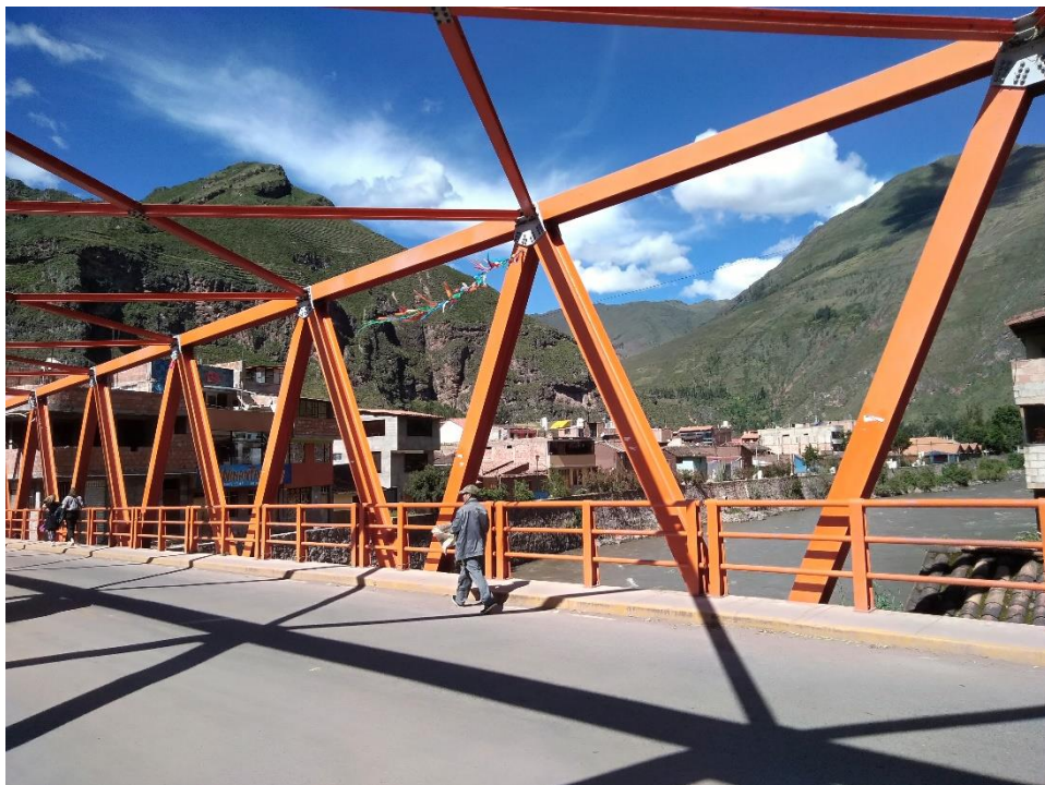
Ilustración 164: Vista superior de la estructura reticulada del Puente Pisac
