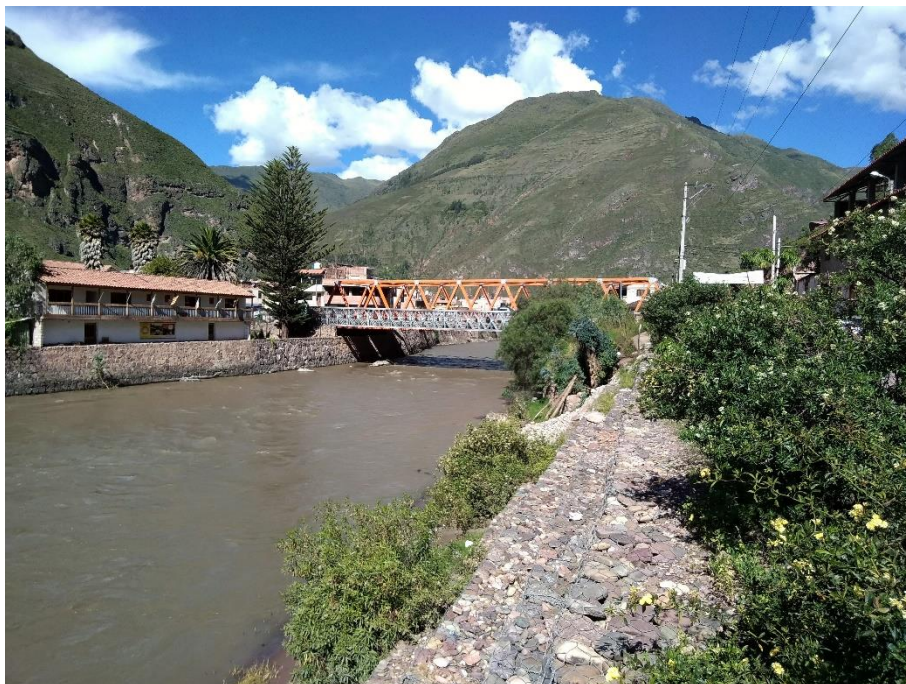
Ilustración 140: Vista de la elevación aguas abajo del Puente Pisac
