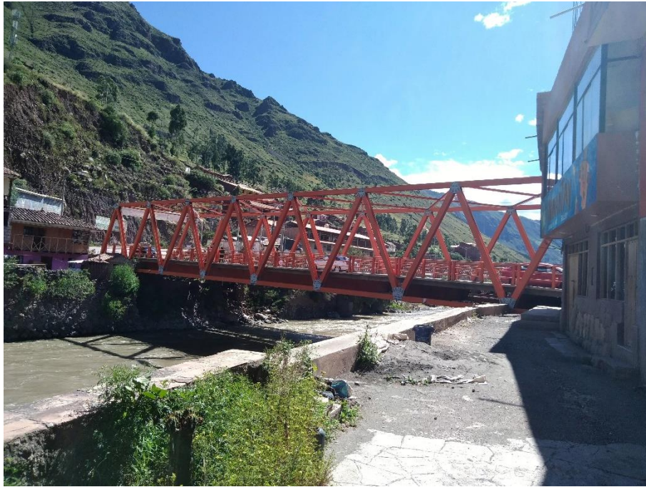
Ilustración 139: Vista de la elevación aguas arriba del Puente Pisac
