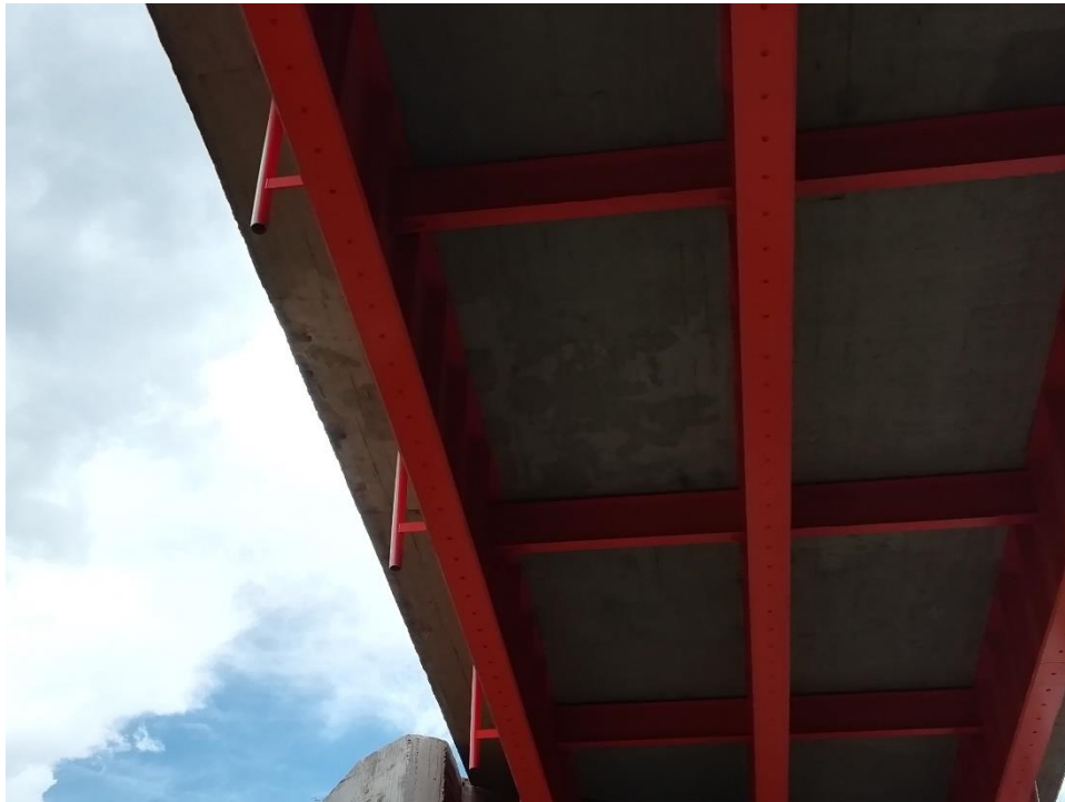
Ilustración 37: Vista de vigas principales del Puente Huambutio I
