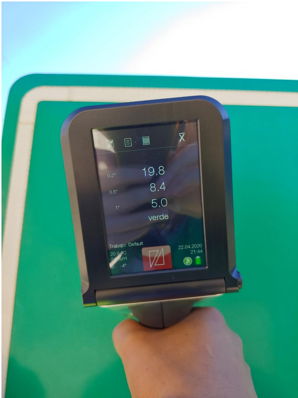
Ilustración 186: Vista de retroreflectividad en señalización vertical verde I – 18 ( \mu.0.2^\circ=19.8 ) del Puente Pisac
