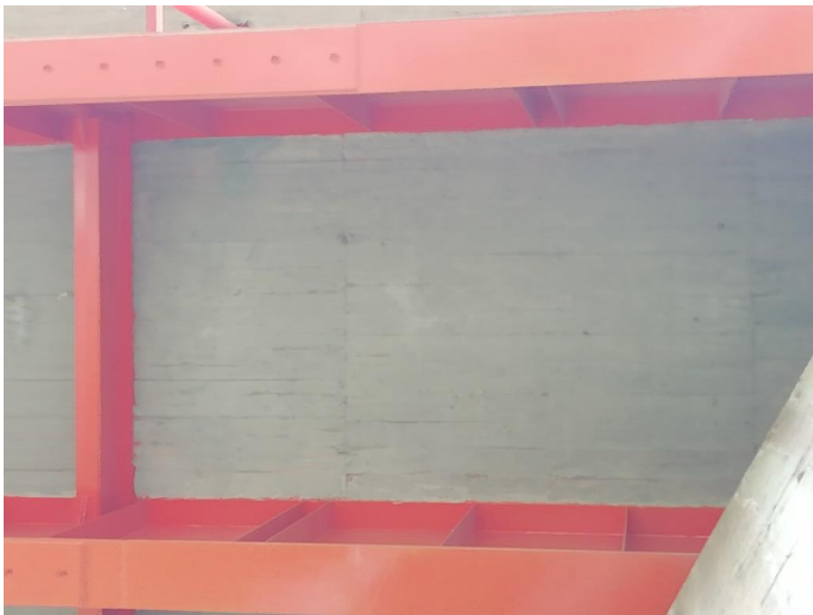
Ilustración 38: Vista de vigas principales del Puente Huambutio I
