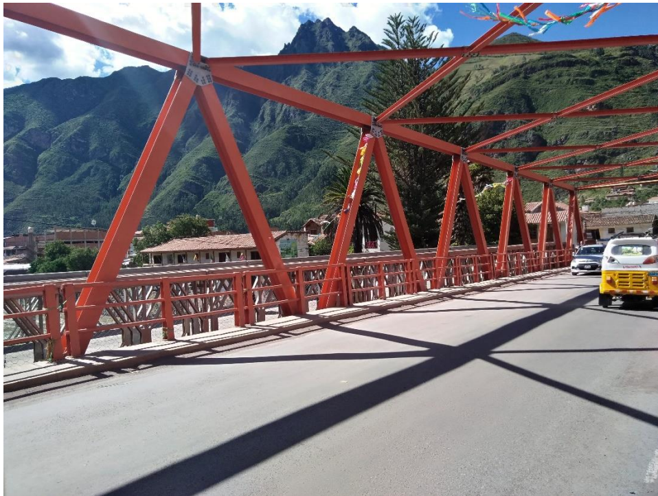
Ilustración 163: Vista superior de la estructura reticulada del Puente Pisac
