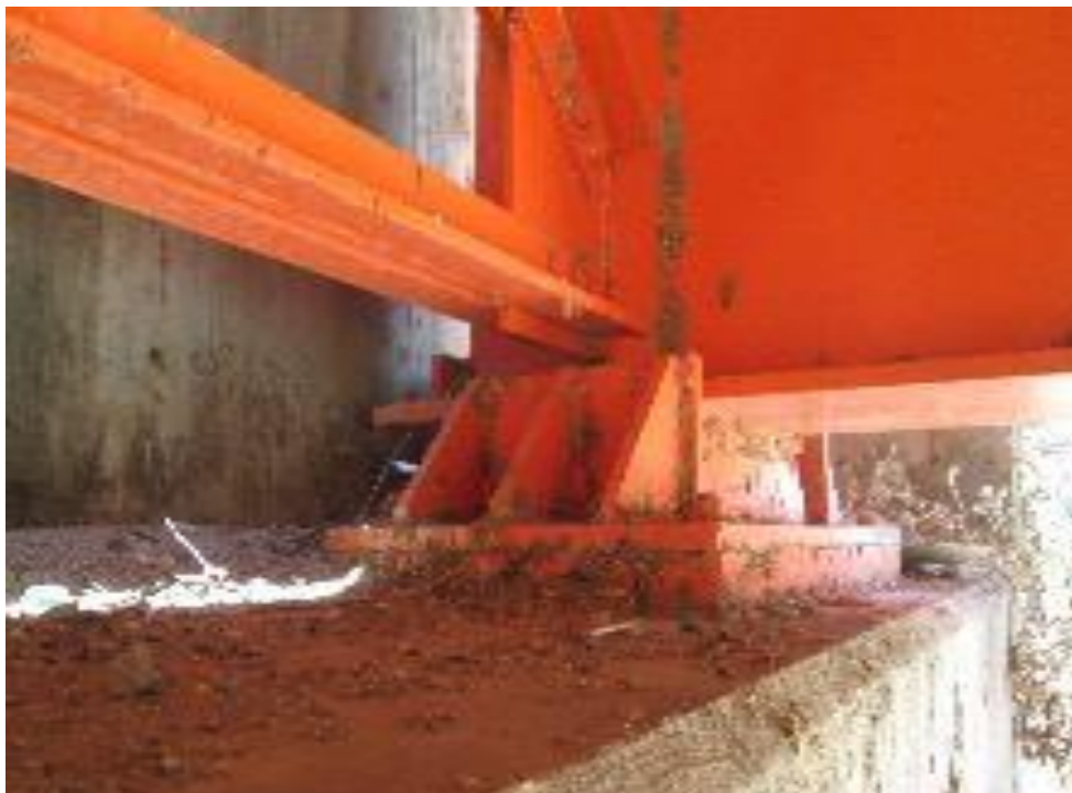
Ilustración 44: Vista del apoyo fijo de neopreno del Puente Huambutio I
