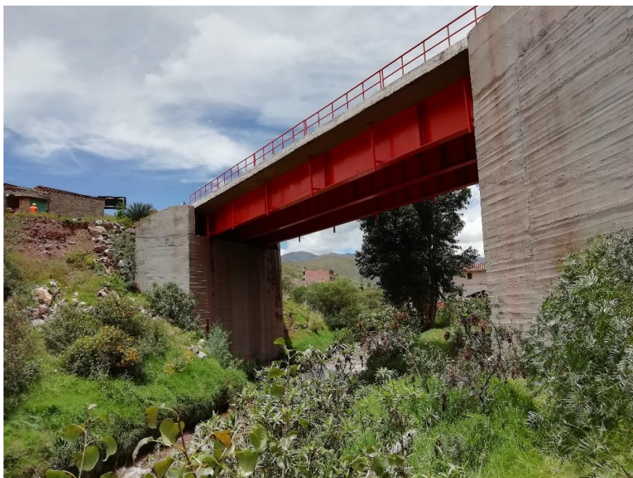
Ilustración 32: Vista de la elevación aguas abajo del Puente Huambutio I
