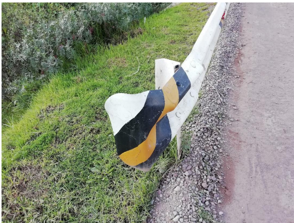
Ilustración 66: Vista del guardavía derecho del Puente Huambutio I
