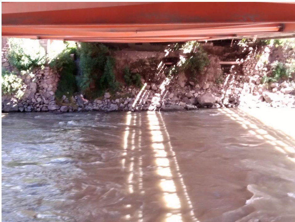
Ilustración 142: Vista del cuerpo del estribo izquierdo del Puente Pisac
