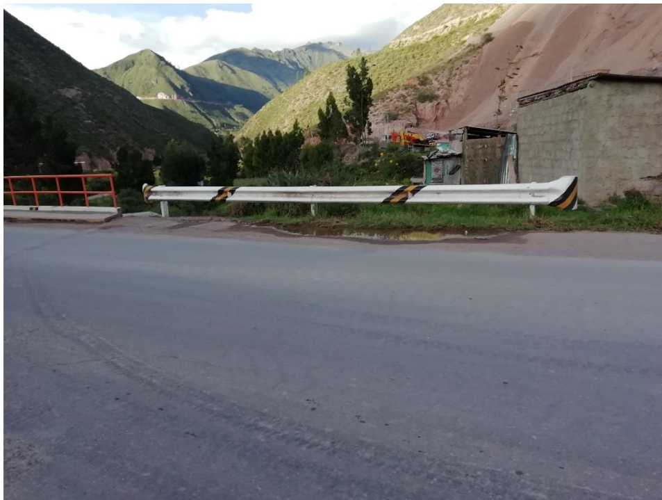
Ilustración 65: Vista del guardavía derecho del Puente Huambutio I
