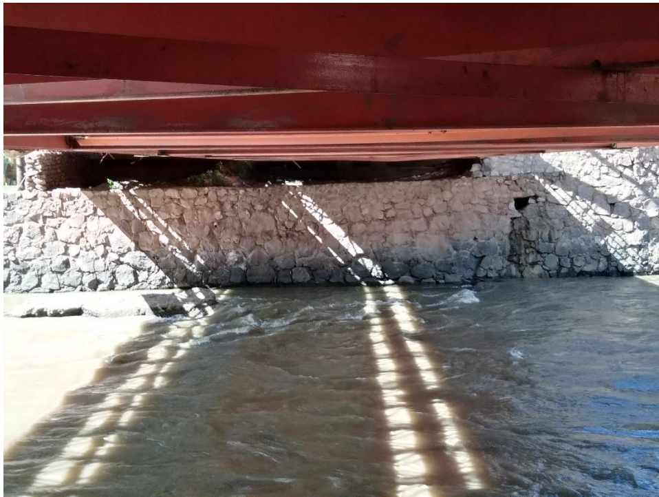
Ilustración 141: Vista del cuerpo del estribo derecho del Puente Pisac
