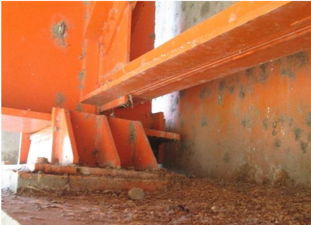
Ilustración 43: Vista del apoyo fijo de neopreno del Puente Huambutio I
