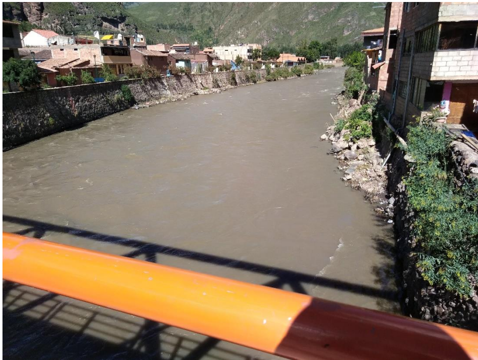
Ilustración 179: Vista del lecho del río aguas arriba del Puente Pisac
