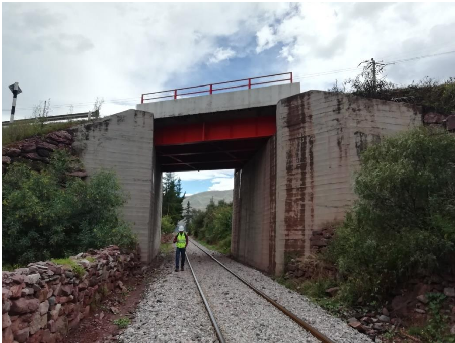
Ilustración 74: Vista de la elevación noroeste del Pontón Huambutio II
