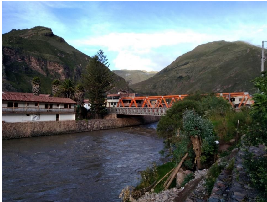
Ilustración 116: Vista de la elevación aguas abajo del Puente Modular Pisac
