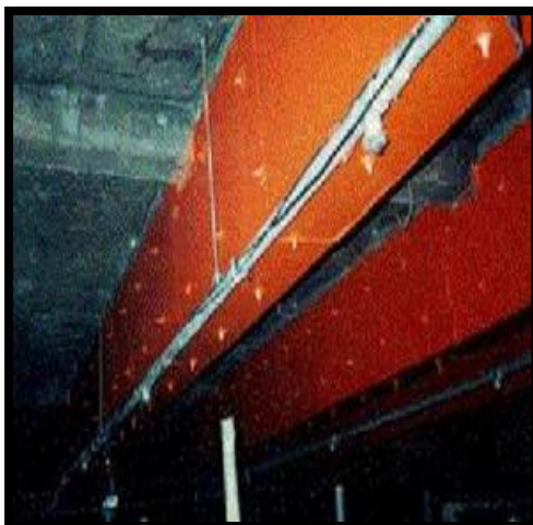
Figura N°8 Planchas de acero en vigas
