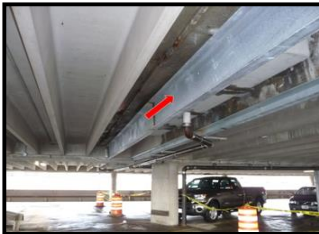
Figura N°31 Viga suplementaria
