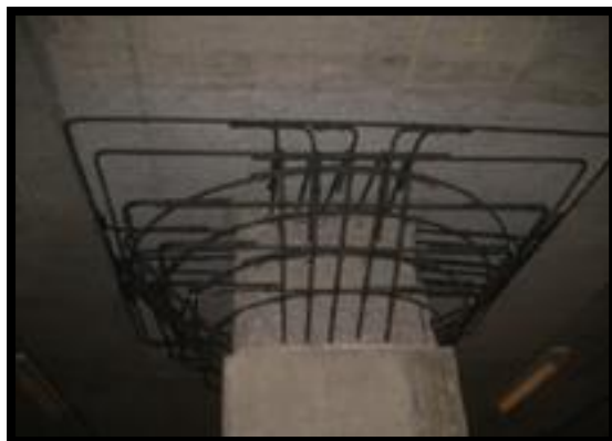
Figura N°34 Colocación de capiteles de concreto para disminuir efectos de punzonamiento.
