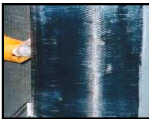
Figura N°5 Columna encamisetada con fibra de carbono
