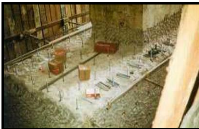
Figura N°2 Colocación de conectores en la cimentación
