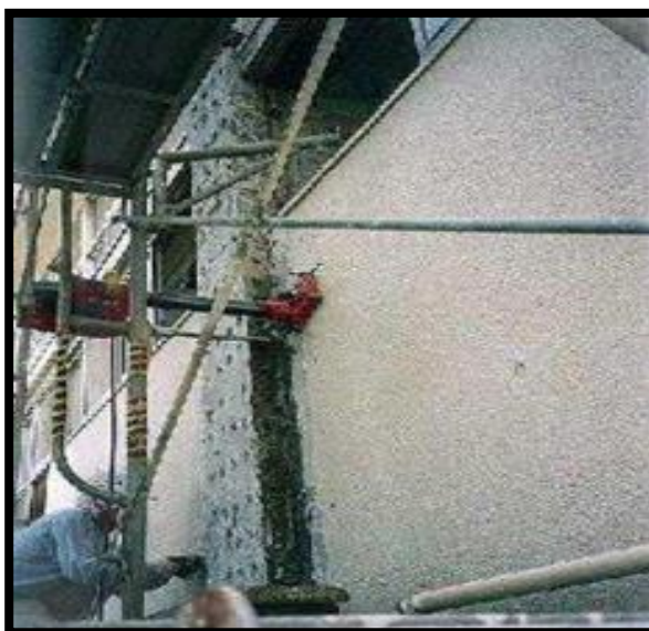
Figura N°3 Ubicación de anclaje en columna
