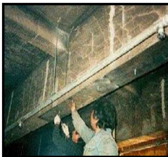
Figura N°9 Colocación de pernos para bandas de acero
