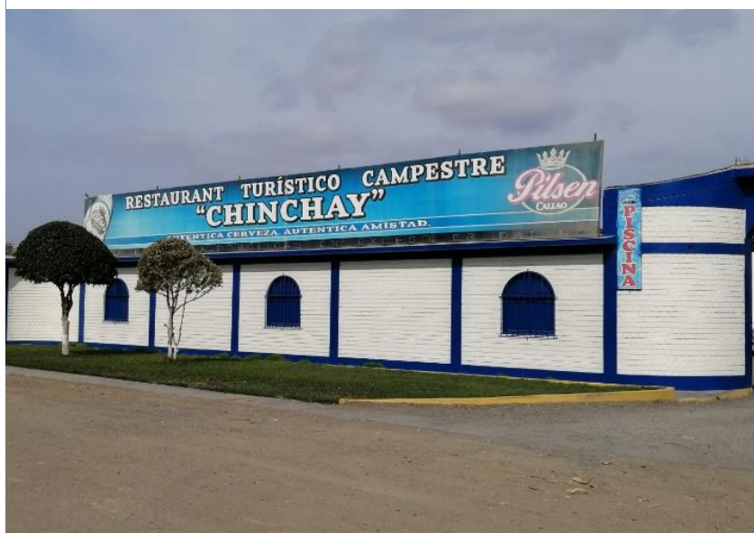
Figura 33. Fachada del Restaurante "CHINCHAY"
