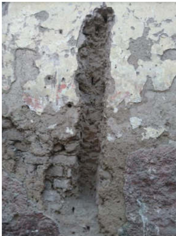
Figura 61. No presentan homogeneidad en bloques de adobe
