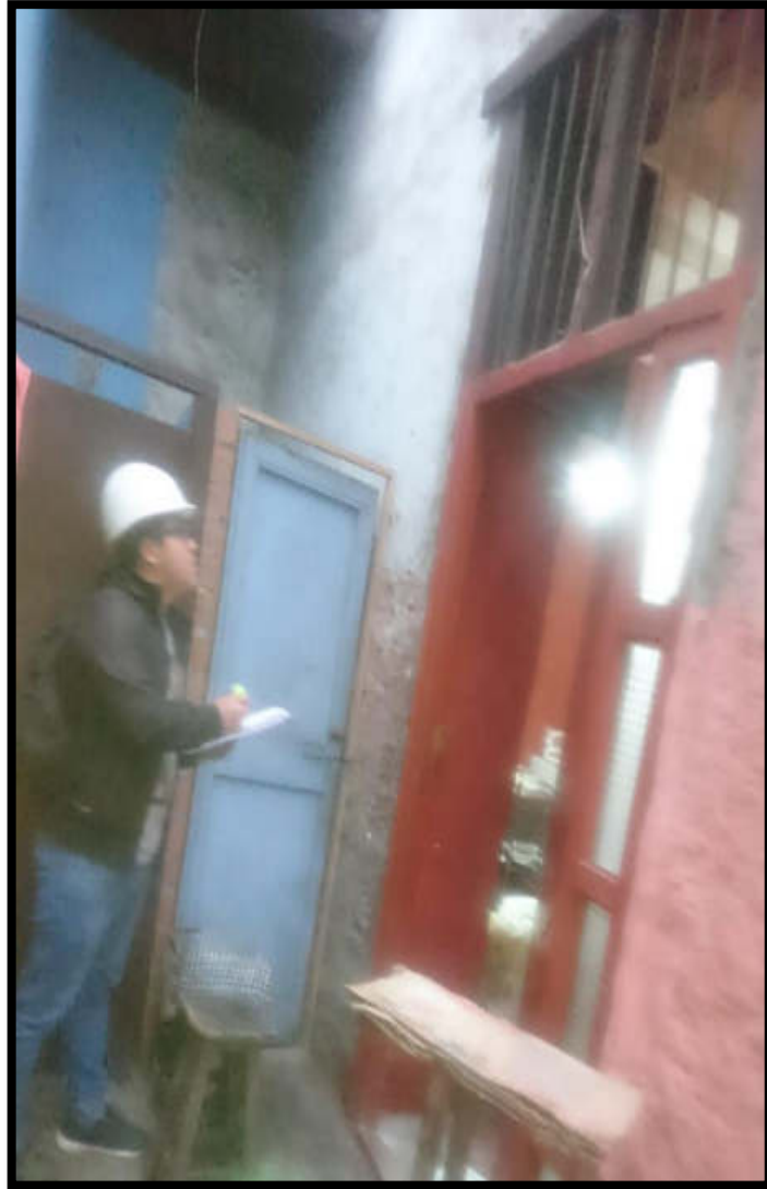
Figura 13. Edificación de adobe solo con elementos horizontales
