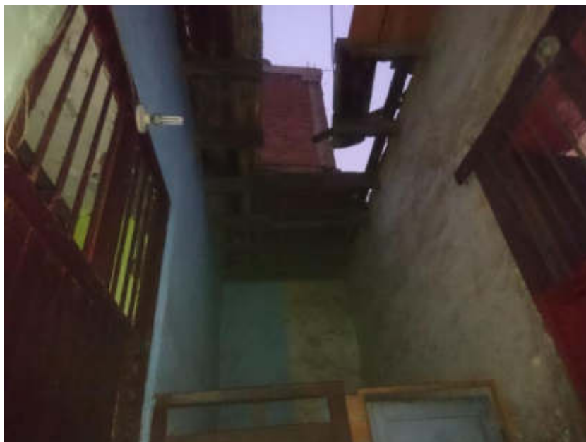
Figura 42. Elementos no estructurales
