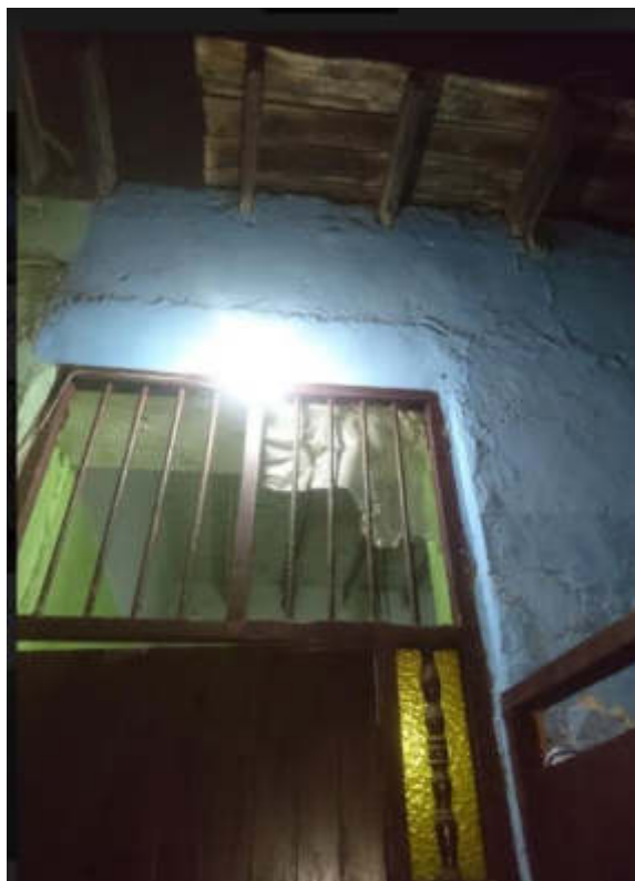
Figura 65.. Elemento no estructural
