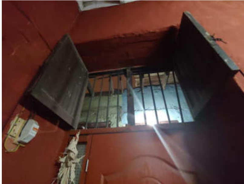
Figura 66. Elemento no estructural
