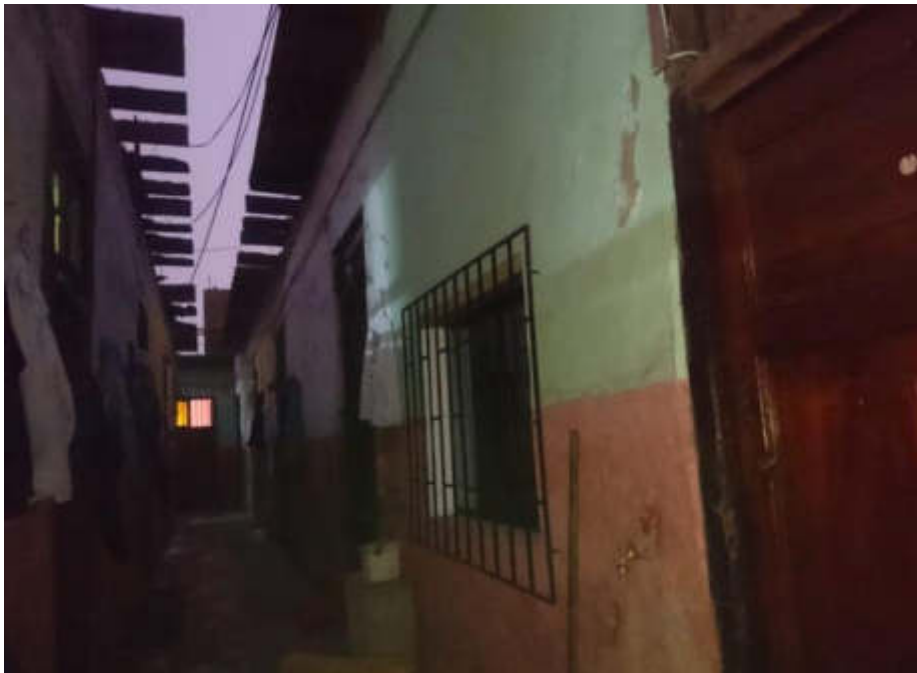
Figura 59. Cobertura de la vivienda en buen estado
