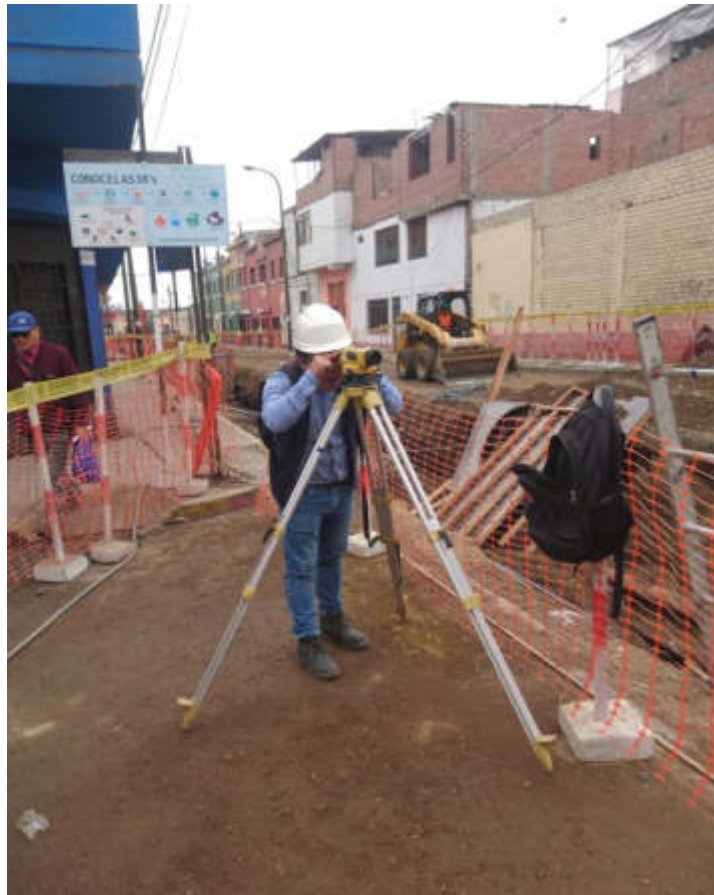
Figura 43. Utilización de teodolito para determinar la pendiente Fuente: Elaborada por el autor
