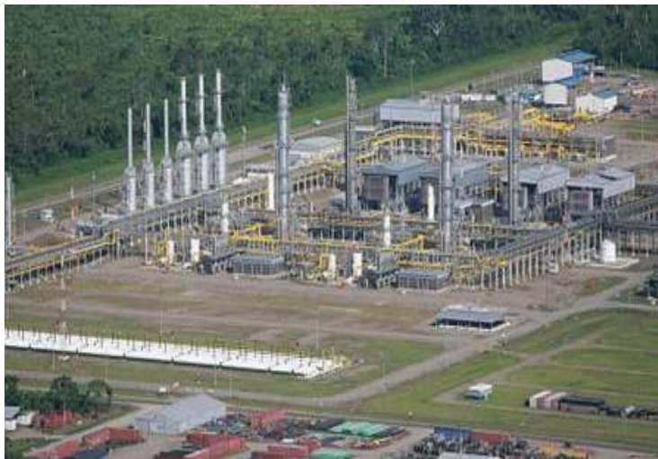
Figura 6: Planta de separación Malvinas Fuente: OSINERMING (2018)
