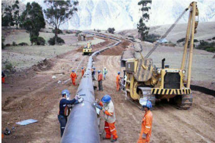
Figura 7: Instalación de un gasoducto Fuente: Pro Inversión (2016)
