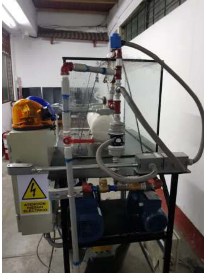
Figura 60. Bomba hidráulica principal (izquierda) y bomba hidráulica jockey (derecha).
