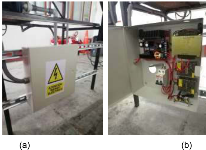
Figura 65. Panel de fuentes de alimentación.
