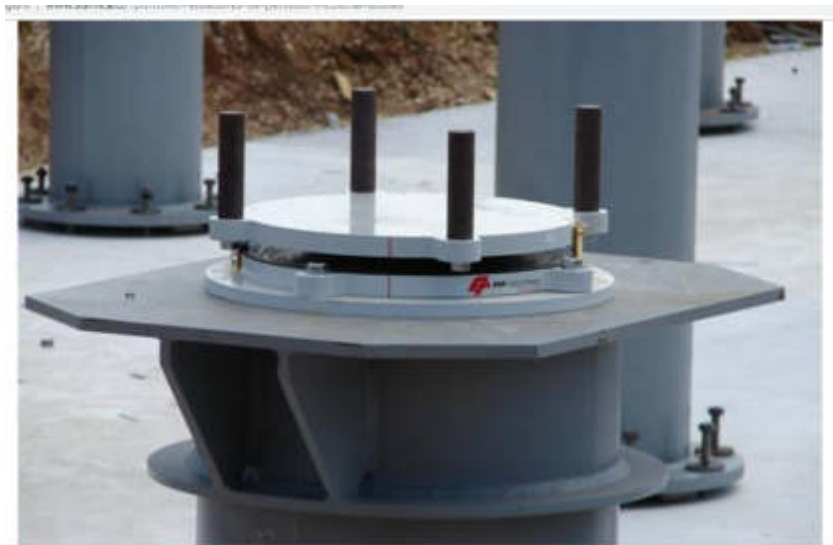
Figura 19: FPS instalado
