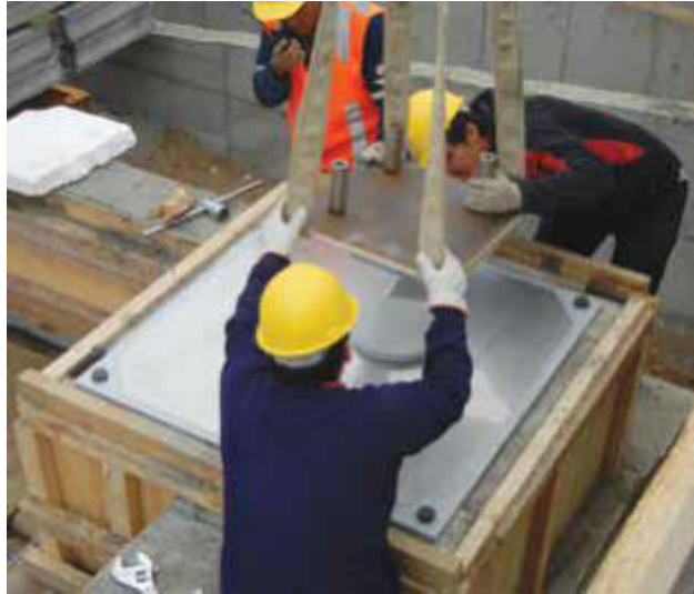
Figura 16: Correcta movilización de apoyos deslizantes planos.
