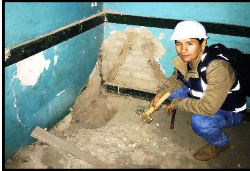
Figura 15. Recubrimiento de muros internos.
