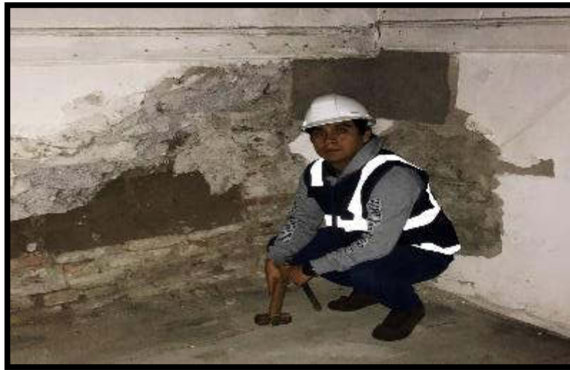
Figura 23. Sobrecimiento de ladrillo.
