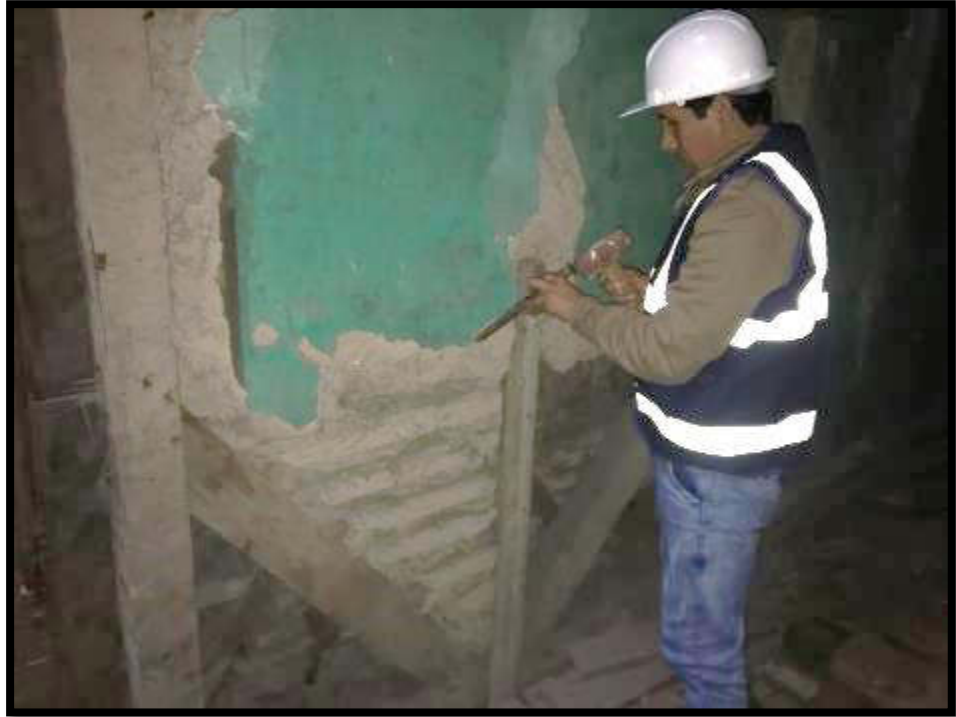
Figura 42. Muros de quincha.
