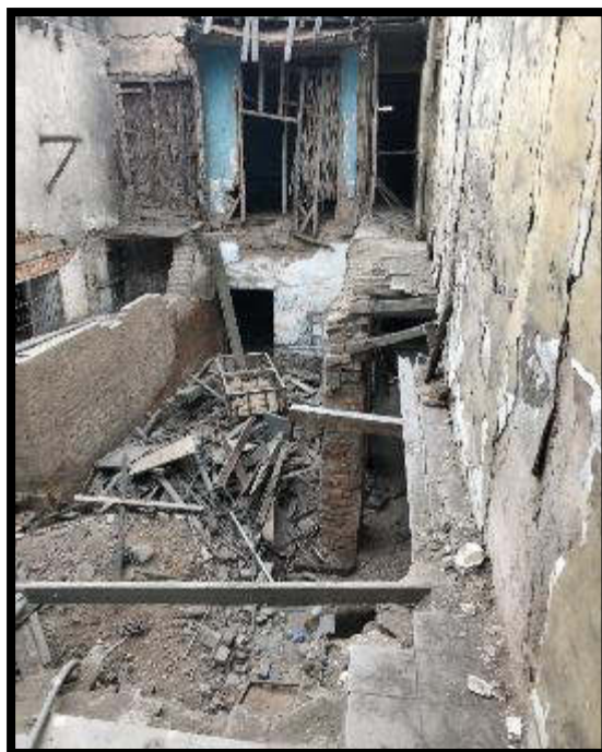
Figura 7. Sección colapsada.
