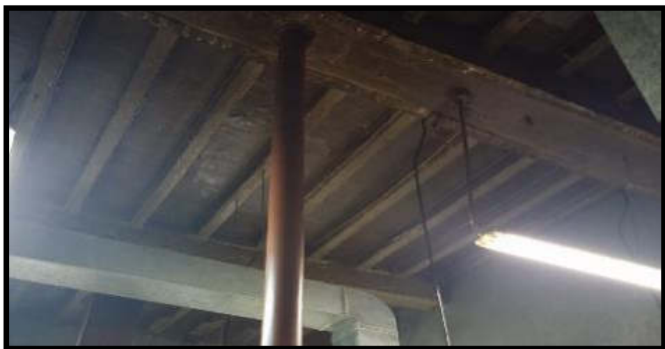
Figura 28. Vigas y viguetas de la cocina.
