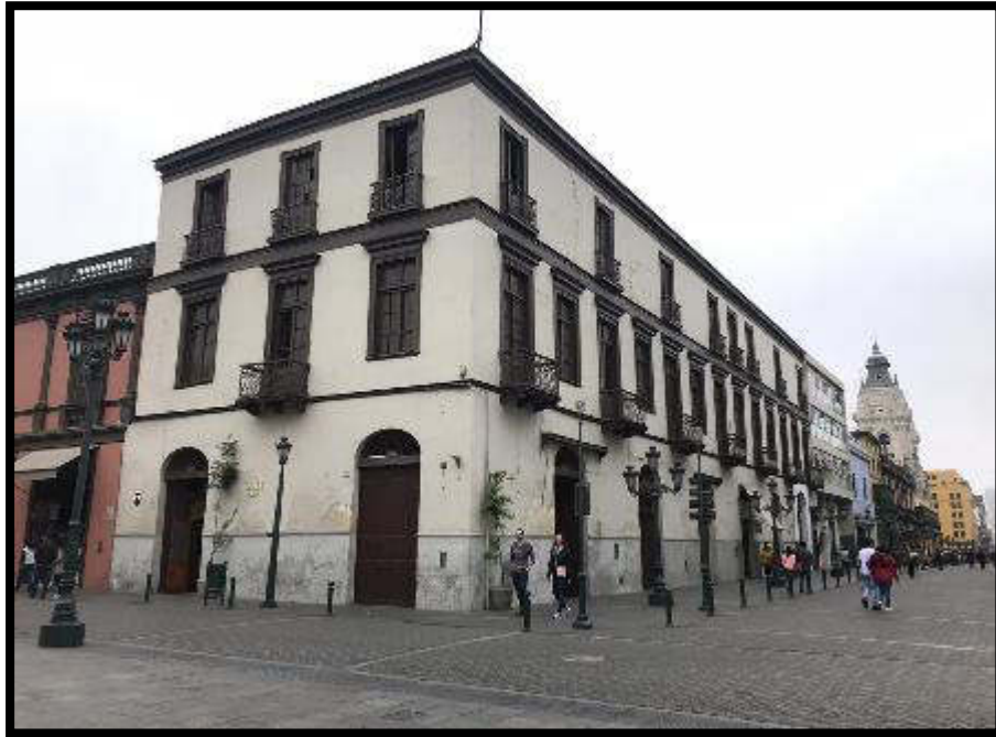
Figura 26. Edificación Hotel Comercio “El Cordano”.
