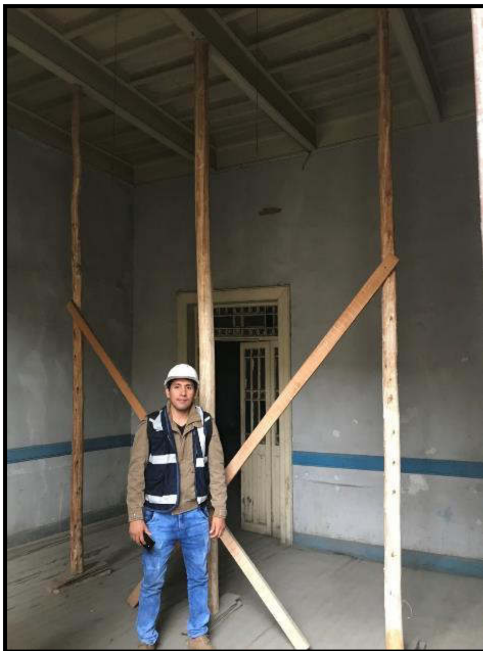
Figura 31. Techo sostenido por puntales.
