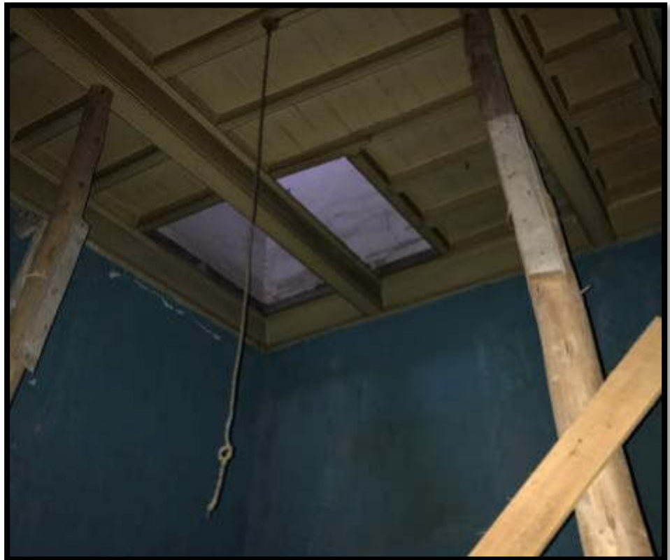
Figura 32. Puntales en la edificación.
