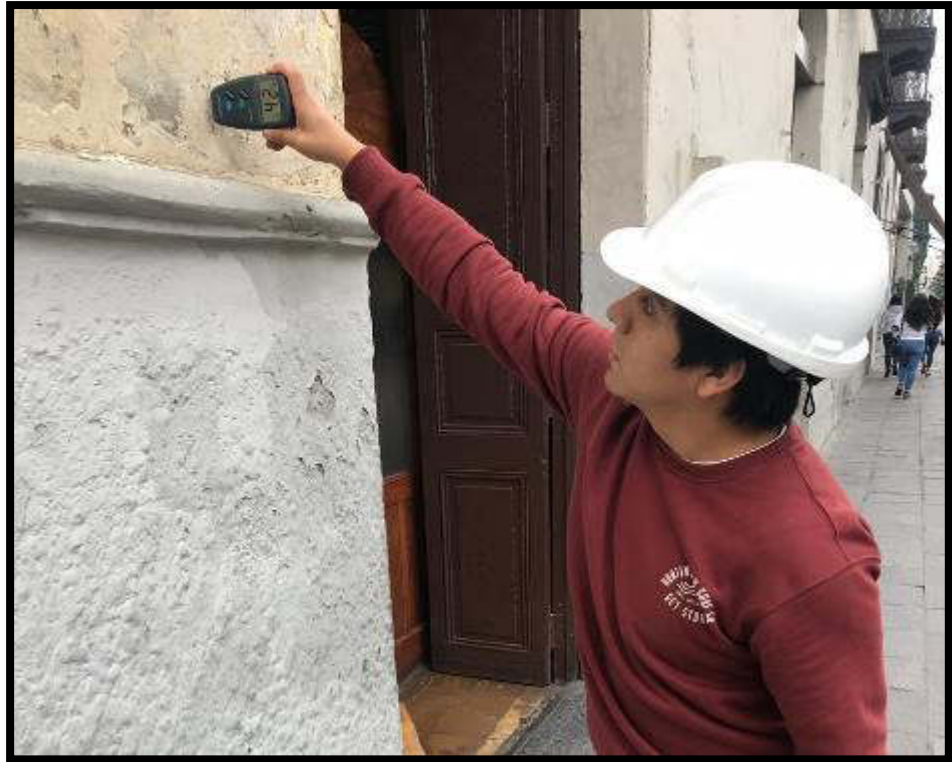
Figura 38. Medición de la humedad en fachada.
