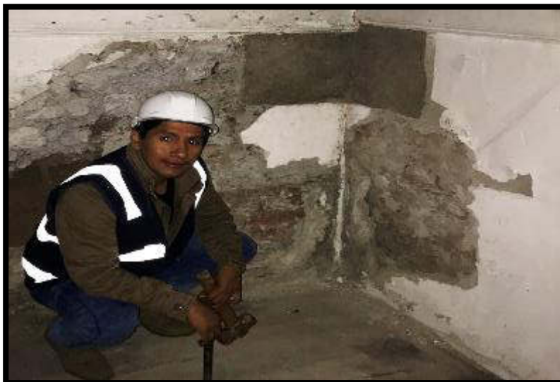
Figura 22. Sobrecimiento de ladrillo del primer nivel.
