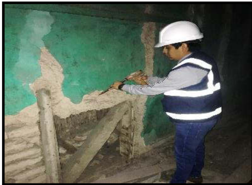
Figura 19. Recubrimiento de muros del segundo nivel.
