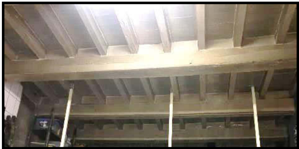
Figura 27. Vigas y Viguetas del depósito.
