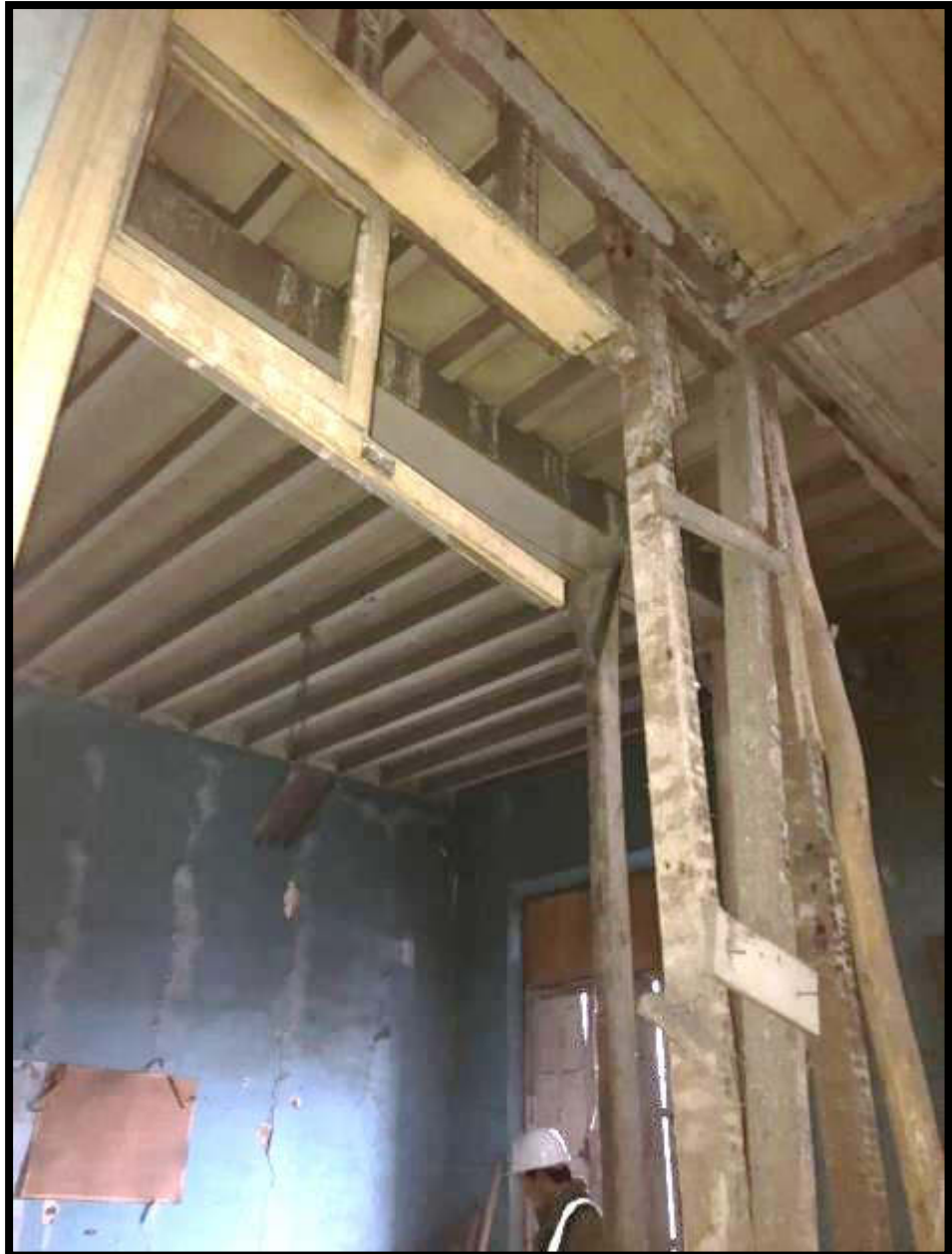
Figura 35. Puntales sosteniendo el techo del segundo nivel.
