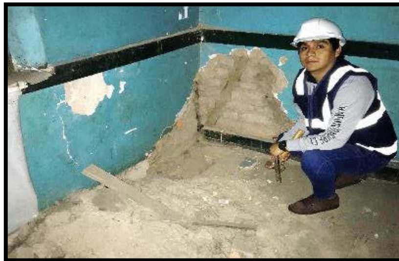
Figura 14. Recubrimiento de muros internos del segundo nivel.
