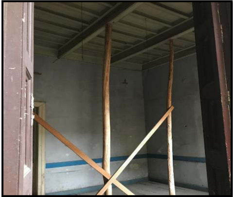
Figura 33. Las vigas están sostenidas por puntales.
