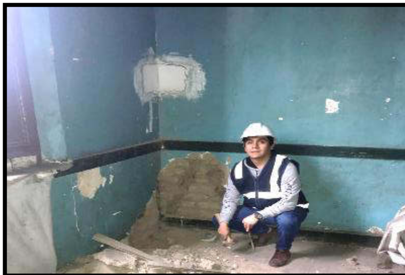
Figura 18. Recubrimiento del segundo nivel.
