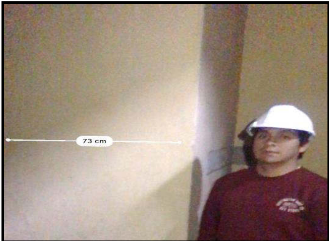
Figura 16. Espesor de muro de la fachada principal.
